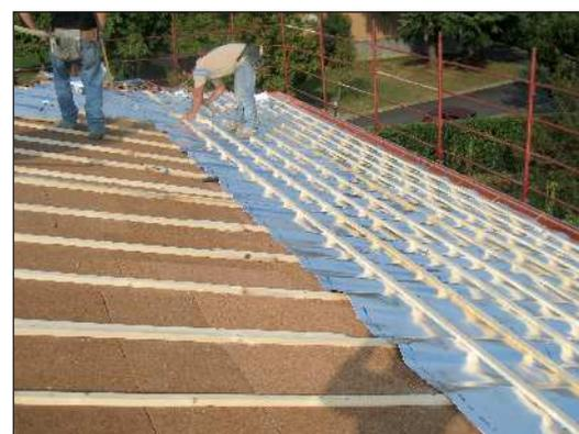
Isolamento realizzato con doppio strato di pannelli in sughero biondo naturale SoKoVerd.AF. Manto di copertura: coppi.
