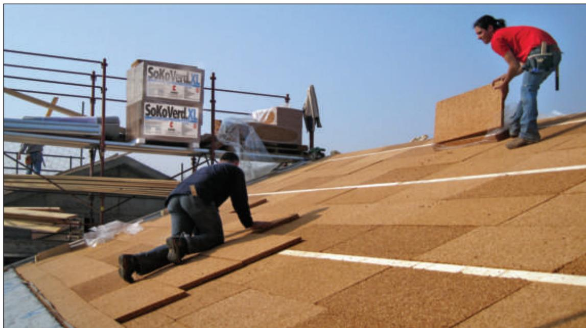
Copertura in legno ventilata mediante la posa di doppio strato in pannelli di sughero biondo naturale SoKoVerd.XL ad elevato spessore. Cantiere Via Lodovica a Oreno di Vimercate (MI). Impresa Restaura srl Vimercate (MI).
