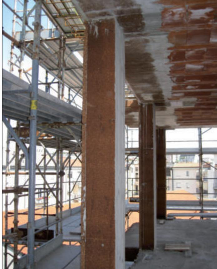
*Protezione termoigrometrica dei ponti termici, travi orizzontali e pilastri con pannelli in sughero biondo naturale compresso SoKoVerd.AF a grana media 4/8mm mediante getto in controscassero. L'isolamento in intercapedine è realizzato con pannelli in lana di pecora LanKot ad altro spessore. Cantiere Via Muratori 9 Milano - MI. Impresa Thema Costruzioni srl Milano.*
