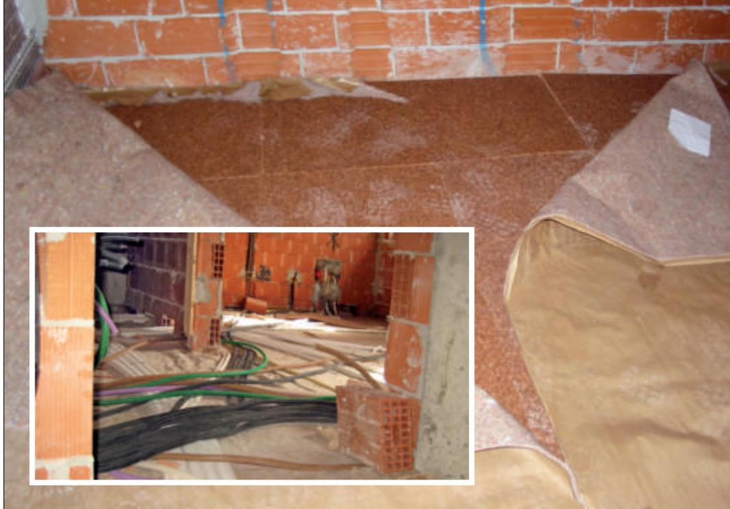
Sottofondo isolante termoacustico (specificatamente progettato per ridurre drasticamente i rumori da calpestio) costituito da strato di pannelli in sughero biondo naturale compresso SoKoVerd.AF a grana media 4/8mm, strato separatore anticalpestio KoSep.L. Al di sopra realizzazione degli impianti e caldaia in sabbia e cemento con il relativo pavimento. Cantiere Via Padre Ravasi Sesto San Giovanni (MI). Impresa Pro.edil srl.
