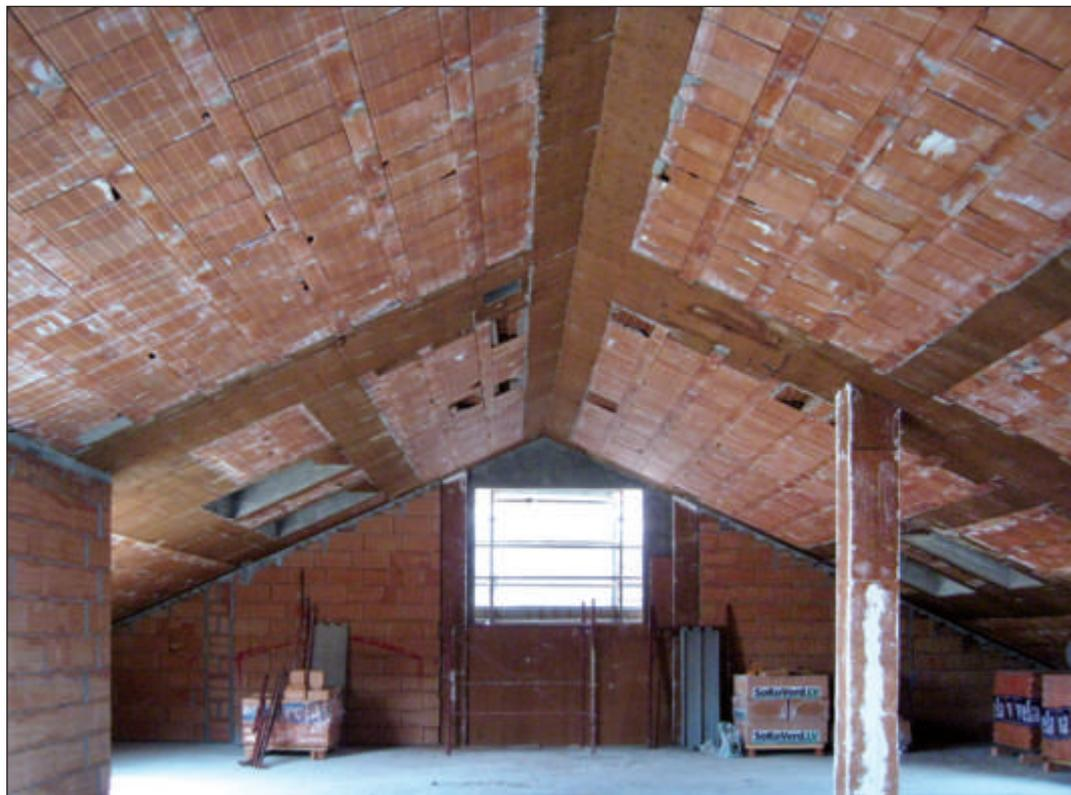
Protezione termoigrometrica nell'intradosso delle travi con pannelli in sughero biondo naturale superkompatto SoKoVerd.LV a grana fine 2/3mm mediante getto in controcassero e dei pilastri mediante rivestimento a cappotto dei pilastri. Cantiere Ponte d'Arena complesso residenziale nel centro storico di Monza - MI.
