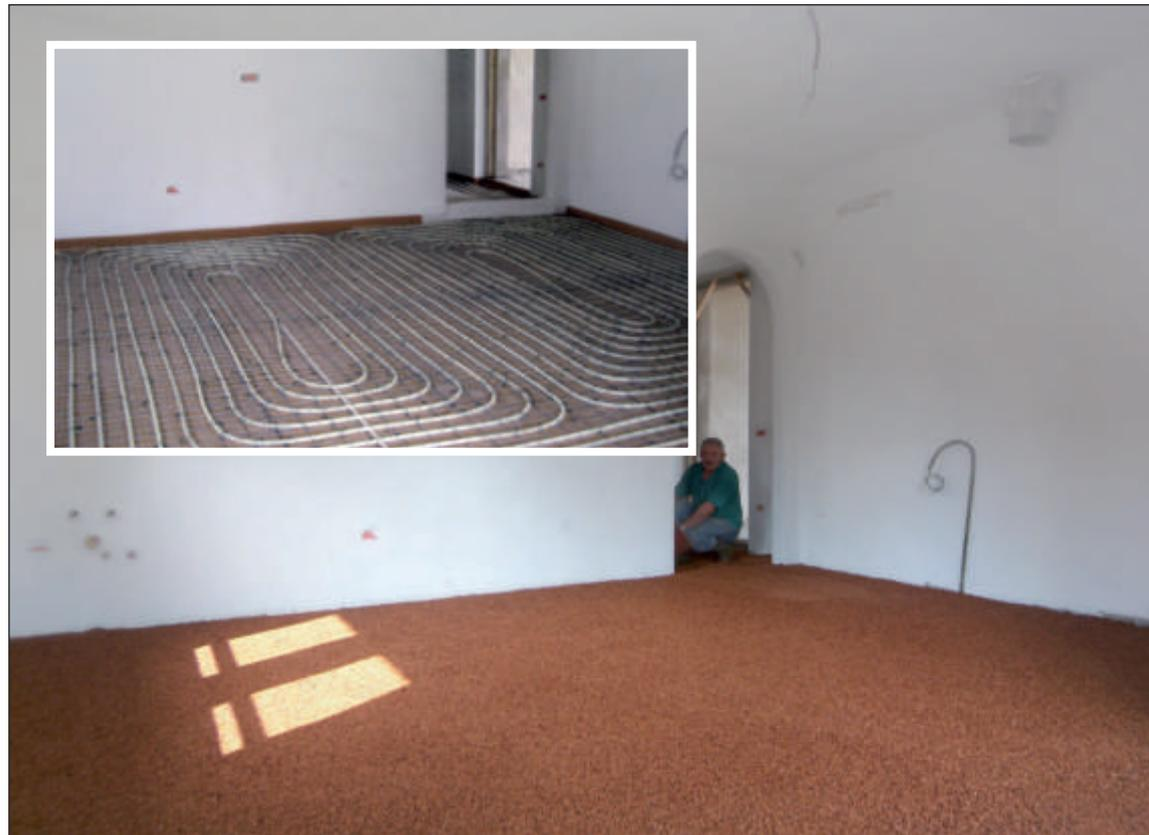
Particolare del sottofondo isolato mediante impasto di sughero biondo naturale bollito e ventilato SugheroLite Costante con legante vetrificante a presa aerea KoGlass di elevato spessore a copertura degli impianti. Al di sopra posa di strato separatore anticalpestio KoSep.L, rete elettrosaldata KoSteel con agganciate le tubazioni del riscaldamento a pavimento utilizzando clips e strisce KoFlex lungo il perimetro delle pareti.
