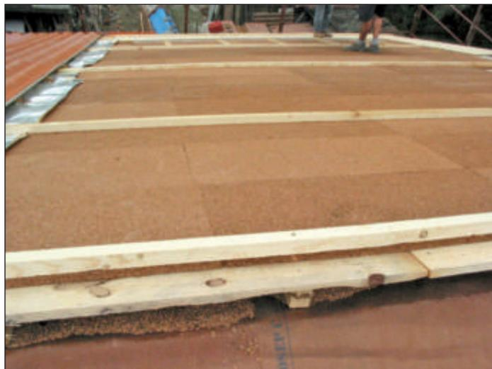
Copertura in legno con stesura sull'assito di carta oleata KoSep.C. Creazione di un secondo assito in legno distanziato da listoni con riempimento di granuli in sughero biondo naturale bollito e ventilato SugheroLite Costante 4mm. Sopra all'assito posa di pannello in sughero biondo naturale superkompatto SoKoVerd.LV a grana fine 2/3mm, listellatura in legno e carta alluminata KoSep.A.
