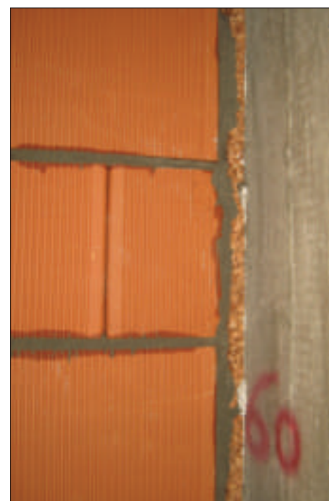
Parete divisoria costituita da blocchetti fonici in laterizio NK12L e NK8L con inserito nell'intercapedine doppio strato di ovatta vegetale KoFiVeg, pannello in sughero biondo naturale superkompatto SoKoVerd.LV a grana fine 2/3mm. Strisce in sughero biondo supercompreso KoFlex sotto e sopra i tavolati. Cantiere Ponte d'Arena complesso residenziale nel centro storico Monza. Impresa costruzioni Tonale.
