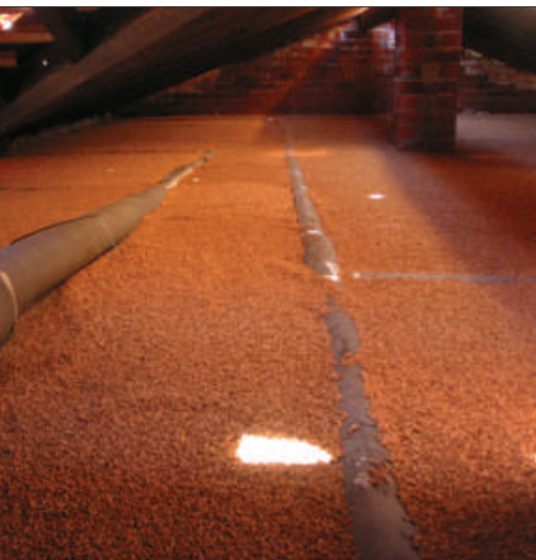
Isolamento del sottotetto eseguito utilizzando granuli in sughero biondo naturale bollito e ventilato SugheroLite Costante 4mm.
