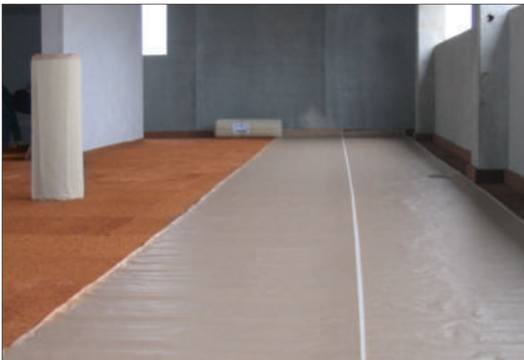
Sottofondo costituito da doppio strato di pannelli in sughero biondo naturale superkompacto SoKoVerd.LV a grana fine 2/3mm, strato separatore anticalpestio KoSep.L e strisce KoFlex lungo il perimetro delle pareti. Al di sopra si sono realizzati gli impianti idraulici ed elettrici e la formazione della caldana in sabbia e cemento con il relativo pavimento.
