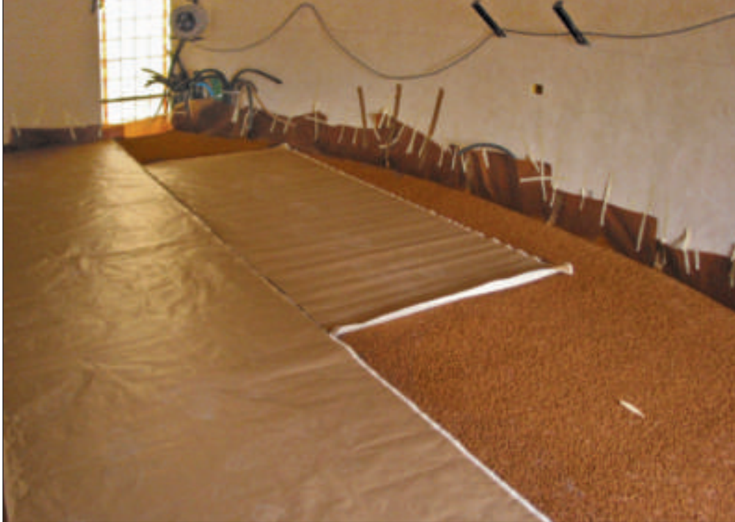
Solaio in legno con posa nell'estradosso di uno strato separatore KoSep.C, impasto di sughero biondo naturale bollito e ventilato SugheroLite Costante con legante vetrificante a presa aerea KoGlass e successiva posa dello strato separatore KoSep.L il tutto pronto per ricevere il pannello in legno KoSial e il pavimento in parquet.
