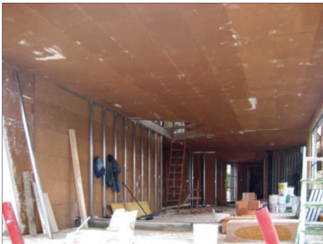
Rivestimento del soffitto e pareti mediante sistema a cappotto interno BioVerd in sughero biondo naturale SoKoVerd.LV
