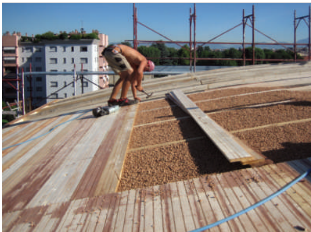
Copertura bioedile in legno. Creazione di un assito in legno distanziato da listoni con riempimento di granuli in sughero biondo naturale bollito e ventilato SugheroLite Costante 4mm. Edificio residenziale bioedile in Classe A+ Monza- MI. Progetto AB3 Architettura Battistoni Associati Monza.
