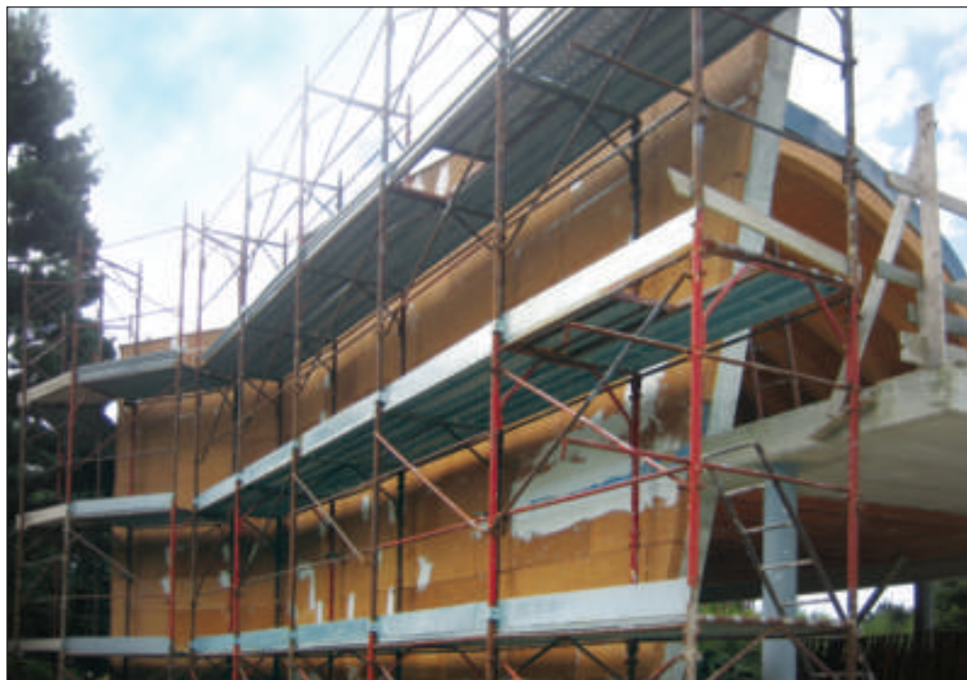
Rivestimento con sistema di isolamento termico a cappotto esterno BioVerd. Rivestimento eseguito con pannelli in sughero biondo superkompatto SoKoVrd.LV applicato con adesivo a presa rapida PraKov.
