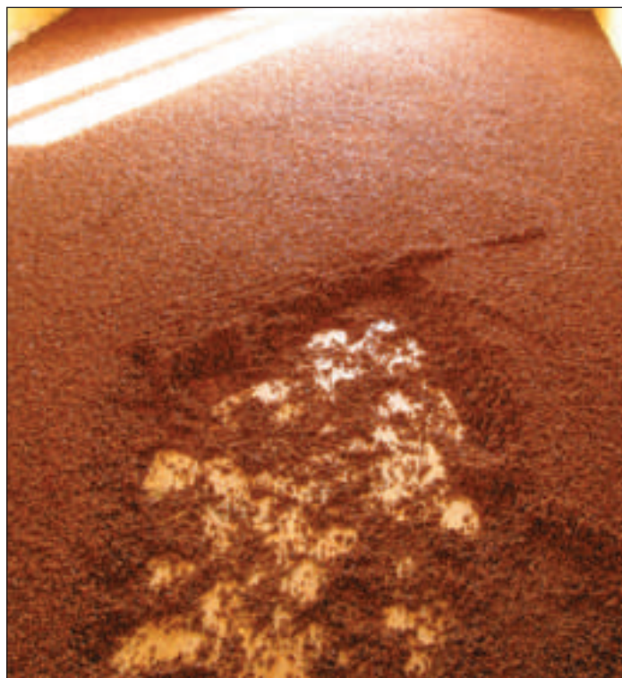
Particolare dell'impasto di sughero biondo naturale bollito e ventilato SugheroLite con legante vetrificante a presa aerea KoGlass eseguito in un sottofondo ad elevata spessore a copertura degli impianti.
