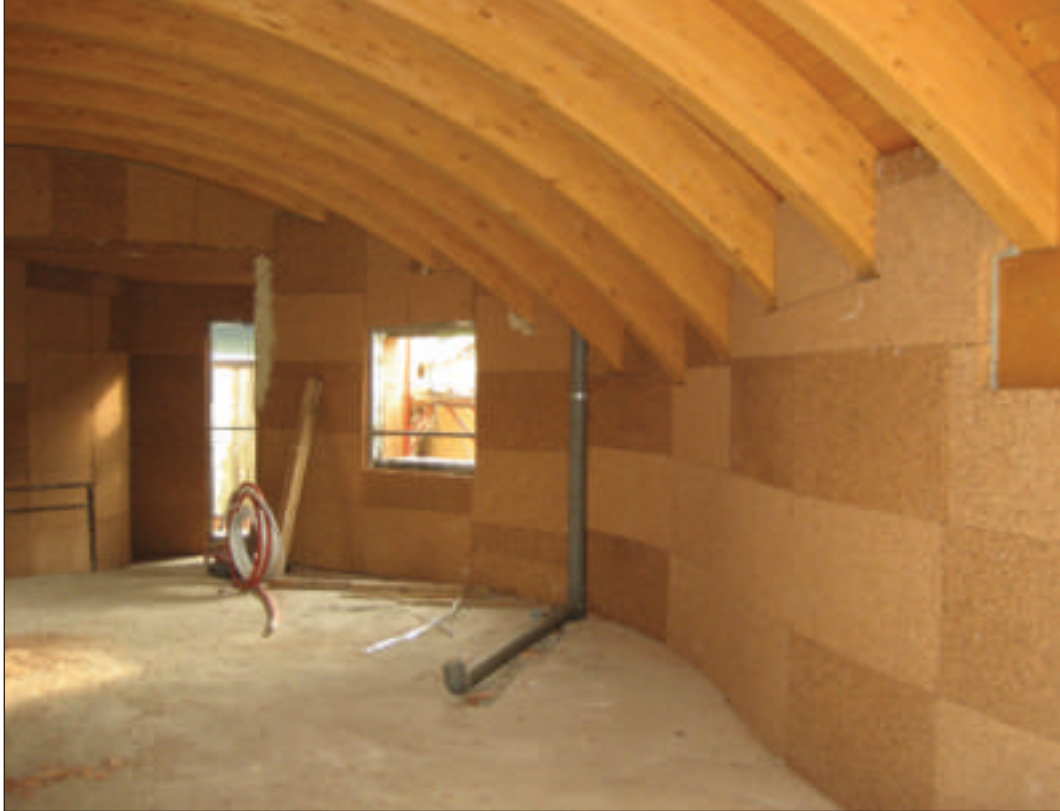
Rivestimento con sistema di isolamento termico a cappotto interno BioVerd. Rivestimento eseguito con pannelli in sughero biondo superkompatto SoKoVerd.LV applicato con adesivo a presa rapida PraKov.
