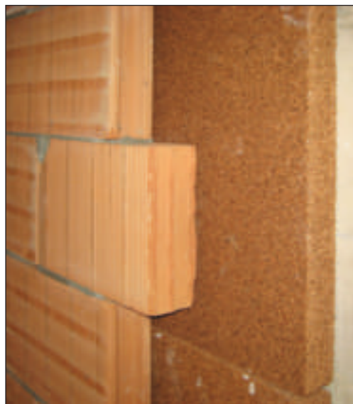
Protezione termoigrometrica del cemento armato mediante cappotto con pannelli in sughero biondo superkompatto SoKoVerd.LV a grana fine 2/3mm e controtravolato
