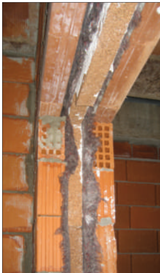
Parete divisoria costituita da blocchetti fonici in laterizio NK12L e NK8L con inserito nell'intercapedine doppio strato di ovatta vegetale KoFiVeg, pannello in sughero biondo naturale superkompatto SoKoVerd.LV a grana fine 2/3mm. Strisce in sughero biondo supercompreso KoFlex sotto e sopra i tavolati. Cantiere Ponte d'Arena complesso residenziale nel centro storico Monza. Impresa costruzioni Tonale.
