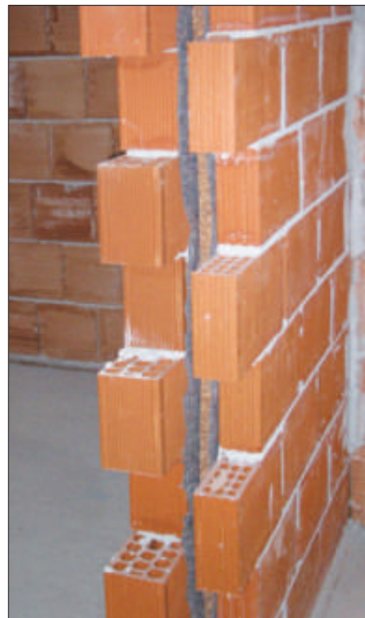
Parete divisoria costituita da blocchetti fonici in laterizio NK12L e NK8L con inserito nell'intercapedine doppio strato di ovatta vegetale KoFiVeg, pannello in sughero biondo naturale superkompatto SoKoVerd.LV a grana fine 2/3mm. Strisce in sughero biondo supercompreso KoFlex sotto e sopra i tavolati. Cantiere Ponte d'Arena complesso residenziale nel centro storico Monza. Impresa costruzioni Tonale.
