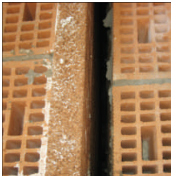
Isolamento posto nell'intercapedine realizzato con pannelli in sughero biondo naturale superkompatto SoKoVerd.LV a grana fine 2/3mm
