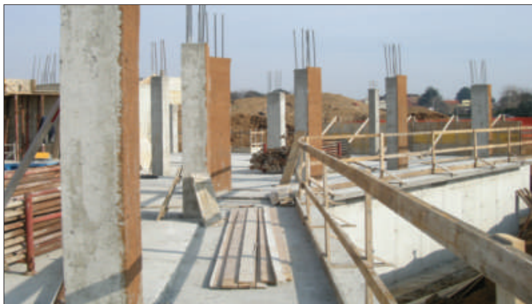
Protezione termoigrometrica dei ponti termici sulla faccia esterna dei pilastri con pannelli in sughero biondo naturale compresso SoKoVrd.AF a grana media 4/8mm.
