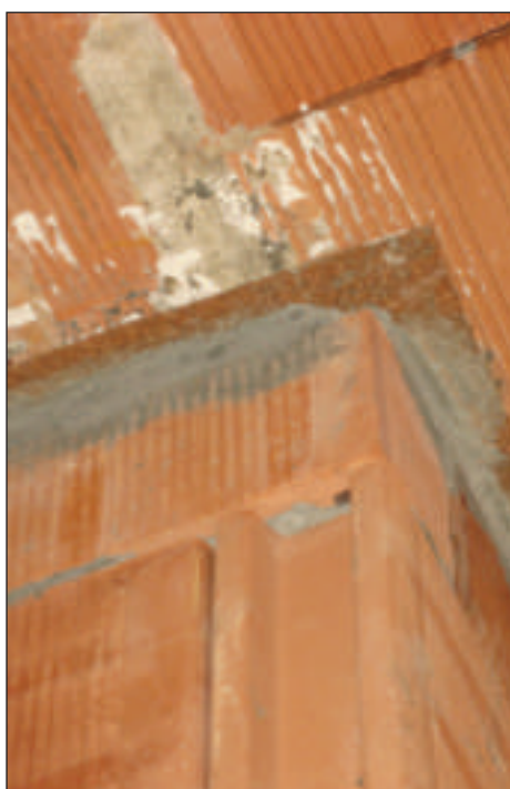
Parete divisoria costituita da blocchetti fonici in laterizio NK12L e NK8L con inserito nell'intercapedine doppio strato di ovatta vegetale KoFiVeg, pannello in sughero biondo naturale superkompatto SoKoVerd.LV a grana fine 2/3mm. Strisce in sughero biondo supercompreso KoFlex sotto e sopra i tavolati. Cantiere Ponte d'Arena complesso residenziale nel centro storico Monza. Impresa costruzioni Tonale.
