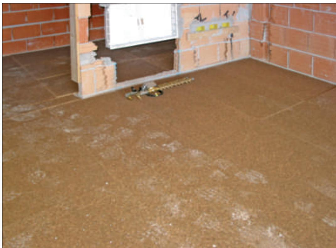
Sottofondo costituito da pannelli in sughero biondo naturale superkompatto SoKoVerd.LV a grana fine 2/3mm, posato prima degli impianti
