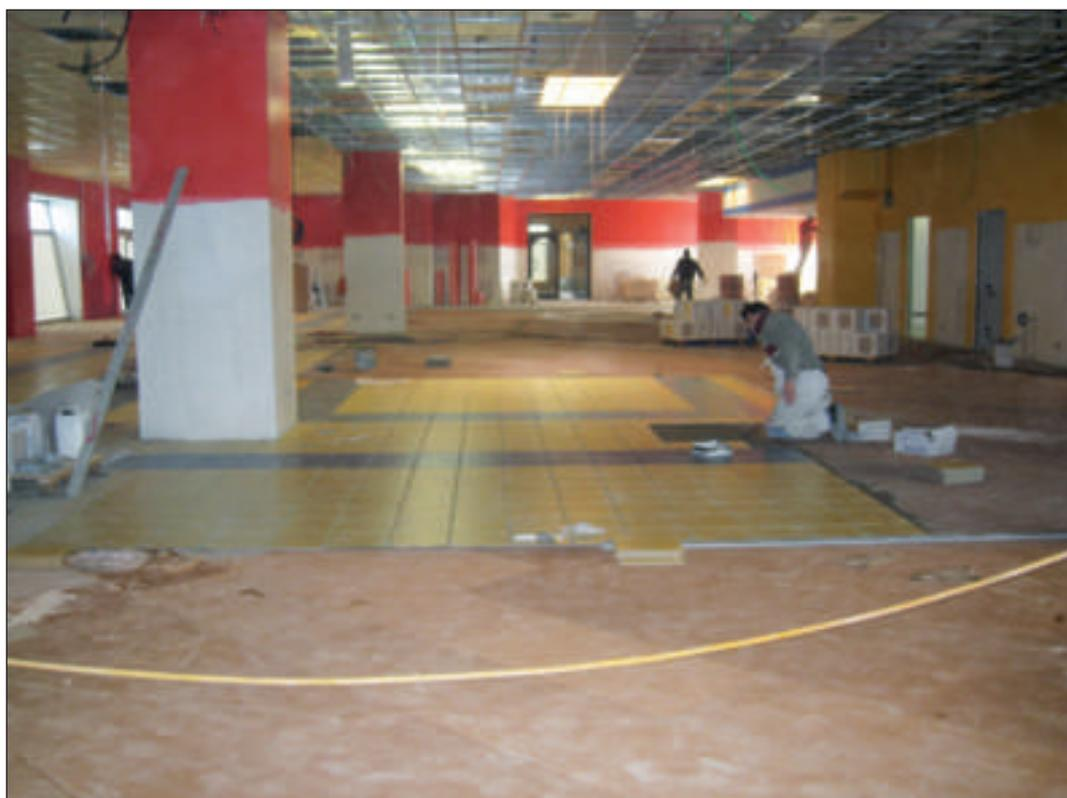
Una delle molteplici tecnologie applicative Coverd nel caso in cui non si sia raggiunto, in fase di esecuzione, gli indici richiesti dal DPCM 05/12/1997 per i rumori di calpestio. Pannelli in sughero biondo naturale superkompatto SoKoVerd.LV dallo spessore 1cm incollati sul massetto con adesivo a presa rapida PraKov e successiva posa delle piastrelle. Le piastrelle sono state incollate direttamente sul pannello di sughero.
