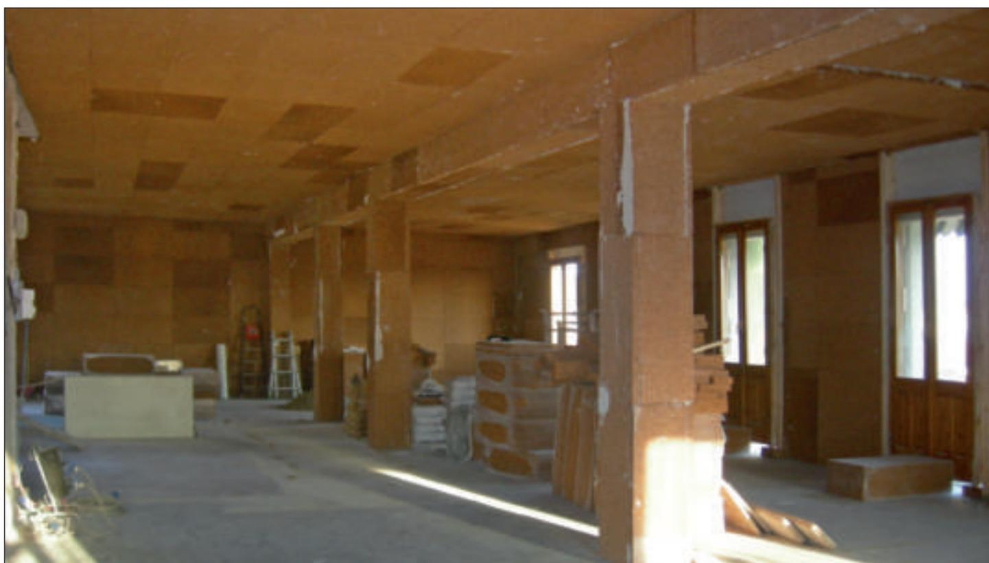
Esempio realizzativo di un singolo alloggio a basso consumo energetico in Classe A all'interno di un edificio residenziale in fase di ristrutturazione, utilizzando le tecnologie applicative e i materiali naturali di Coverd a parete, soffitto e pavimento
