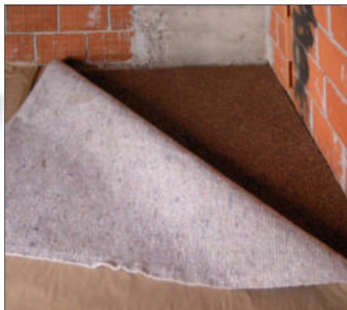
Particolare del sottofondo costituito da pannelli in sughero biondo naturale superkompatto SoKoVerd.LV a grana fine 2/3mm, strato separatore anticalpestio KoSep.L per la successiva posa degli impianti
