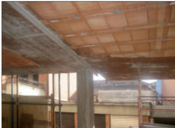
*Protezione termoflussimetrica dei ponti termici con pannelli in sughero biondo naturale compresso SoKoVerd.LV nell'intradosso delle travi orizzontali*
