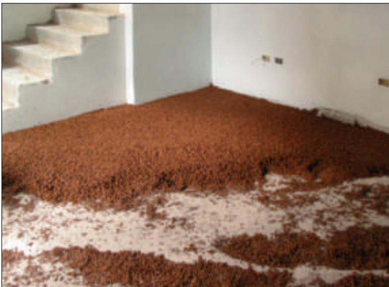
Sottofondo ad alto spessore costituito da impasto di sughero biondo naturale bollito e ventilato SugheroLite con legante vetrificante a presa aerea KoGlass a copertura degli impianti.
