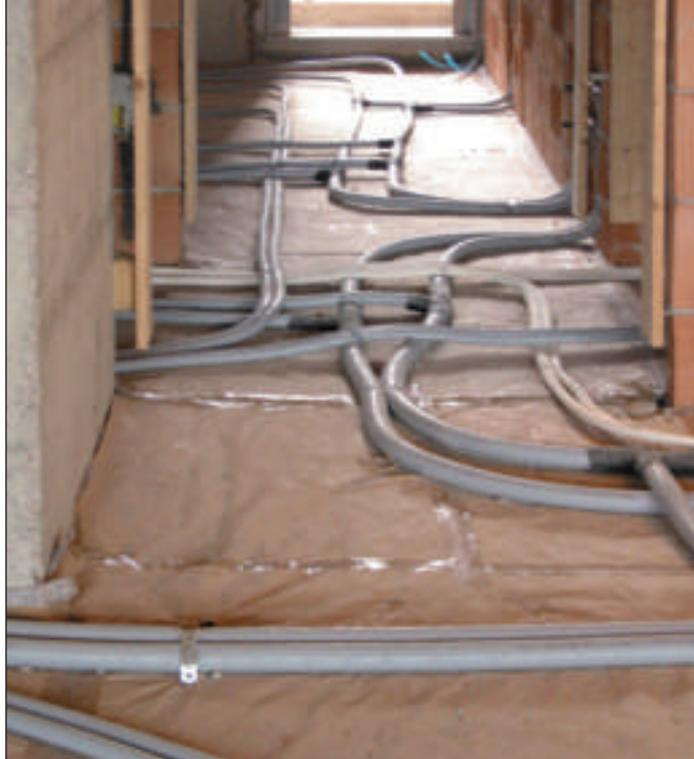
Posa degli impianti al di sopra del pacchetto isolante con pannelli in sughero biondo naturale superkompatto SoKoVerd.LV a grana fine 2/3mm e strato separatore anticalpestio KoSep.L risvoltato sulle pareti pronto per la realizzazione della caldana in sabbia e cemento con il relativo pavimento
