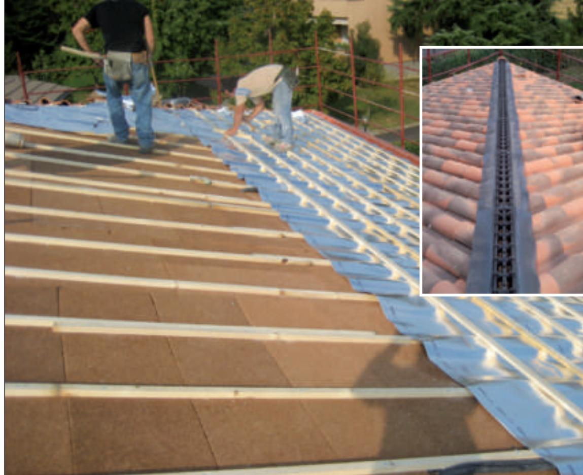
Copertura in legno con stesura di calta oleata KoSep.C, doppio strato di pannelli in sughero biondo naturale superkompatto SoKoVerd.LV a grana fine 2/3mm, listellatura per la ventilazione con inserimento dello strato separatore KoSep.A. Posa del manto di copertura con porta colmo ventilato KolVent.
