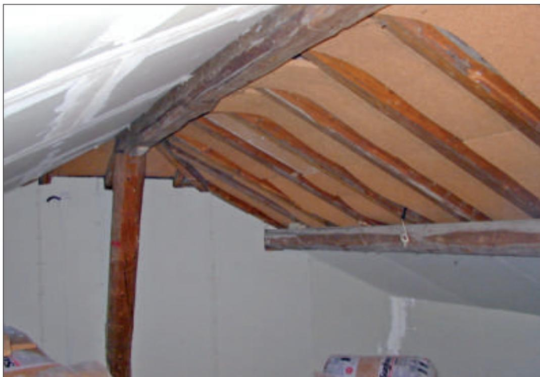
Recupero sottotetto. Posa su struttura in legno di doppio strato in pannelli di sughero biondo naturale superkompatto SoKoVerd.LV e finitura in cartongesso
