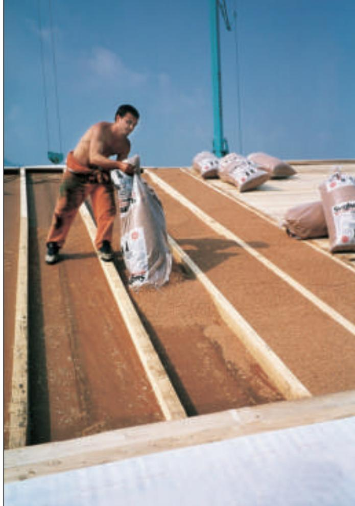
Copertura in legno con stesura sull'assito di carta oleata KoSep.C. Creazione di un secondo assito in legno distanziato da listoni con riempimento di granuli in sughero biondo naturale bollito e ventilato SugheroLite Costante 4mm.
