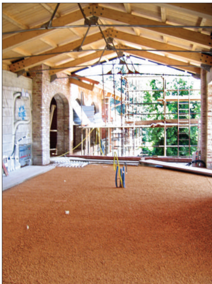
Ristrutturazione dei solai mediante la posa impasto di sughero biondo naturale bollito e ventilato SugheroLite Costante con legante vetrificante a presa aerea KoGlass di elevato spessore a copertura degli impianti.
