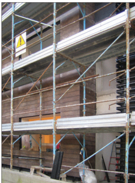
Rivestimento a cappotto BioVerd in sughero biondo naturale SoKoVerd.LV applicato alla parete esterna con adesivo PraKov. Successiva intonacatura di spessoramento utilizzando KoMalt.G e pitturazione di colore nero. In una seconda fase si è realizzata una struttura metallica per la formazione della facciata ventilata con applicazione fugata delle lastre in ceramica. La pitturazione del colore nero si è resa necessaria per mimetizzare la fuga tra una lastra e l'altra. La struttura metallica è stata realizzata in un secondo momento senza preventiva applicazione di sottostrutture o tasselli di richiamo.
