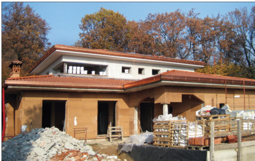
Ristrutturazione delle facciate mediante rivestimento a cappotto in sughero biondo naturale prebollito BioVerd.
