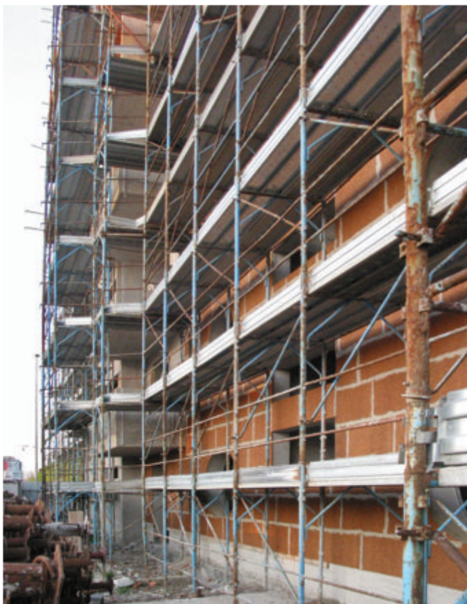
Fasi di lavorazione della facciata ventilata con rivestimento a cappotto in sughero BioVerd, struttura metallica e finitura con lastre in ceramica.
