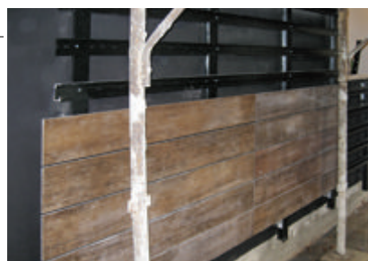
Fasi di lavorazione della facciata ventilata con rivestimento a cappotto in sughero BioVerd, struttura metallica e finitura con lastre in ceramica.
