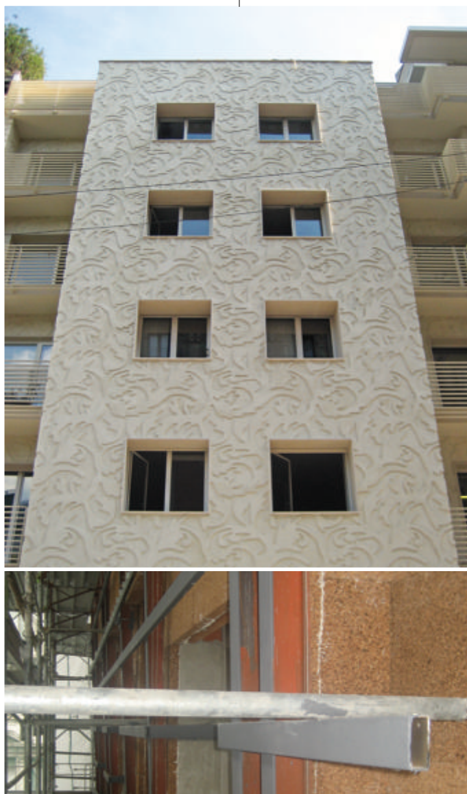
Rivestimento a cappotto BioVerd in sughero biondo naturale superkompattato SoKoVerd.LV applicato alla parete esterna con adesivo a presa rapida PraKov. In una seconda fase si è realizzata una struttura metallica per la formazione della facciata ventilata inclinata con applicazione delle lastre in cemento rinforzato. Al di sopra della facciata per la protezione termo-igrometrica si è realizzato un ulteriore rivestimento in sughero biondo con intonaco di spessoramento KoMalt.G e successiva fase realizzativa della decorazione in rilievo tridimensionale con finitura in cemento rinforzato applicato a spruzzo.
