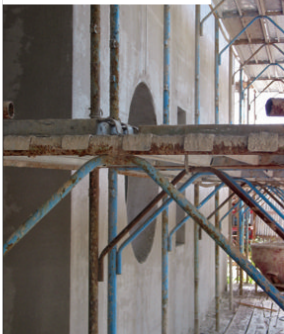
Rivestimento a cappotto BioVerd in sughero biondo naturale SoKoVerd.LV applicato alla parete esterna con adesivo PraKov. Successiva intonacatura di spessoramento utilizzando KoMalt.G e pitturazione di colore nero. In una seconda fase si è realizzata una struttura metallica per la formazione della facciata ventilata con applicazione fugata delle lastre in ceramica. La pitturazione del colore nero si è resa necessaria per mimetizzare la fuga tra una lastra e l'altra. La struttura metallica è stata realizzata in un secondo momento senza preventiva applicazione di sottostrutture o tasselli di richiamo.
