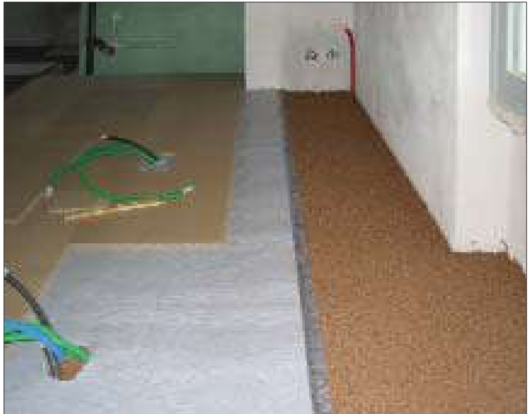
Particolare sottofondo leggero con impasto di sughero biondo naturale bollito e ventilato Sugherolite con vetrificante a presa aerea Koglass, strato separatore anticallpestio KoSep.F e pannelli di legno idrofugo KoSial.
