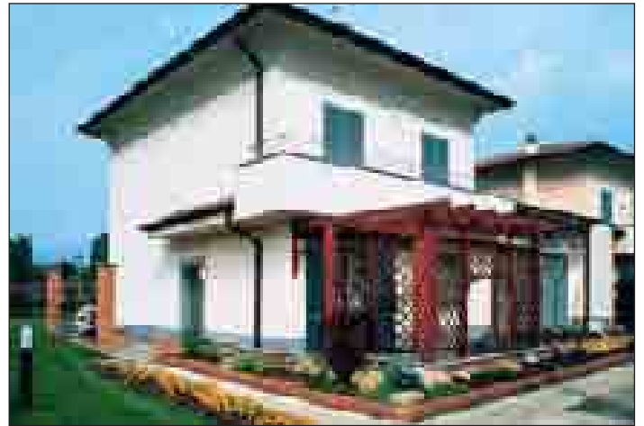
Lavoro ultimato con finitura colorata ai silicati di potassio KoSil
