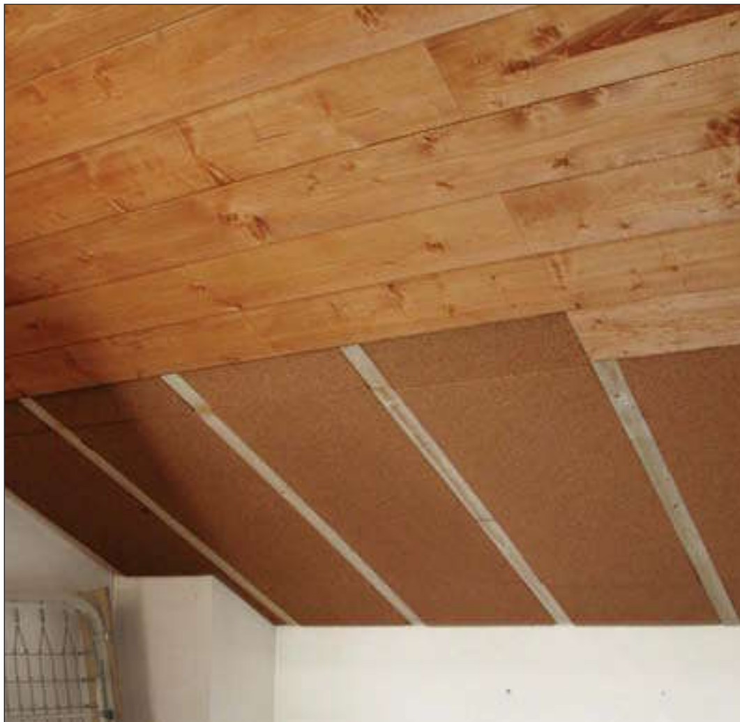
Posa su struttura in legno di doppio pannello in sughero biondo naturale superkompatto SoKoVerd.LV spessore 3+3cm e pertine in legno
