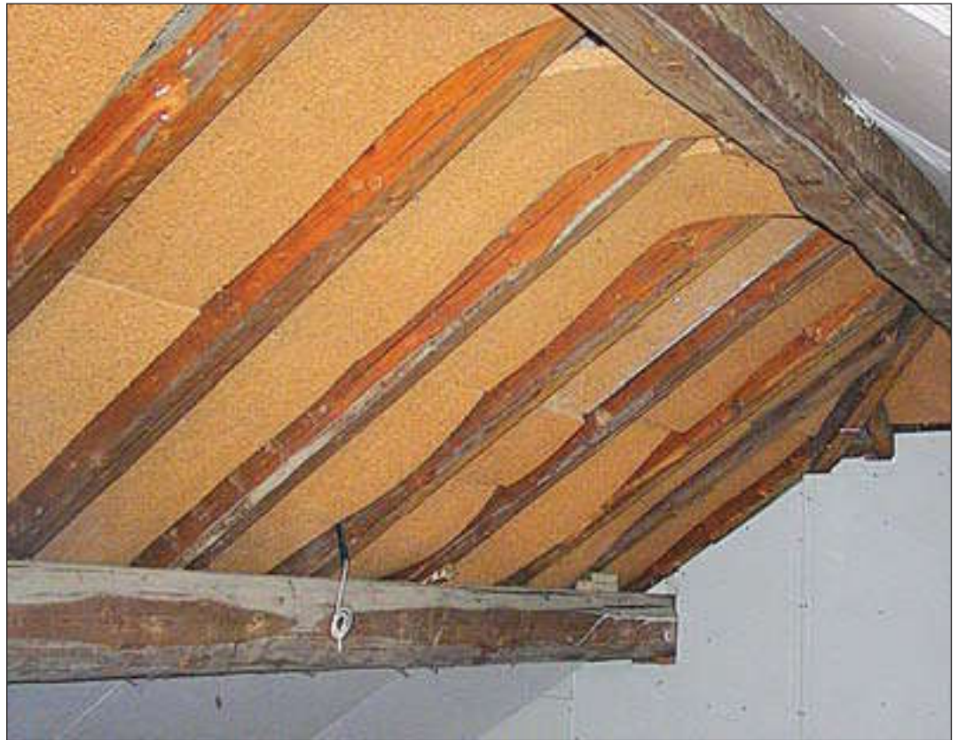
Posa su struttura in legno di doppio pannello in sughero biondo naturale superkompatto SoKoVerd.LV spessore 3+3cm. Realizzazione finiture in cartongesso.
