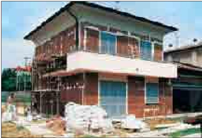
Fase di ancoraggio pannelli in sughero SoKoVerd.LV
