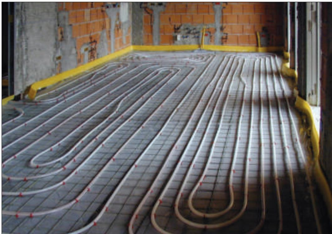
Posa dello strato separatore anticalpestio KoSep.F e rete elettrosaldata KoSteel con sovrastante tubazione del riscaldamento a pavimento
