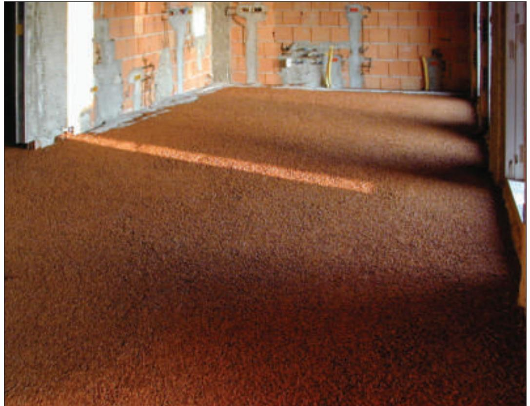
*Particolare di posa della fase di stesura e stagionatura dell'impasto di sughero biondo naturale bollito e ventilato Sugherolite con legante a presa aerea KoGlass quale sottofondo isolante atto a ricevere la tubazione dell'impianto di riscaldamento a pavimento*
