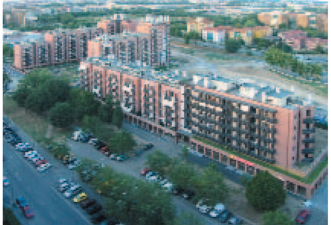
Vista aerea del complesso residenziale Cooperativa Solidarnosc di piazzale Bologna (Milano)
