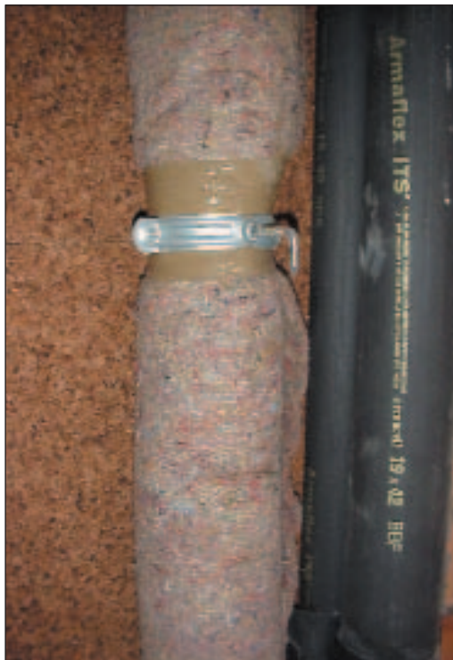
Particolare fasciatura impianti con sandwich di ovatta vegetale con anima di laminato smorzante FoniVeg
