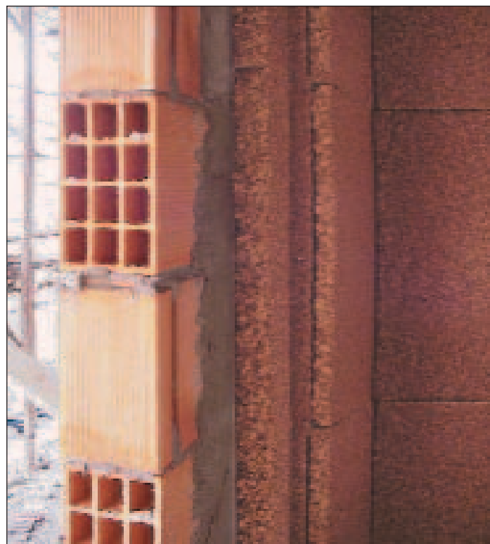
Particolare intercapedine con pannelli in sughero biondo naturale compresso SoKoVerd.AF
