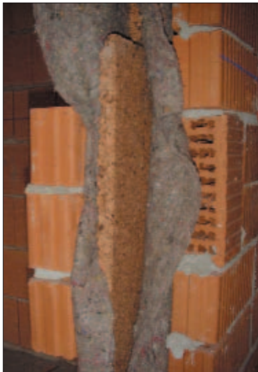
Particolare parete divisoria costituita da due tavolati NKS, doppio strato di ovatta vegetale KoFiVeg, pannello in sughero biondo naturale compresso SoKoVerd.AF e strisce in sughero supercompresso KoFlex sotto e sopra i tavolati
