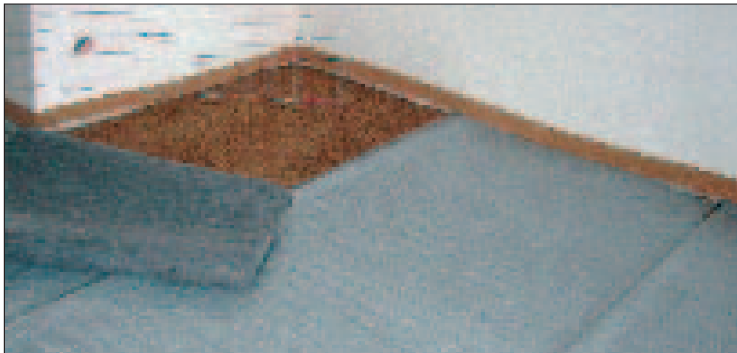
Particolare di sottofondo eseguito con l'impasto di SugheroLite+KoGlass, strato separatore anticalpestio KoSep.F, rete elettrosaldata KoSteel, completo di strisce in sughero supercompresso KoFlex lungo il perimetro del locale
