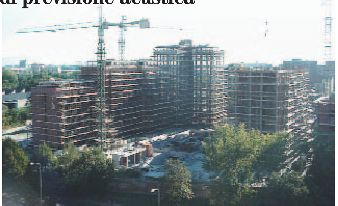
Vista cantiere in costruzione Cooperativa Solidarnosc di piazzale Bologna (MI). Impresa costruttrice P.F.B. Spa Abbiategrasso (MI)
