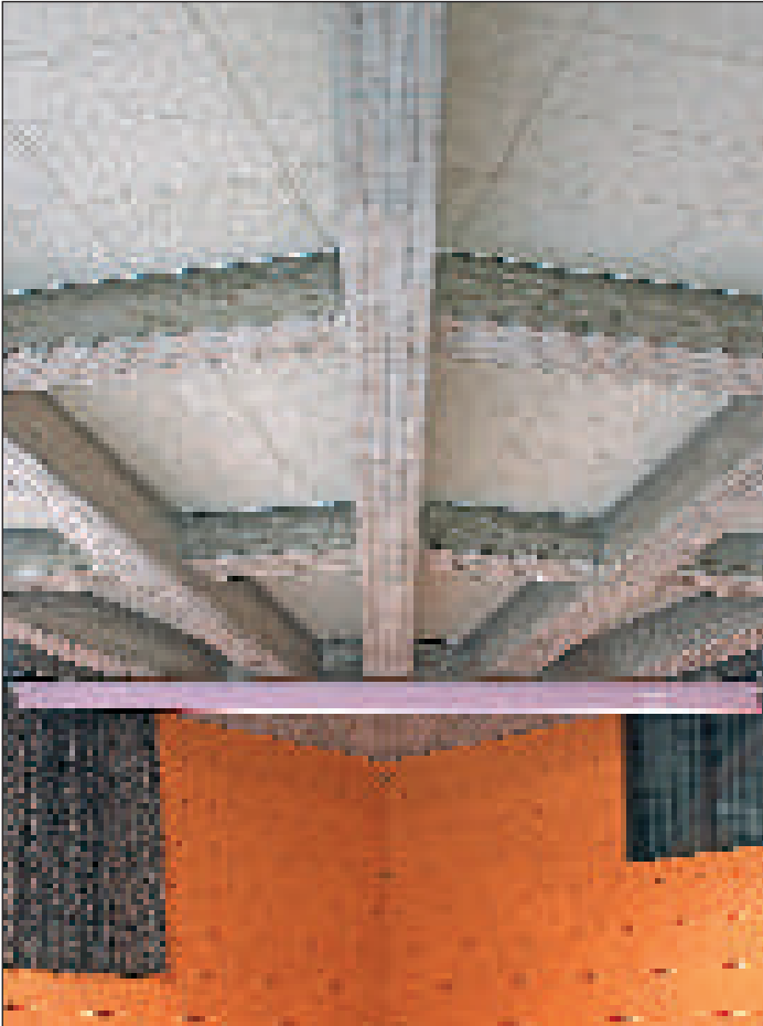
Particolare del rivestimento soffitto e pareti con pannelli in sughero biondo naturale preformato e pretinteggiato SoKoVerd.C1 - Progetto Arch. Bruna Galbusera Vimercate - MI
