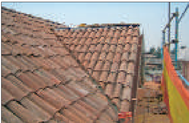
Particolari della copertura con coppi recuperati dalla dismissione di edifici rurali del basso Polesine (Rovigo). Vista del portacolumo ventilato KolVent. I canali di gronda sono stati riproposti in rame invecchiato ed è stato eseguito il restauro del cipollone in rame
