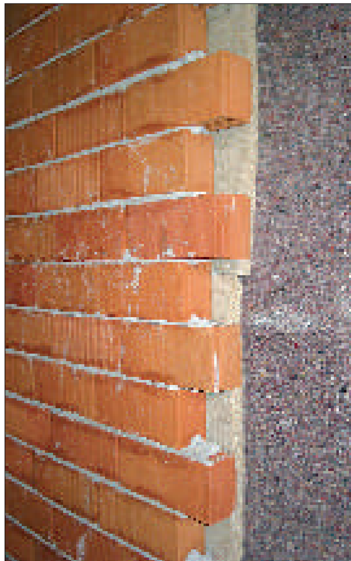
Particolare parete divisoria costituita da due tavolati in blocchetti fonici NK8, lana di pecora LanKot, sandwich di ovatta vegetale con anima di laminato smorzante FoniVeg e strisce in sughero supercompresso KoFlex sotto e sopra i tavolati.
