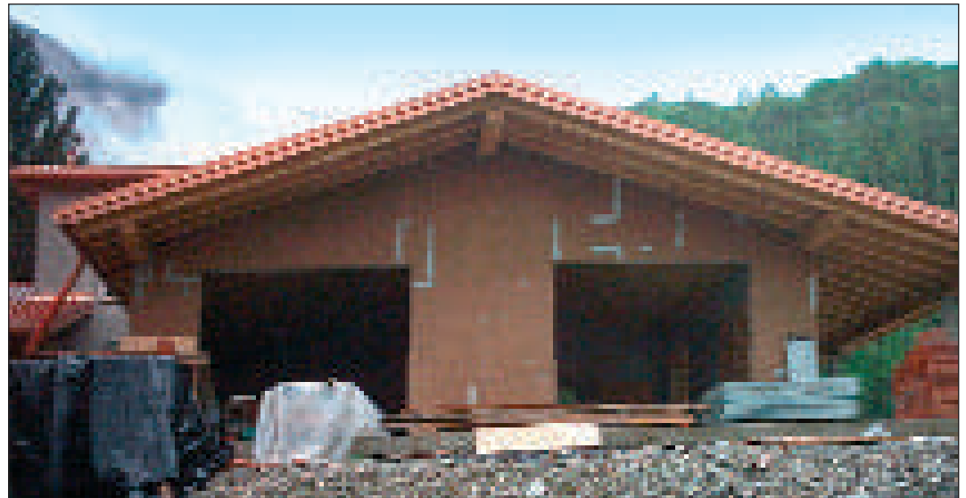
Rivestimento a cappotto esterno con ancoraggio pannelli in sughero biondo naturale superkompatto SoKoVerd.LV a grana fine 2/3mm
