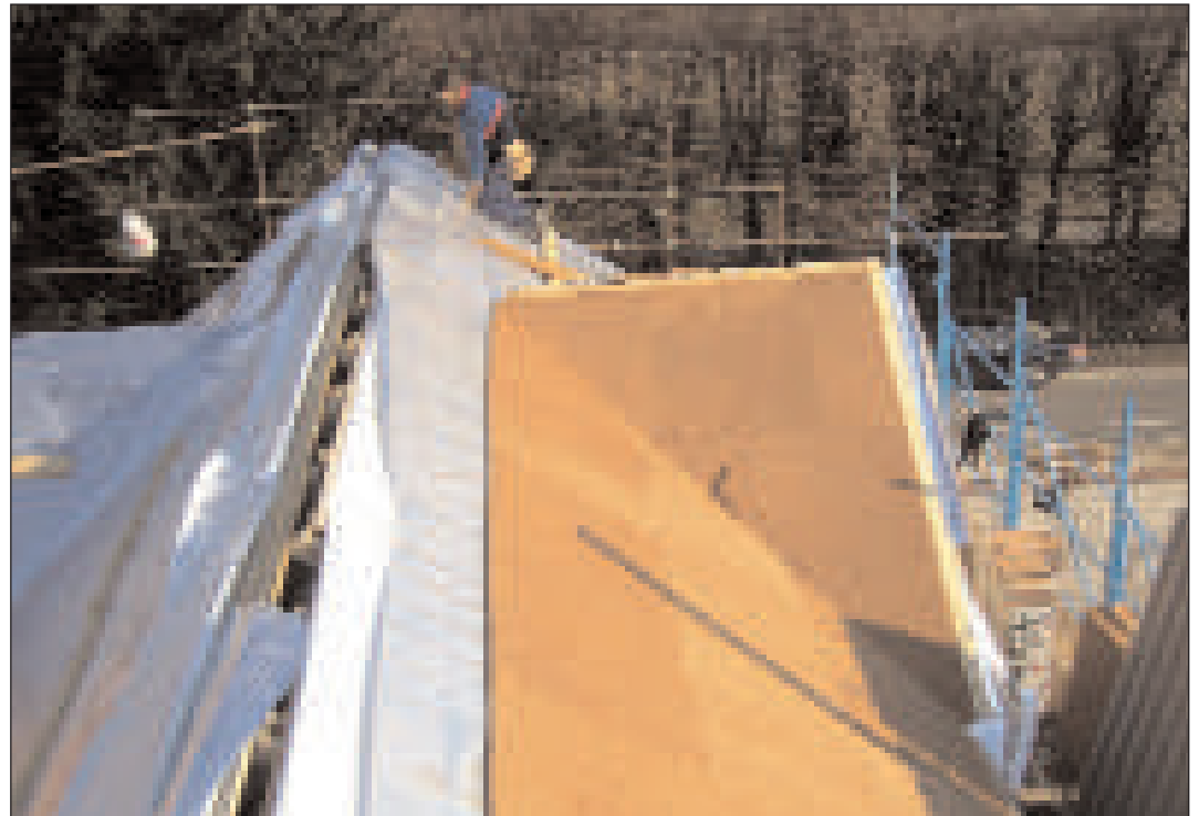
Tetto bioedile in legno con stesura di strato separatore termoriflettente KoSep.A, strato di pannelli in sughero biondo naturale superkompatto SoKoVerd.LV a grana fine 2/3mm e ulteriore strato separatore termoriflettente di carta alluminata KoSep.A
