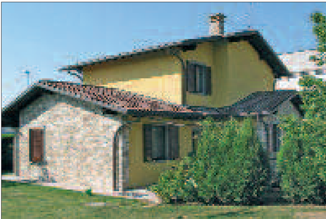
Esecuzione intonaco di finitura colorata ai silicati di potassio KoSil
