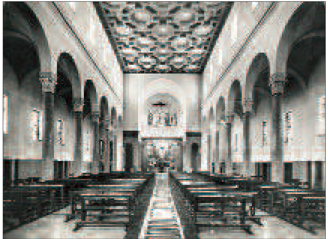
Collegio Leone XIII Milano - Prima dell'intervento
