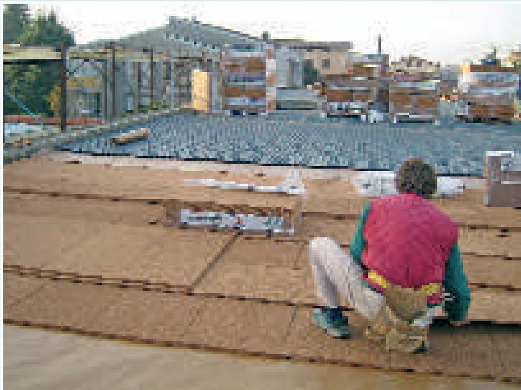
Copertura piana ventilata con posa di carta oleata KoSep.C, posa triplo strato di pannelli in sughero biondo naturale superkompatto SoKoVerd.LV a grana fine 2/3mm per uno spessore complessivo di 10cm ed un altro strato di carta oleata KoSep.C. Posa di pannelli preformati dallo spessore di 3cm per creare la ventilazione.
