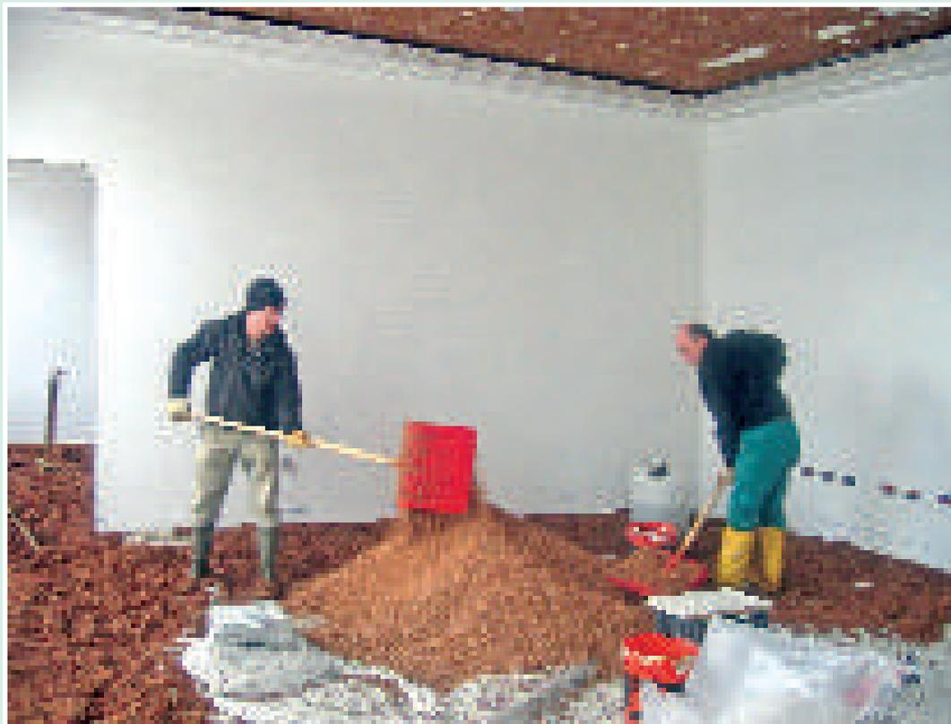
Fase di realizzazione dell'impasto di sughero biondo naturale bollito e ventilato SugheroLite con legante vetrificante a presa aerea KoGlass a copertura degli impianti
