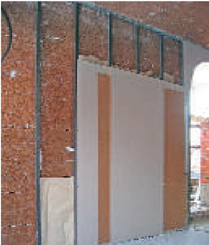
Particolare di contro parete costituita da pannelli in sughero biondo naturale superkompattato SoKoVerd.LV a grana fine 2/3mm e pannelli di lana di pecora LanKot con finitura in cartongesso interponendo un foglio di sughero KoFlex tra le due lastre.
