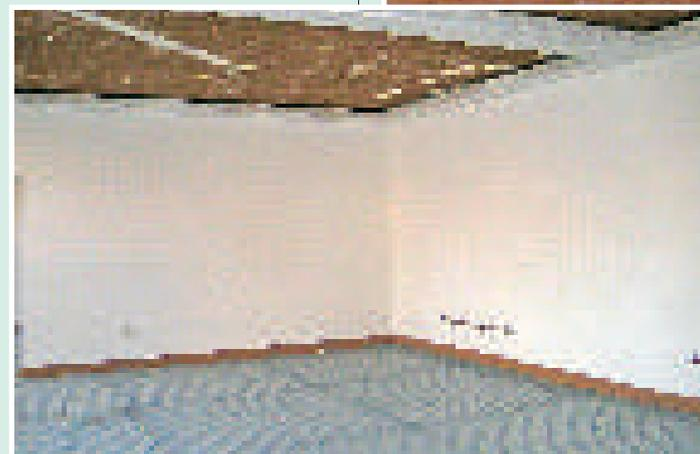
Particolare di posa dello strato separatore anticalpestio KoSep.F, rete elettrosaldata KoSteel e strisce in sughero KoFlex lungo il perimetro delle pareti al di sopra dell'impasto di SugheroLite+KoGlass.
