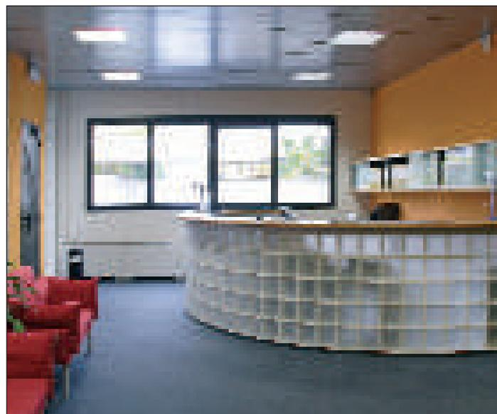
Per la seconda, che ha riguardato gli uffici, la sala riunioni e la reception, il controsoffitto è stato realizzato in lamiera microforata con imbottitura fonoassorbente in fibra naturale. L'impatto è ultra moderno e la eco-bio-compatibilità
