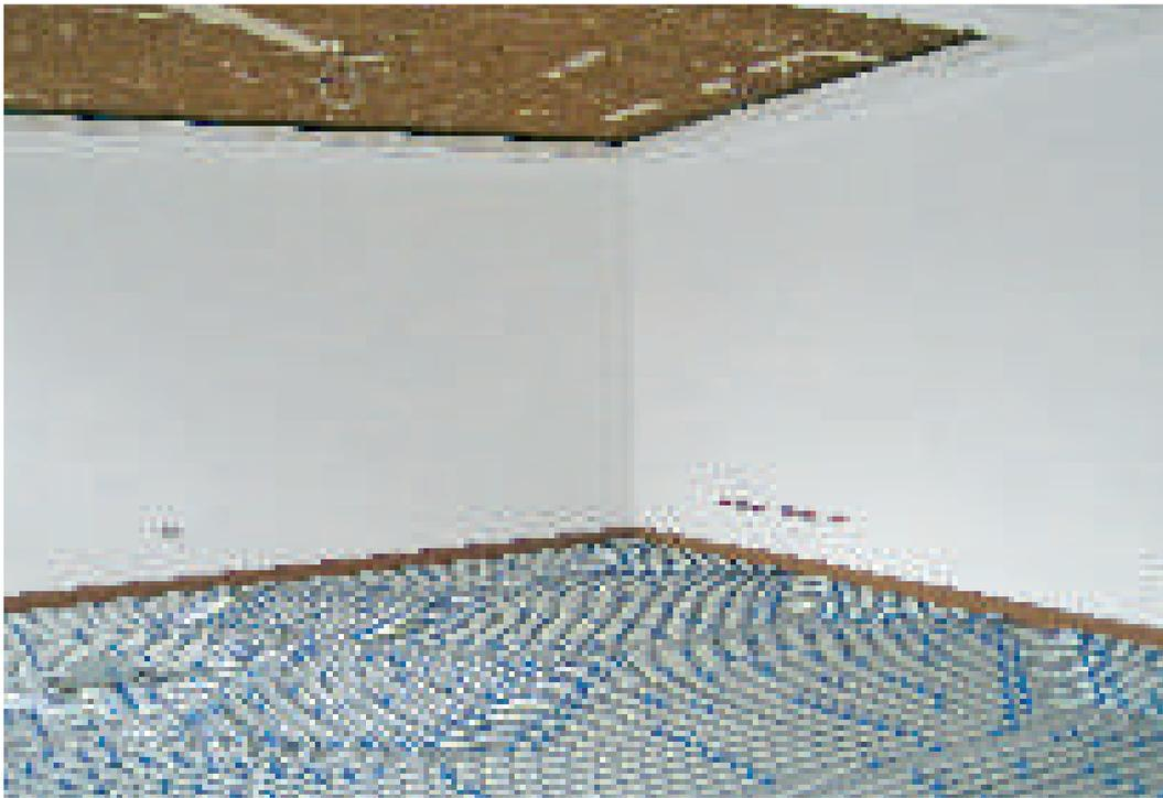
Particolare di posa della tubazione del riscaldamento a pavimento al di sopra dell'impasto SugheroLite+KoGlass e strisce in sughero KoFlex lungo il perimetro delle pareti.
