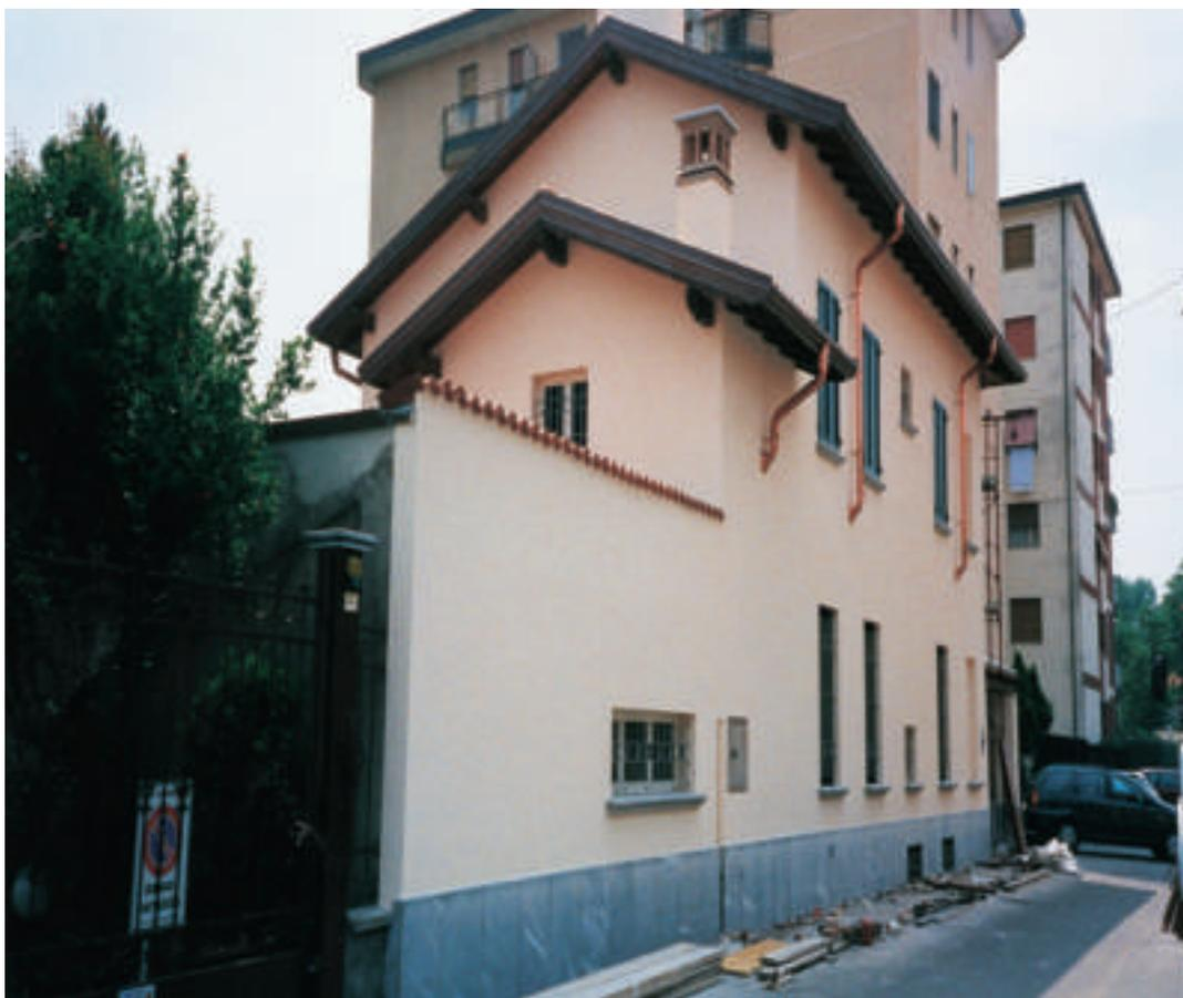
Esecuzione intonaco di finitura ai silicati di potassio sui pannelli di sughero biondo naturale superkompatto. Progetto Geom. Enzo Cavanna.
