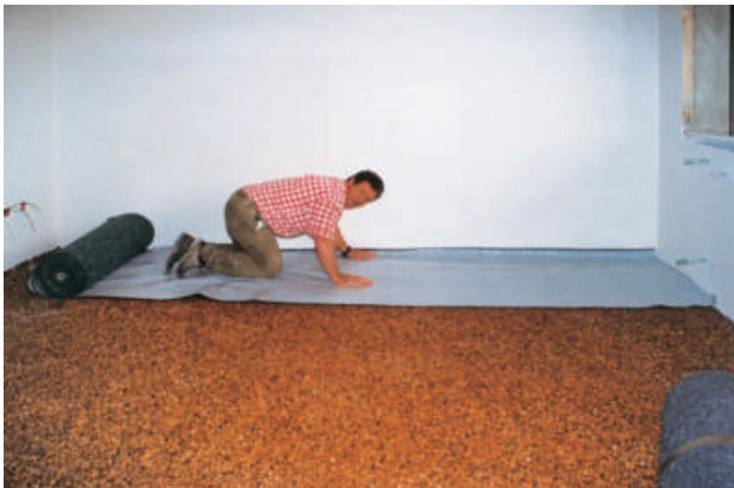
Particolare di stesura strato separatore anticalpestio sopra l'impasto di sughero in granuli e vetrificante a presa aerea
