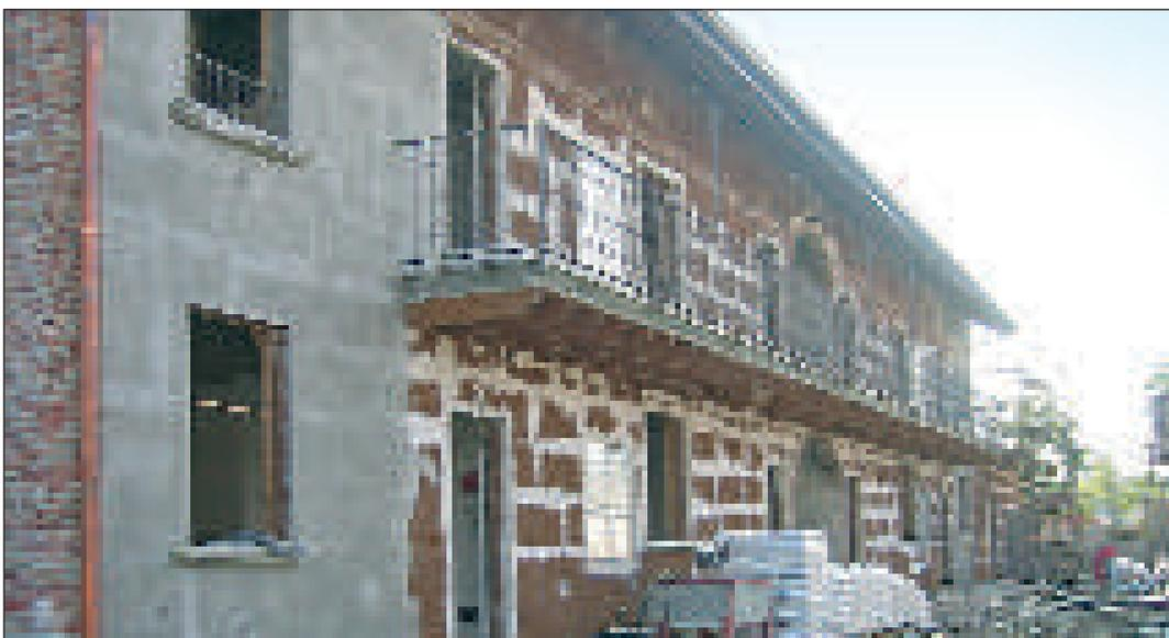
Rivestimento a cappotto esterno SoKoVerd.KE con ancoraggio di pannello in sughero biondo naturale SoKoVerd.LV a grana fine 2/3 mm mediante ancorante cementizio PraKov. Fase di intonaco di spessoramento KoMalt.G.
