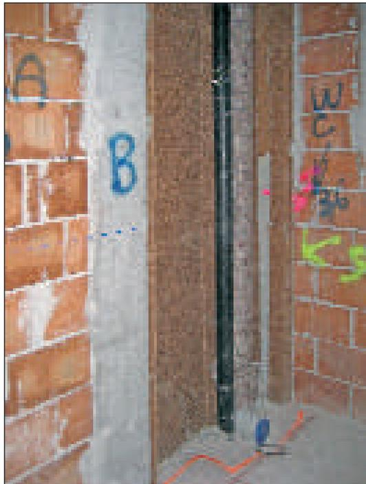
Particolare rivestimento dei pilastri in c.a. con pannelli in sughero biondo naturale compresso SoKoVerd AF a grana media 4/8mm e fasciatura delle tubazioni con ovatta vegetale KoFiVeg.
