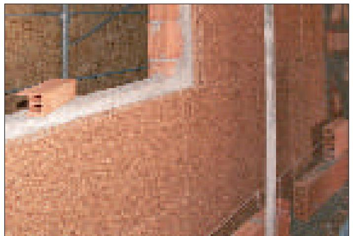
Parete perimetrale con inserimento di doppio strato di sughero biondo naturale superkompatt SoKoVerd.LV a grana fine 2/3mm
