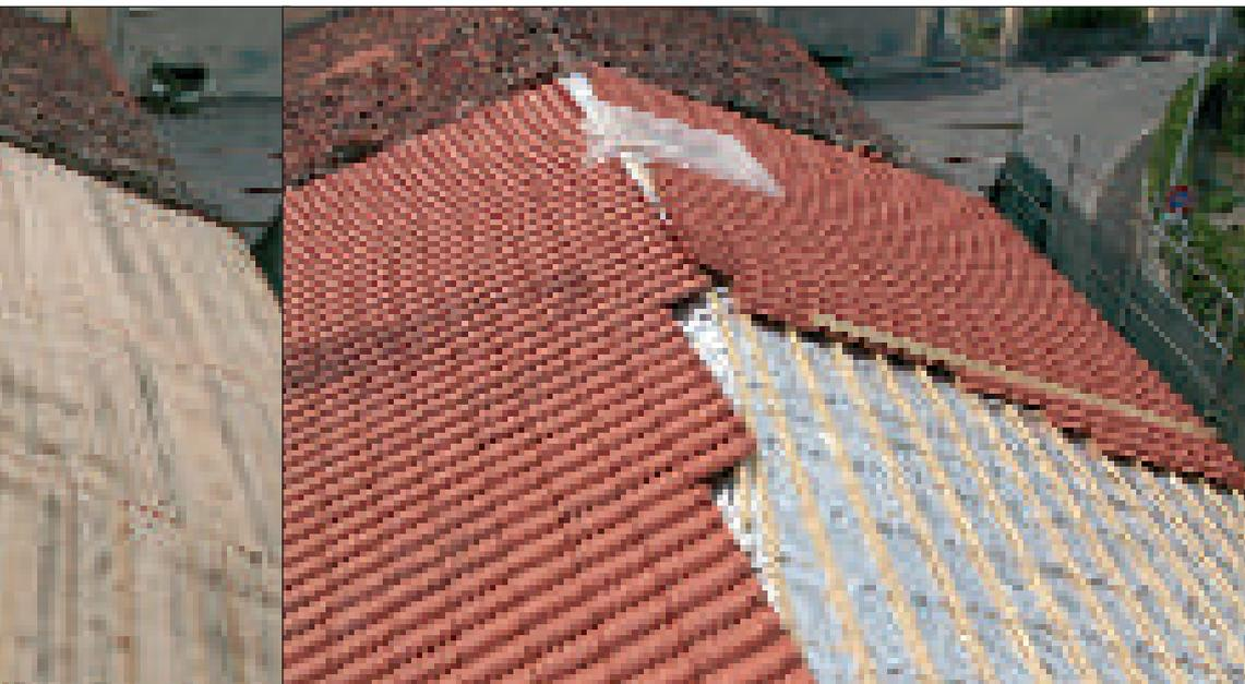
Listellatura verticale per la ventilazione, stesura di carta alluminata impermeabile e termoriflettente KoSep.A. ed infine controlistellatura per l'appoggio del manto di copertura.
