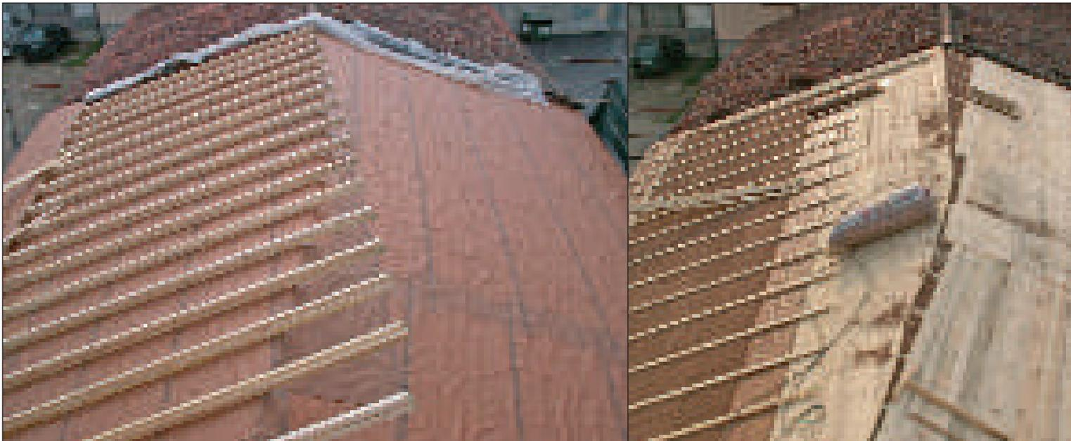
Tetto bioedile in legno con stesura sull'assito di strato separatore impermeabile e traspirante KoSep.C. Creazione di un secondo assito in legno distanziato da listoni con riempimento di granuli in sughero naturale bollito e ventilato SugheroLite Costante granulometria 4 mm. Sopra l'assito stesura di una carta oleata KoSep.C e un pannello in sughero biondo naturale SoKoVerd.LV a grana fine 2/3mm.
