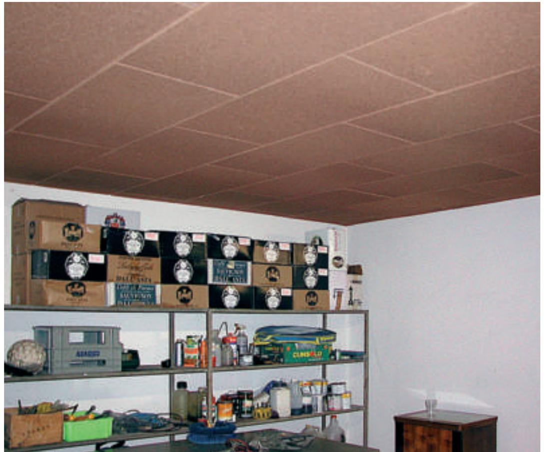
*Cappotto interno di un box con pannelli a vista in sughero biondo naturale supercompattoe preformato*
