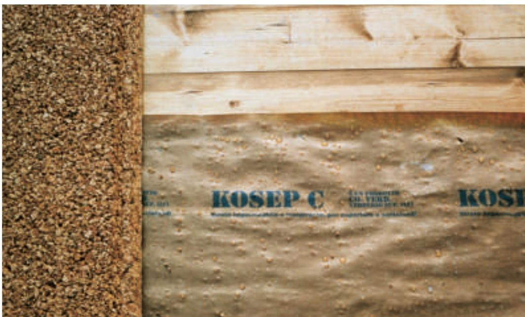
Vista in dettaglio dello strato separatore di carta oleata impermeabile all'acqua e permeabile al vapore
