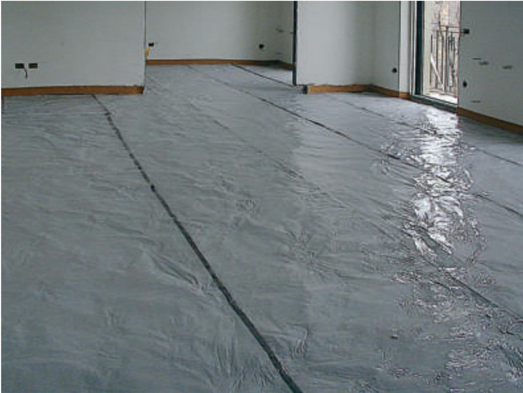
Particolare di posa dello strato separatore anticalpestio KoSep.F completo di strisce in sughero supercompresso KoFlex lungo il perimetro del locale
