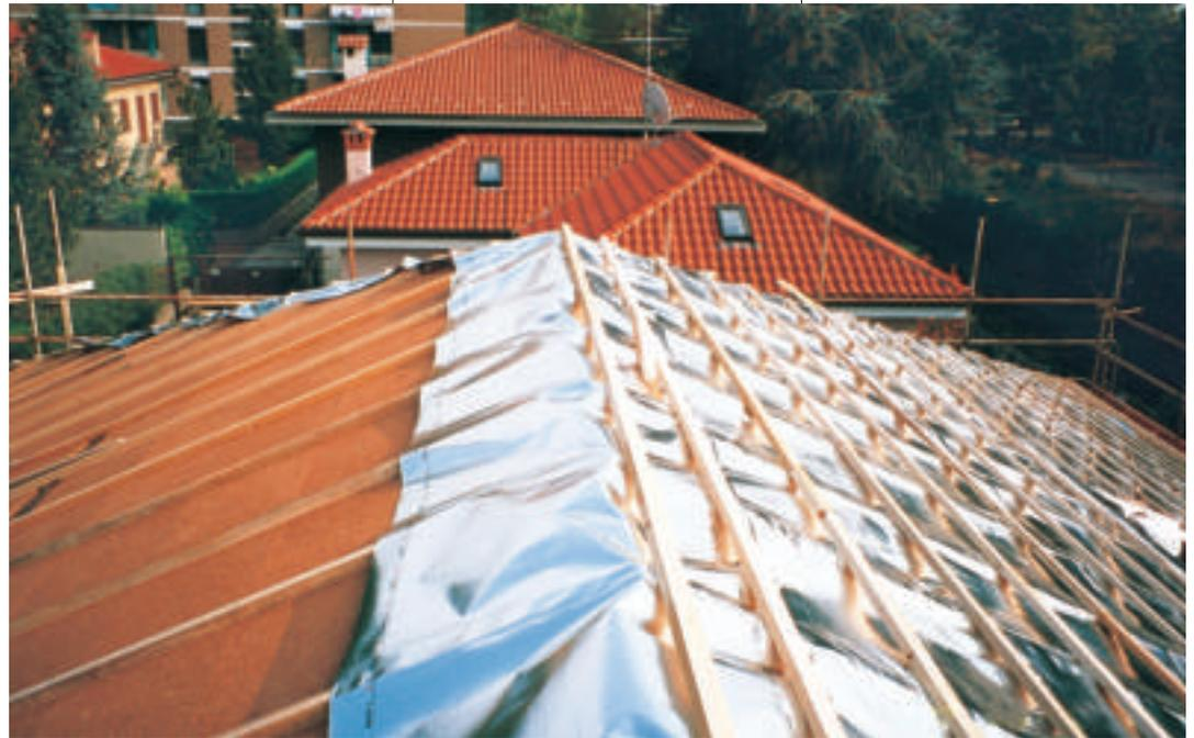
*Particolare tetto ventilato: posa doppio strato di pannelli in sughero biondo naturale superkompatto, listelli per la ventilazione e carta alluminata termoriflettente.*
