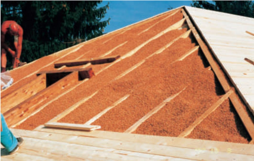
Particolare esecutivo di un tetto in legno con granuli di sughero biondo naturale bollito e ventilato tra i due assiti in legno.
