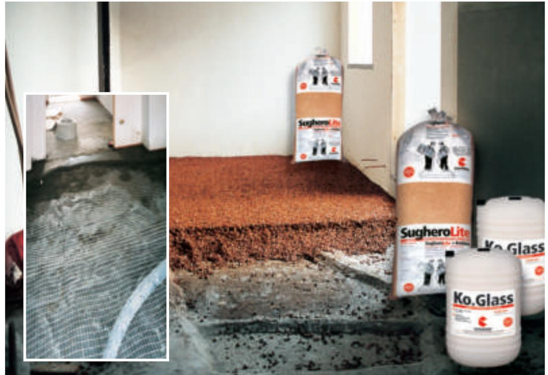
Fase di realizzazione del sottofondo Sugherolite+KoGlass, posa strato separatore KoSep.C o KoSep.F, formazione massetto in sabbia e cemento con inserimento rete KoMax.
