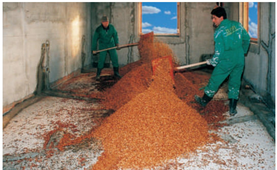
Fase di realizzazione del sottofondo in granuli di sughero biondo naturale bollito e ventilato con vetrificante a presa aerea.
