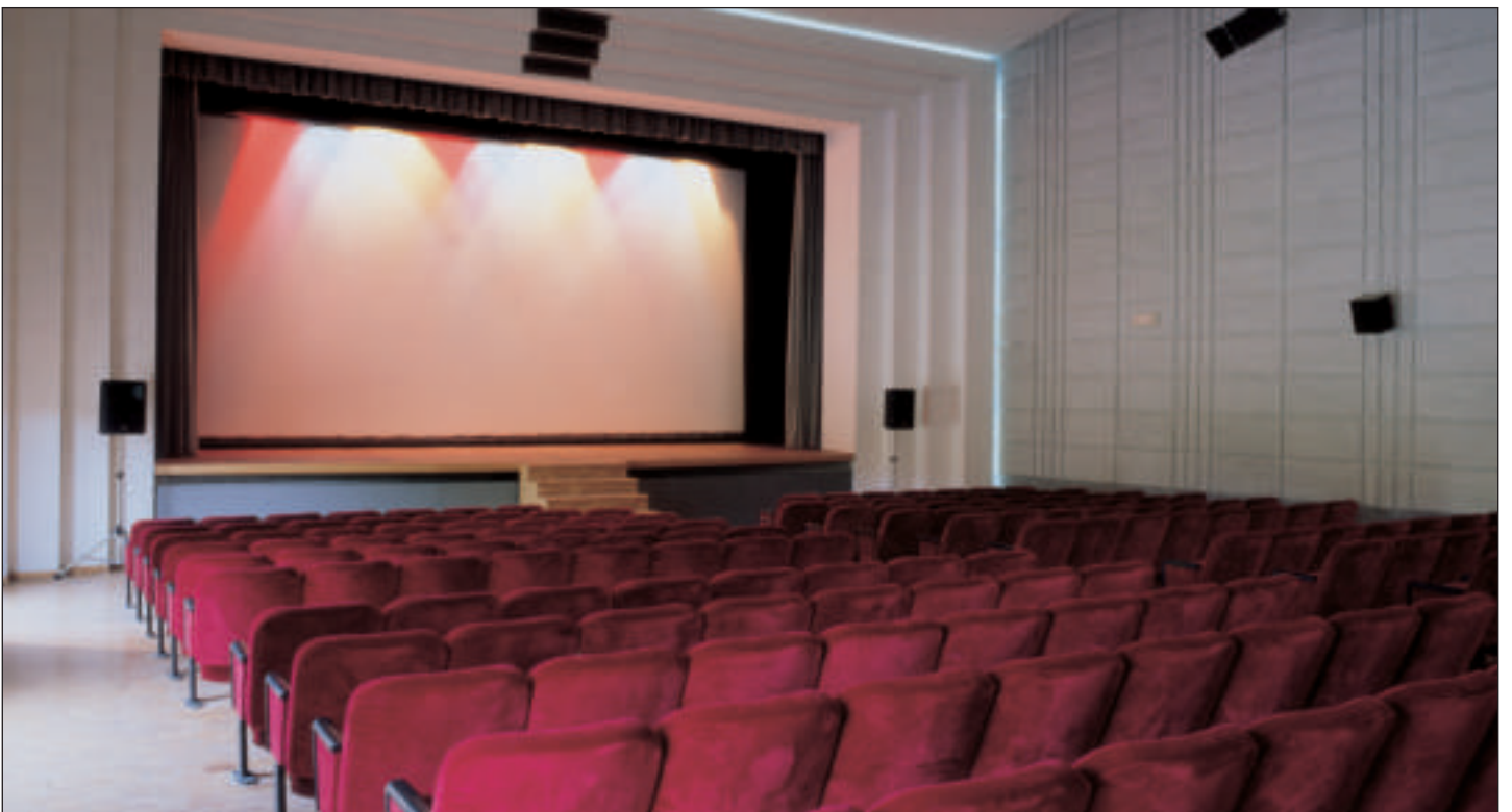
Cinema Teatro Parrocchiale Sant'Ambrogio, Ronco Briantino (MI). Nel caso di un teatro l'obiettivo è la massima intelligibilità dei suoni. Un accurato studio preliminare e soluzioni particolari permettono di raggiungere il risultato
