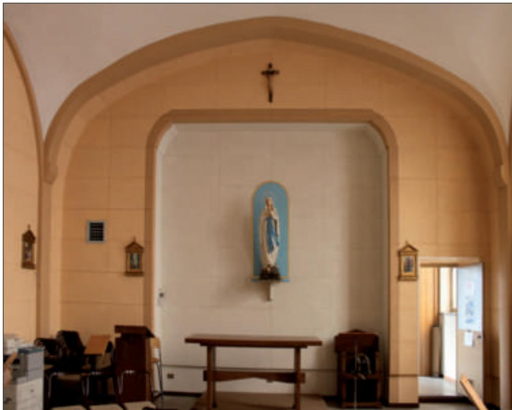
*Rivestimento delle pareti utilizzando i pannelli in sughero preformato e pretinteggiato SoKoVerd.C1*
