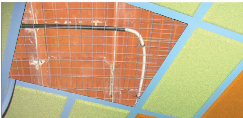
*La soluzione Coverd per il contenimento dello sfondellamento dei solai*
