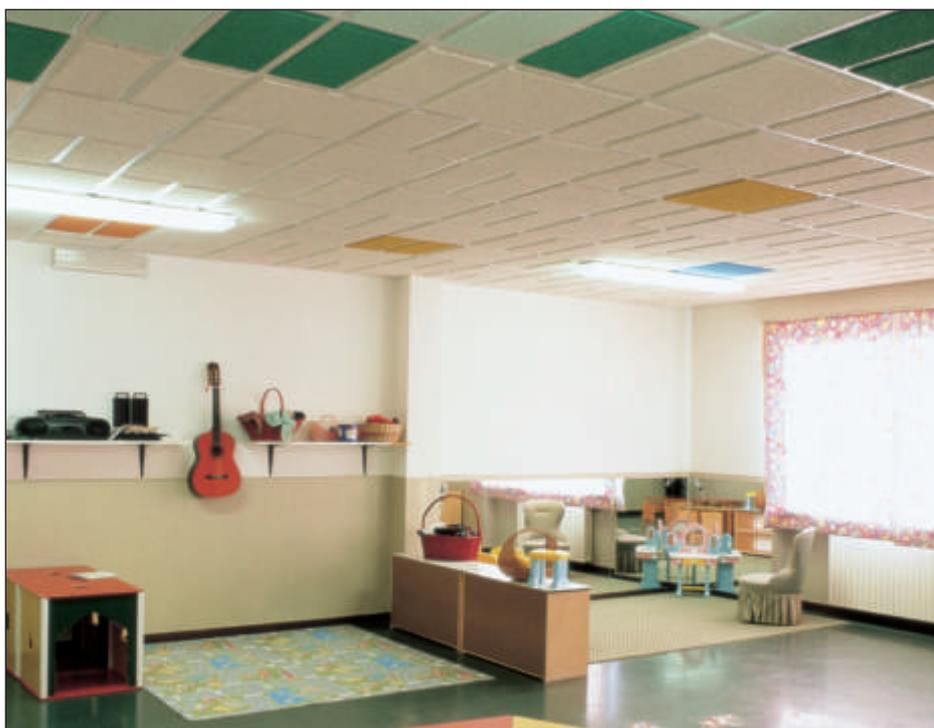
*Pannelli di sughero Kontro utilizzati sulla struttura AlCover per isolare acusticamente una zona ricreativa all'interno della Scuola materna di Cantù (CO).*
