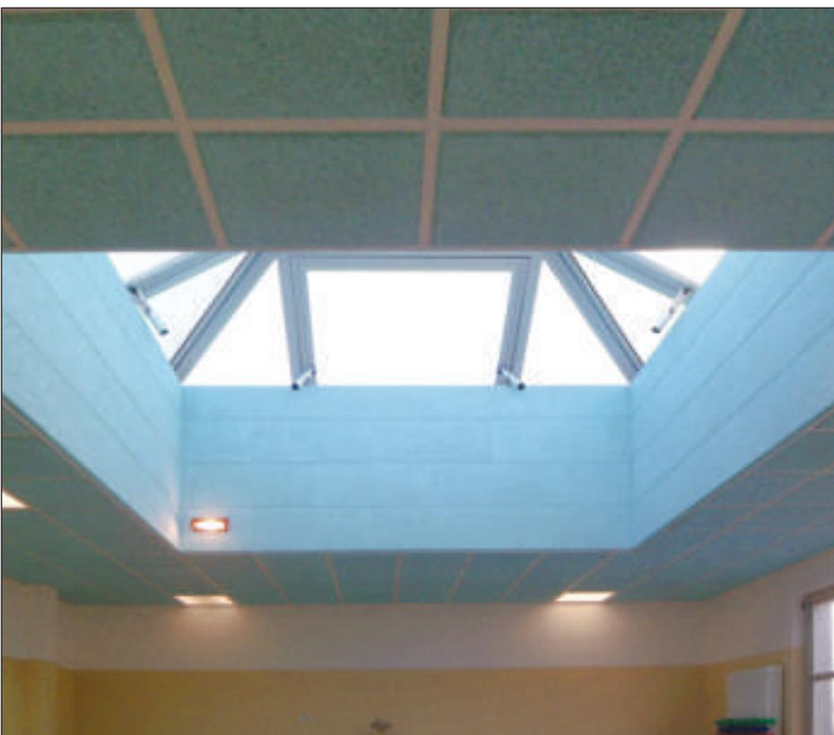
Scuola Materna di Via Magreglio Milano. Particolare del lucernario mediante il rivestimento con pannelli in sughero SoKoVerd.C1 e Kontro sul soffitto. A fianco si nota la fase di collaudo acustico nel refettorio arancione dopo l'intervento d'insonorizzazione.
