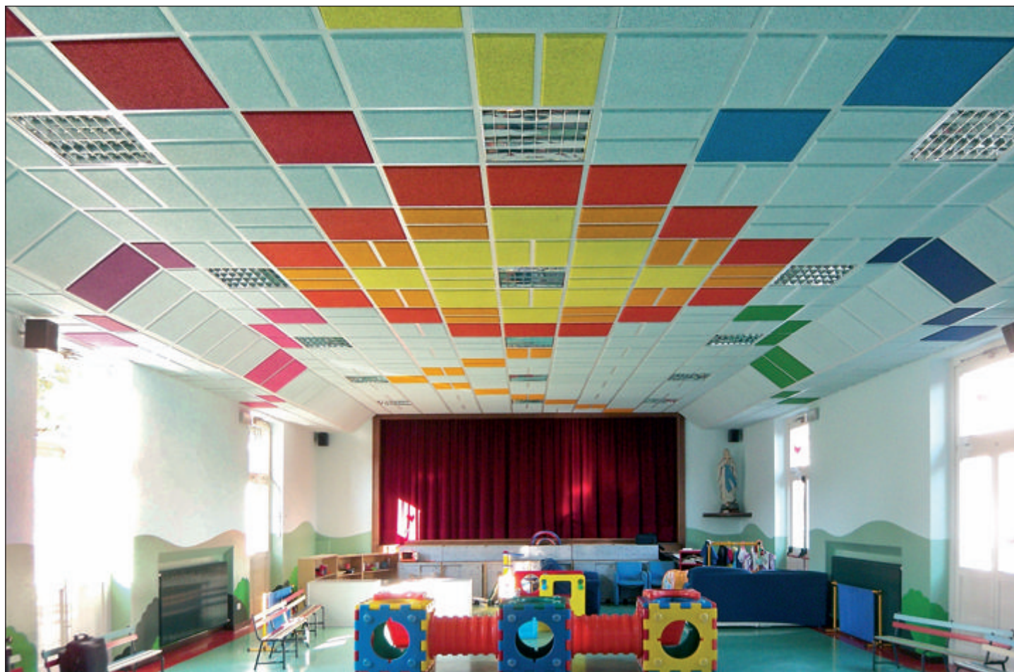
Ambiente didattico polifunzionale: è molto importante mantenere una buona intelligibilità, garantire l'assenza di rumori estranei indesiderati ed una corretta distribuzione del messaggio sonoro, sinonimo di trattamento acustico efficace, senza dimenticare l'importanza dell'aspetto estetico e l'uso dei colori (cromoacustica).
