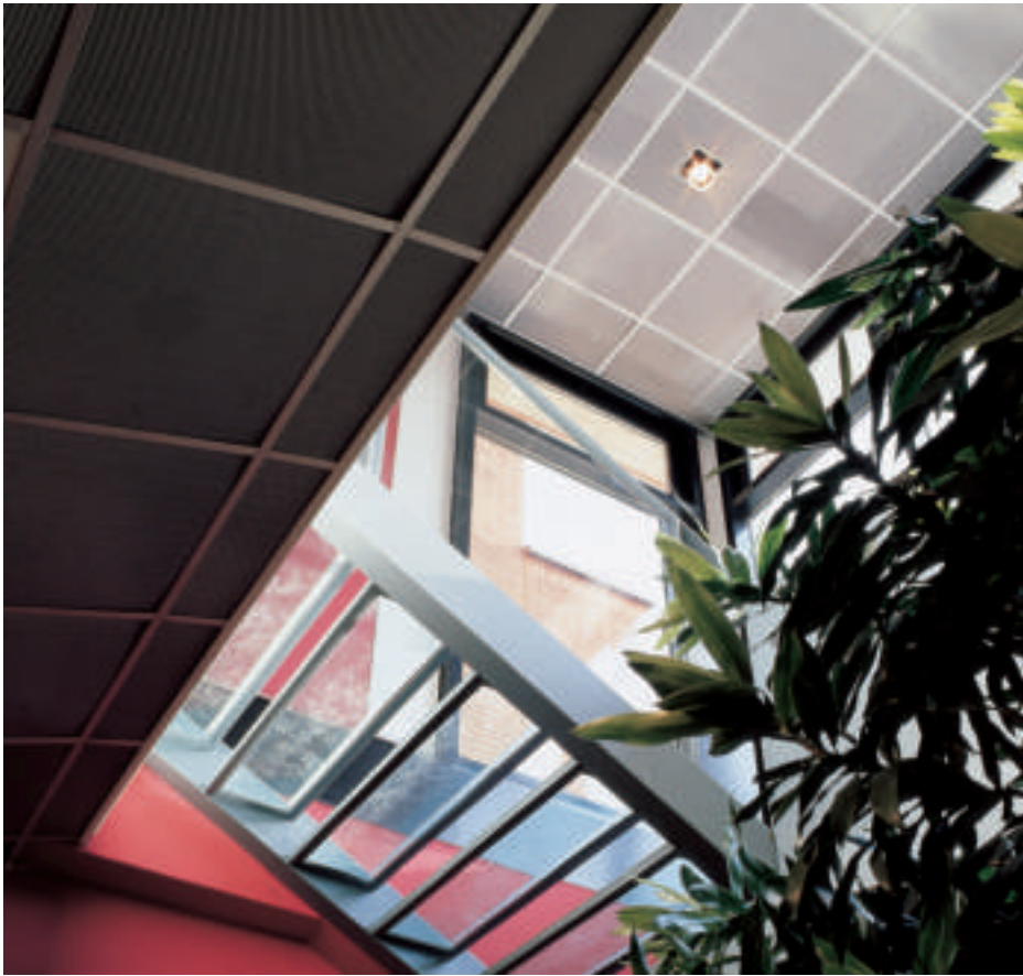
Vista della scala - Controsoffitto in lamiera stirata SofStell
