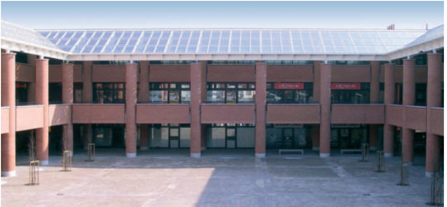
Vista interna Galleria Marconi
