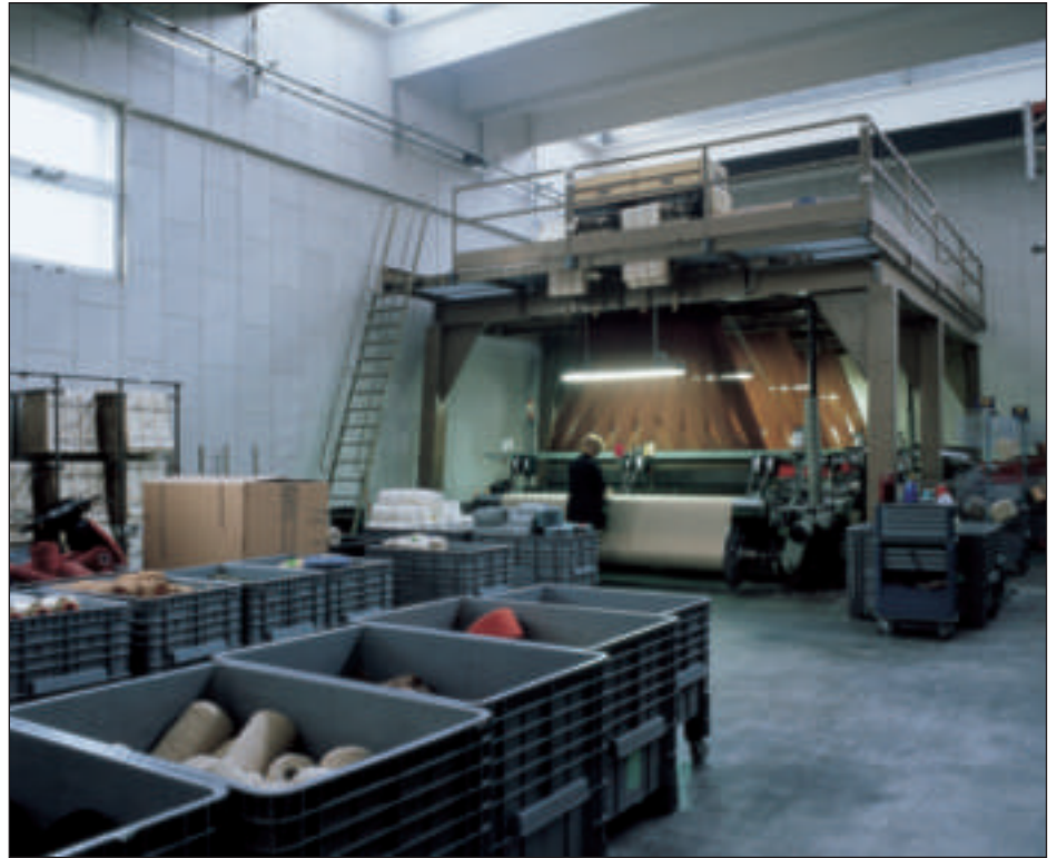
Realizzazione di un intervento di risanamento acustico sulle pareti perimetrali alla tessitura Imatex spa - Nibionno (LC)
