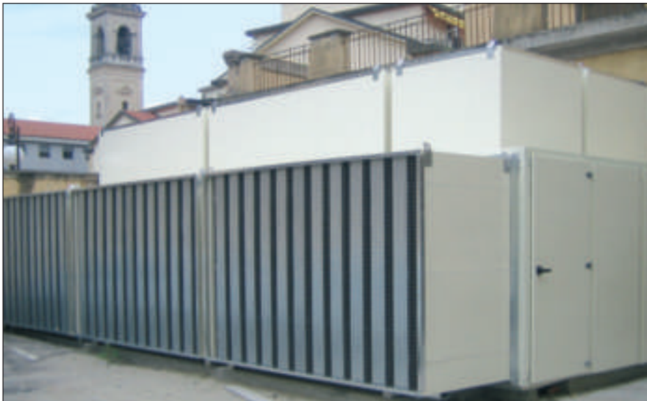
Realizzazione di un cabinato insonorizzato per ridurre la rumorosità prodotta da macchinari. Intervento in un importante centro storico che ha dovuto coinvolgere anche la Sovraintendenza.
