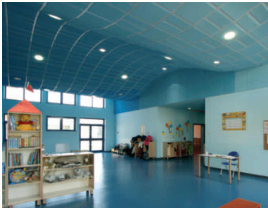
Uno spazio polifunzionale nella scuola materna di San Zenone al Lambro (MI). I pannelli Coverd si adattano alle più svariate soluzioni architettoniche, anche a un soffitto a curve
