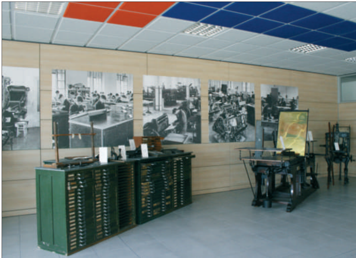
Pannelli Kontro applicati a controsoffitto su telaio AICover per la correzione acustica della tipografia AG Bellavite di Missaglia (LC)
