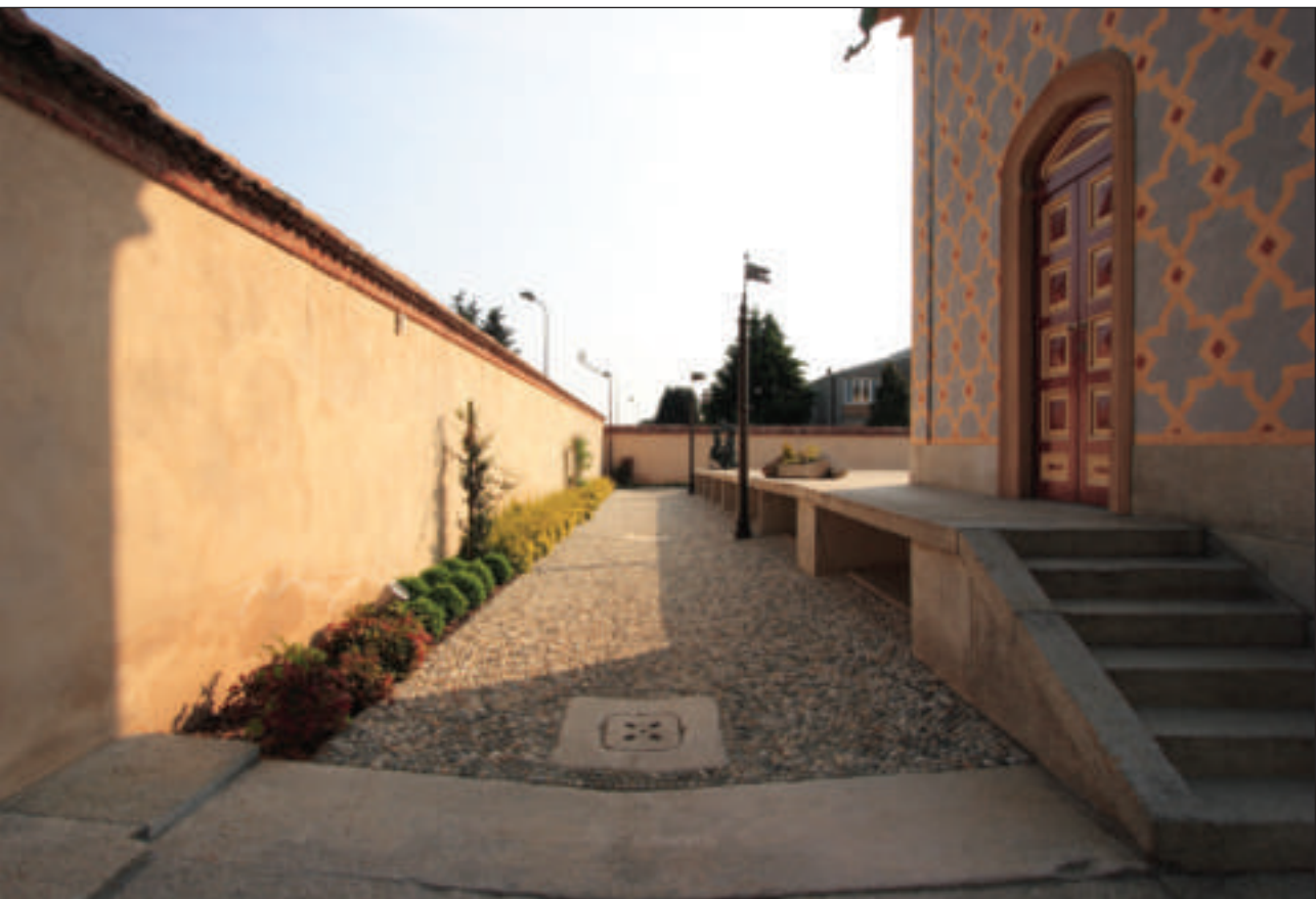
Gli intonaci sono stati completamente rifatti su entrambe le facciate della cinta muraria utilizzando materiali e mescole dell'epoca
