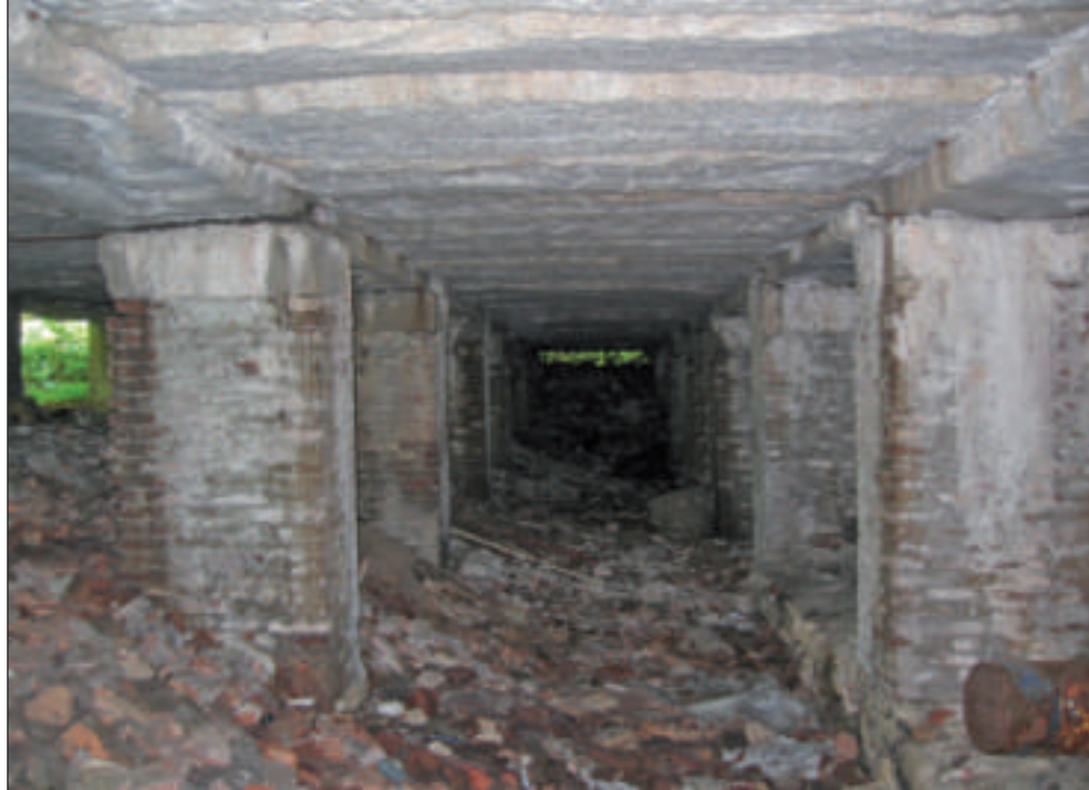
Un particolare dei cunicoli sottostanti il cortile prima del ripristino. Si notano i pilastri di mattoni pieni e le lastre di granito di Montorfano che formavano il lastricato rialzato dove venivano stese le granaglie per essicare. I muri continui di pietra tra un pilastro e l'altro erano in parte crollati
