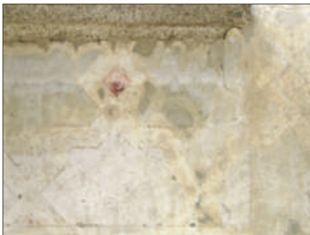
Le tracce rinvenute sull'intonachino hanno permesso la ricostruzione fedele delle cromie
