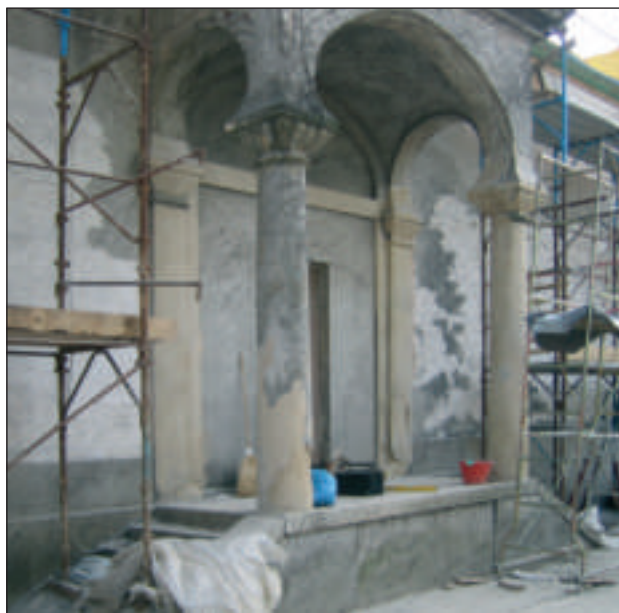
La delicata rimozione dell'intonachino ammalorato dalle colonne in arenaria
