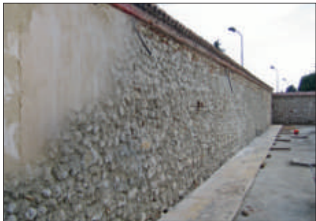
Nella prima fase del restauro il muro di cinta è stato ripulito dal vecchio intonaco mettendo a nudo le pietre che lo costituiscono
