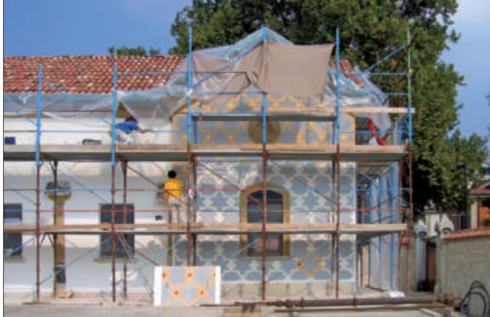
La trasposizione sulle pareti degli originali con l'antica tecnica dello spolvero, le tracce rinvenute sull'intonachino hanno permesso la ricostruzione fedele delle cromie
