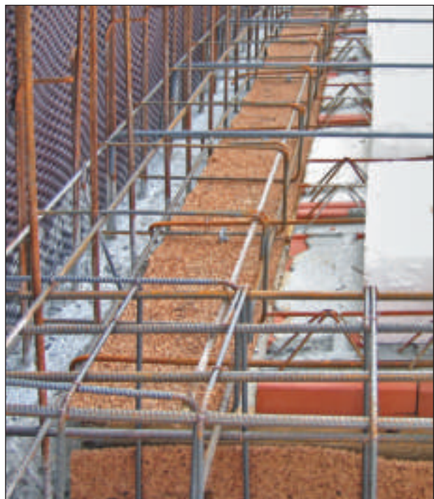
Isolamento di travi e pilastri con pannelli di sughero biondo per prevenire i ponti termici
