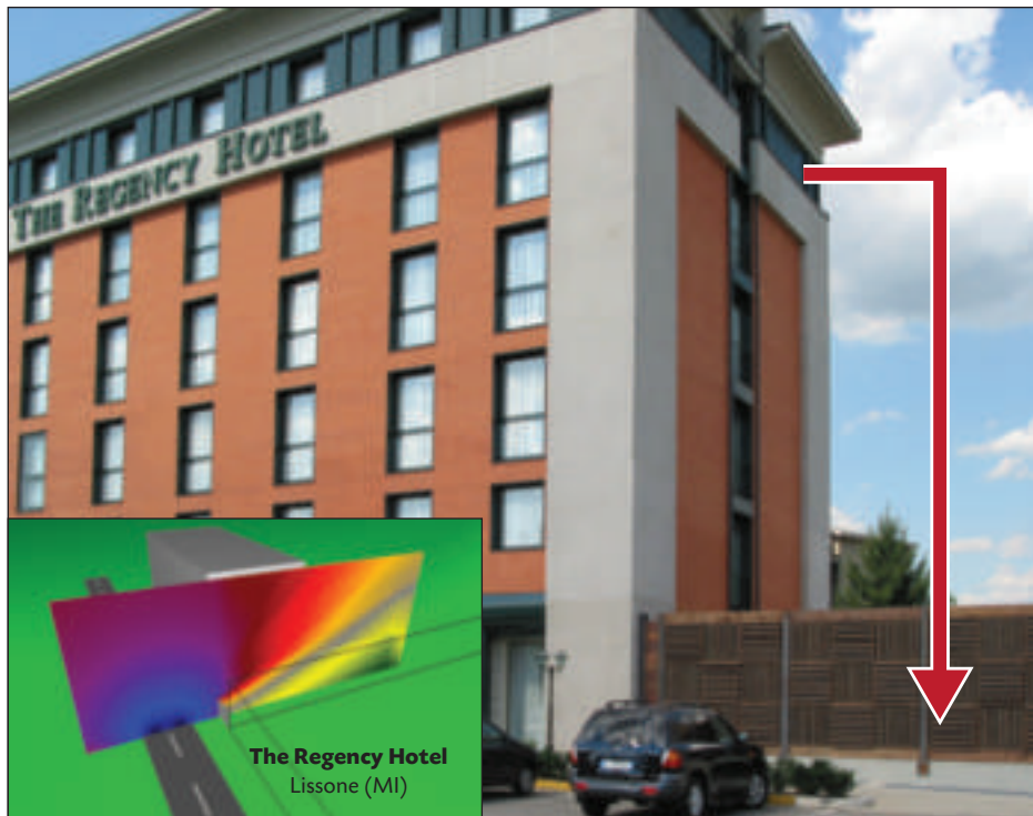
Studio e realizzazione di barriera acustica ... a protezione di un'area esterna
