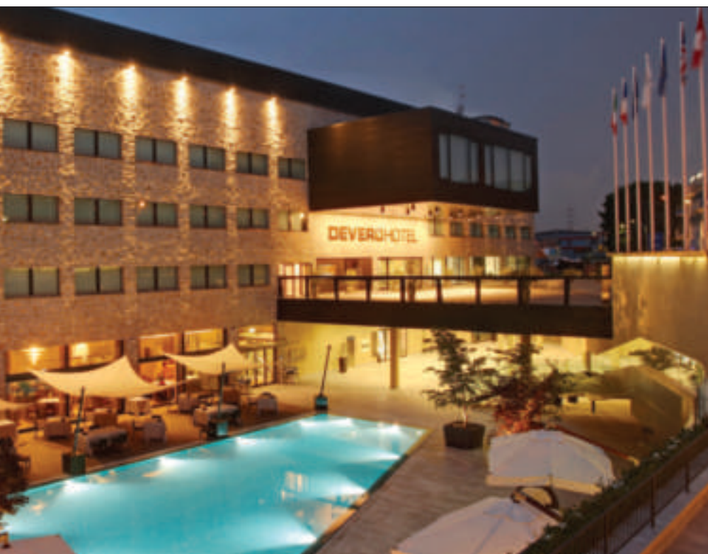
Verifica dei requisiti acustici, eseguita a fine lavori - Devero Hotel Cavenago Brianza (MI)
