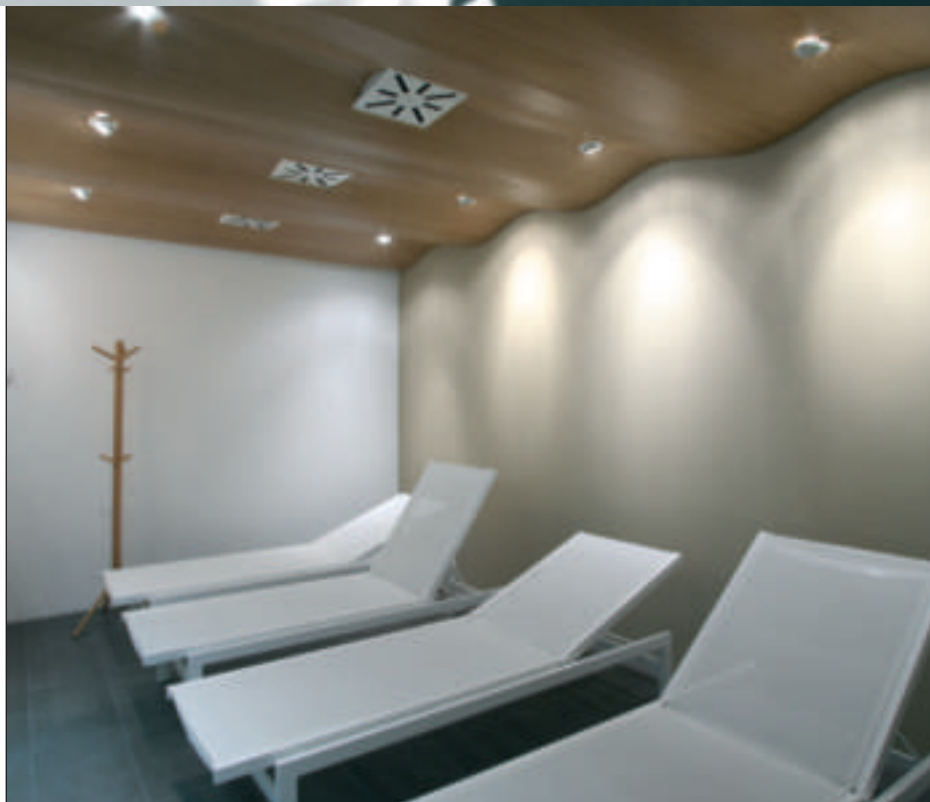
KombyFlex di Coverd, i pannelli in legno fresato che trasformano in elemento estetico la coibentazione termoacustica del soffitto Centro benessere - Brugherio (MI)
