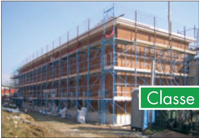
Il rivestimento a capotto della facciata esterna della nuova sede di Coverd dove sul fronte sud hanno trovato posto i pannelli solari
