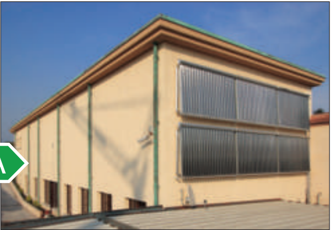
Il rivestimento a capotto della facciata esterna della nuova sede di Coverd dove sul fronte sud hanno trovato posto i pannelli solari
