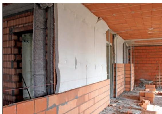
Isolamento acustico realizzato con blocchetto fonico NK8L, ovatta vegetale KoFiVeg, fibre di poliestere KoFiSin, sandwich FoniVeg e pannello in sughero SoKoVerd.AF
