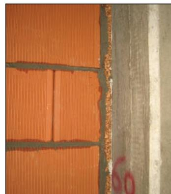
Isolamento realizzato con blocchetto fonico NK8L, sandwich FoniVeg e pannelli in fibre di poliestere KoFiSin
