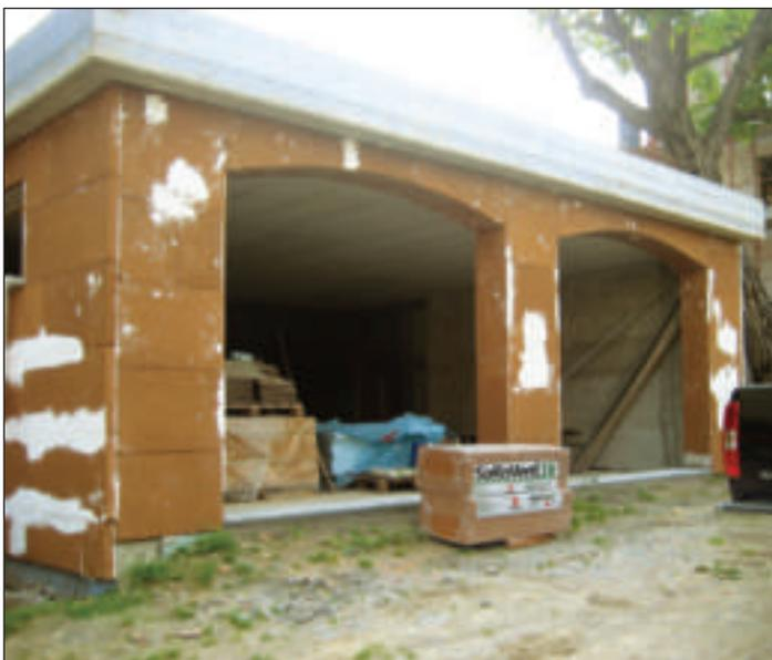
Rivestimento a cappotto esterno con ancoraggio di pannelli in sughero biondo naturale superkompatto SoKoVerd.LV a grana fine 2/3mm spessore 6cm
