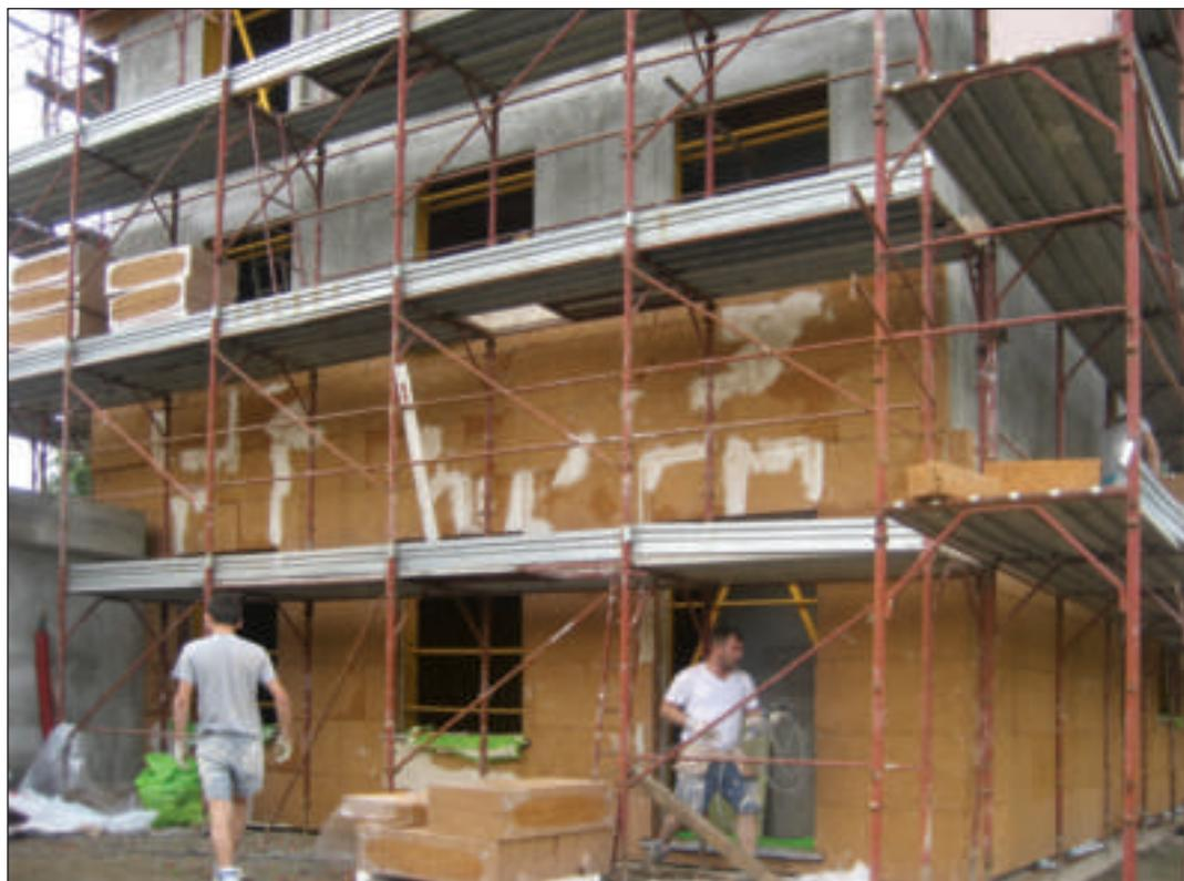
*Sistema di isolamento termico a Cappotto esterno BioVerd, composto da SoKoVerd.XL i nuovi pannelli in sughero biondo naturale ad elevato spessore superkompatto ad alta densità, disponibili in spessori sino a 20cm.*
