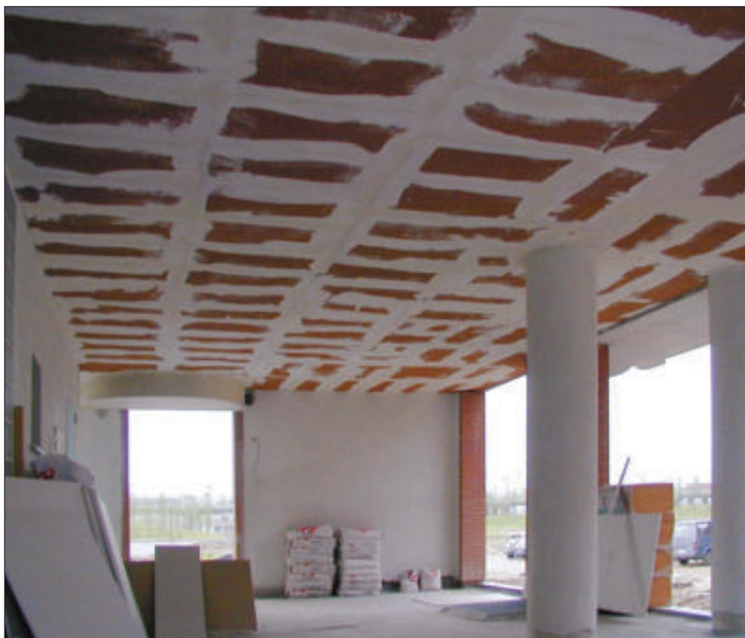
Porticati con sistema di isolamento termico a cappotto Bioverd mediante il rivestimento con pannelli in sughero biondo superkompatto SoKoVerd.LV
