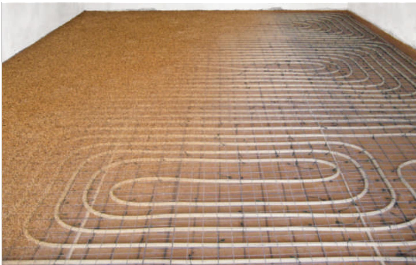
*Sottofondo costituito da impasto di sughero biondo naturale bollito e ventilato SugheroLite con legante vetrificante a presa aerea KoGlass a copertura degli impianti, strato separatore termoriflettente KoSep.A, rete elettrosaldata KoSteel con agganciate mediante clips le tubazioni del riscaldamento a pavimento e strisce KoFlex lungo il perimetro delle pareti. Al di sopra verrà realizzata la caldana in sabbia e cemento con il relativo pavimento.*
