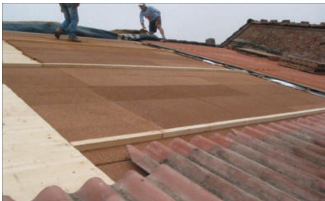
Copertura in legno con stesura di carta oleata KoSep.C, doppio strato di pannelli in sughero biondo naturale superkompacto SoKoVerd.LV a grana fine 2/3mm, listellatura per la ventilazione con inserimento dello strato separatore termoriflettente KoSep.A.
