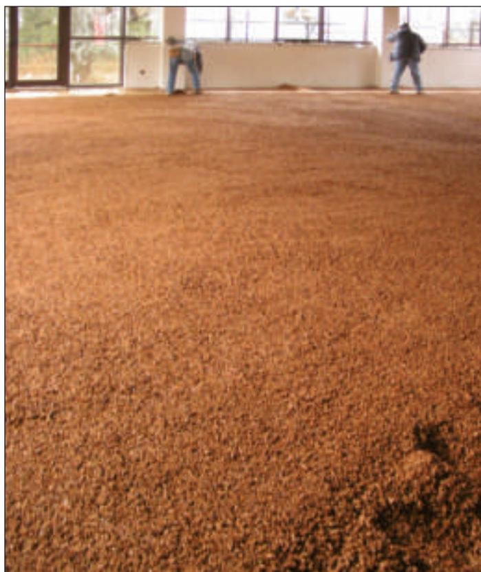
*Particolare impasto di sughero biondo naturale bollito e ventilato SugheroLite con legante vetrificante a presa aerea KoGlass di elevato spessore a copertura degli impianti.*
