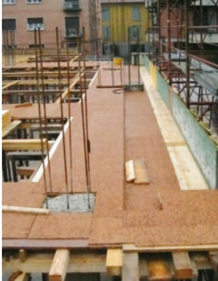
Rivestimento dell'intradosso delle travi con pannelli in sughero biondo naturale supercompresso SoKoVerd.AF con sistema getto in contro-cassero
