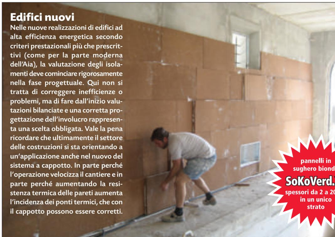
Rivestimento a cappotto interno SoKoVerd.KI con ancoraggio doppio strato pannelli in sughero biondo naturale superkompatto SoKoVerd.LV a grana fine 2/3mm dallo spessore di 4+4cm
