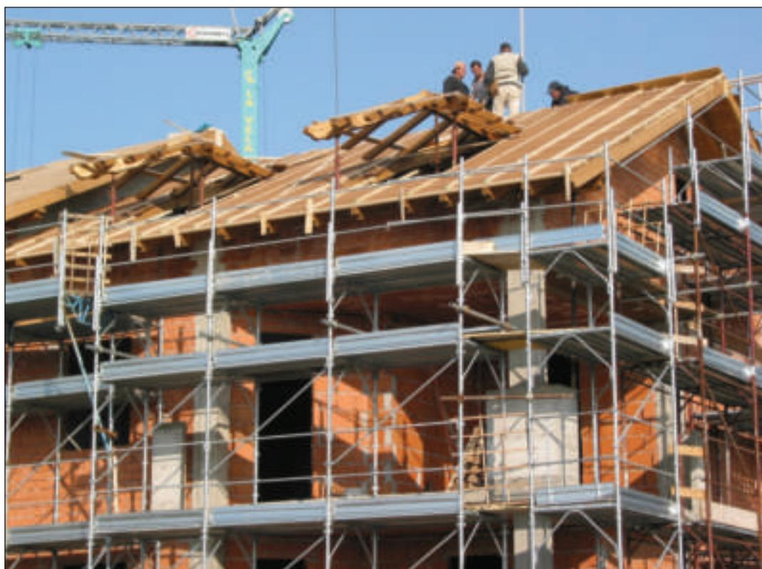
Copertura in legno con stesura di carta oleata KoSep.C, doppio strato di pannelli in sughero biondo naturale superkompatto SoKoVerd.LV a grana fine 2/3mm, listellatura per la ventilazione con inserimento dello strato separatore termoriflettente KoSep.A
