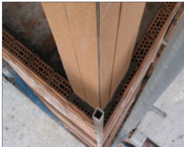
Rivestimento del pilastro con pannelli in sughero biondo naturale superkompacto SoKoVerd.LV a grana fine 2/3mm
