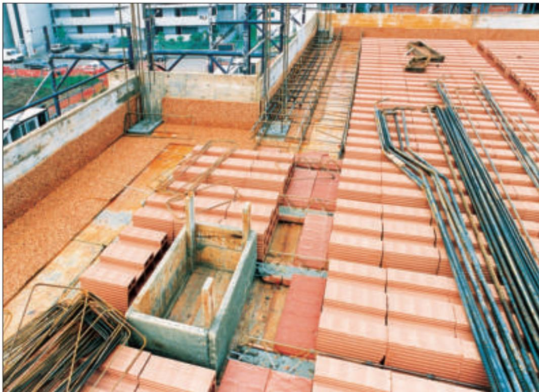
Protezione termoigrometrica delle travi orizzontali con pannelli in sughero biondo naturale compresso SoKoVerd.AF prima del getto in controciassero
