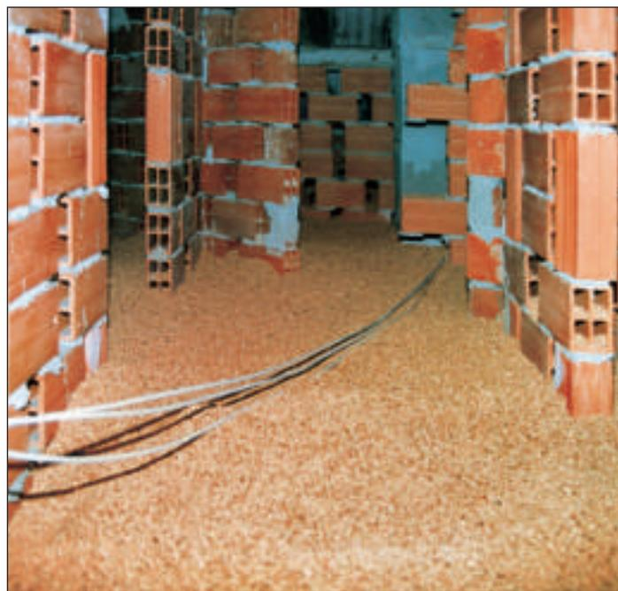
Sottotetto con stesura a secco sulla soletta di sughero naturale biondo in granuli bollito e ventilato SugheroLite Costante.
