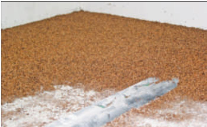
Particolare impasto di sughero biondo naturale bollito e ventilato SugheroLite con legante vetrificante a presa aerea KoGlass di elevata spessore a copertura degli impianti.
