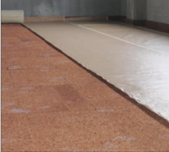
Sottofondo costituito da pannelli in sughero biondo naturale superkompacto SoKoVerd.LV a grana fine 2/3mm, strato separatore anticalpestio KoSep.L, e strisce KoFlex lungo il perimetro delle pareti. Al di sopra verranno realizzati gli impianti e la caldaia in sabbia e cemento con il relativo pavimento.
