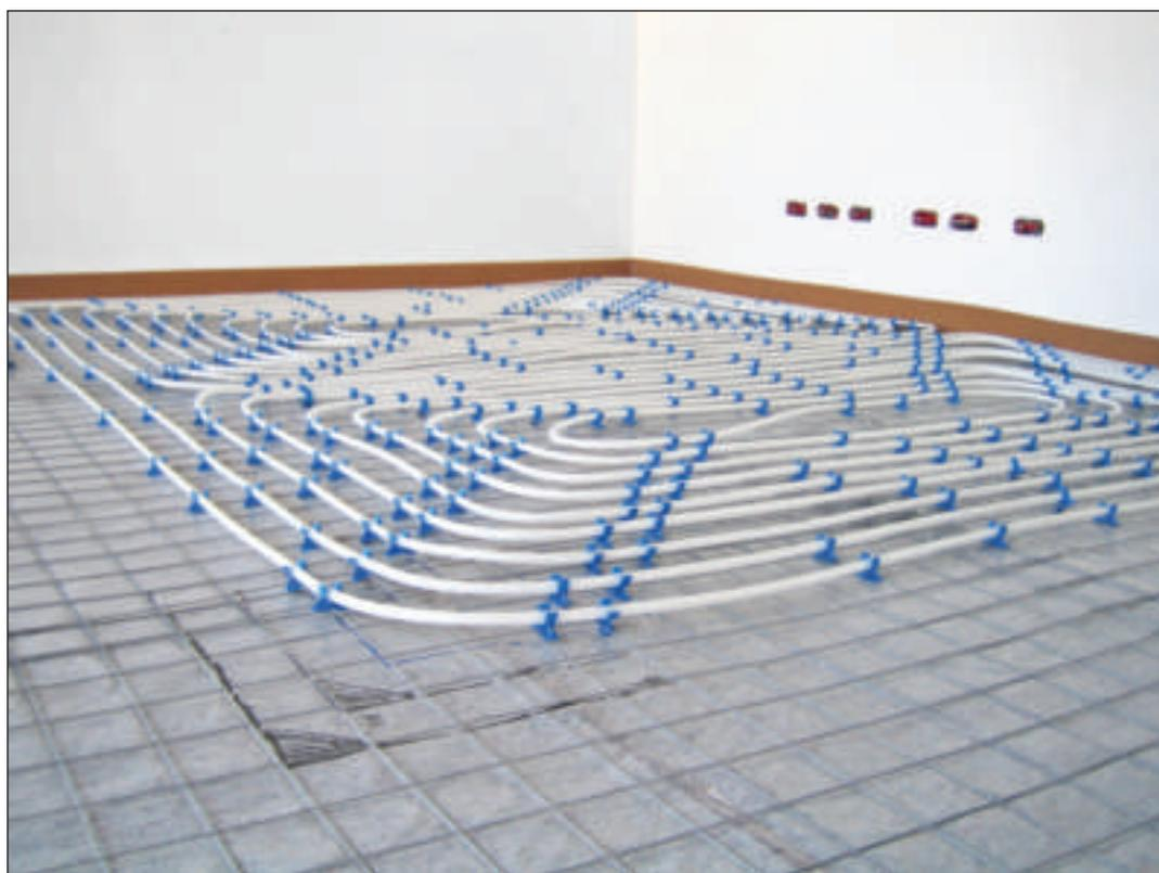
Sottofondo costituito da impasto di sughero biondo naturale bollito e ventilato SugheroLite con legante vetrificante a presa aerea KoGlass a copertura degli impianti, strato separatore termoriflettente KoSep.A, rete elettrosaldata KoSteel con agganciate mediante clips le tubazioni del riscaldamento a pavimento e strisce KoFlex lungo il perimetro delle pareti. Al di sopra verrà realizzata la caldana in sabbia e cemento con il relativo pavimento.
