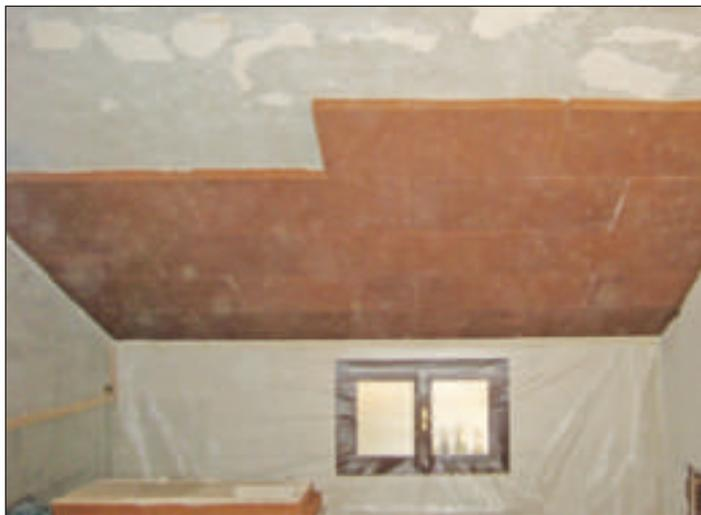
Rivestimento a cappotto interno SoKoVerd.KI in mansarda mediante ancoraggio di pannelli in sughero biondo naturale superkompatto SoKoVerd.LV a grana fine 2/3mm
