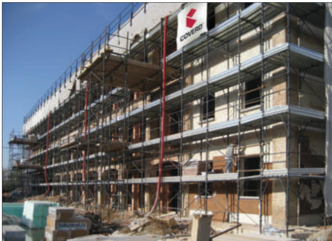
Ristrutturazione mediante rivestimento a cappotto esterno SoKoVerd.KE con ancoraggio pannelli in sughero biondo naturale superkompatto SoKoVerd.LV a grana fine 2/3mm dallo spessore di 5cm
