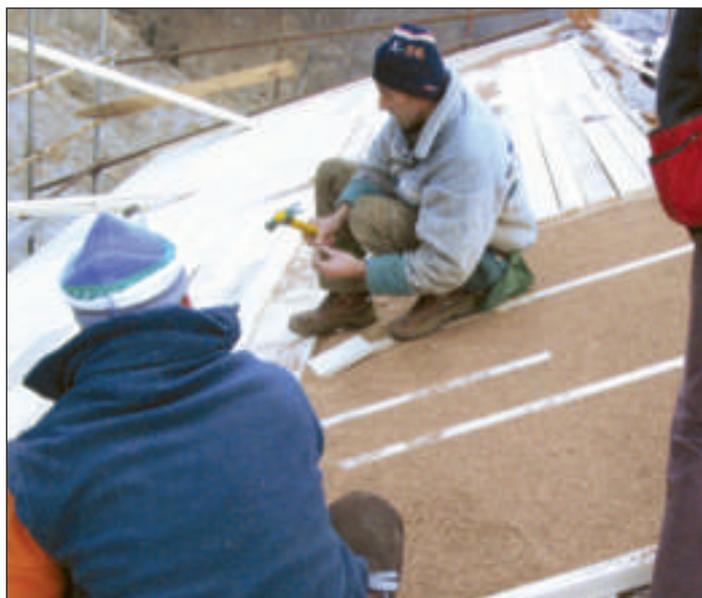
Copertura in legno con stesura sull'assito di carta oleata KoSep.C. Creazione di un secondo assito in legno distanziato da listoni con riempimento di granuli in sughero biondo naturale bollito e ventilato SugheroLite Costante 4mm. Sopra l'assito stesura di una carta oleata KoSep.C e un pannello in sughero biondo naturale superkompatto SoKoVerd.LV a grana fine 2/3mm. Listellatura verticale per la ventilazione con inserimento dello strato separatore termoriflettente KoSep.A
