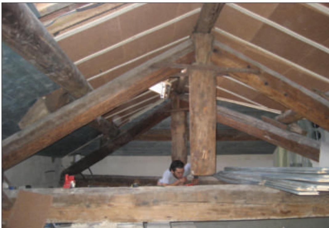
Sottotetto con struttura in legno. Posa di doppio strato in sughero biondo naturale superkompatto SoKoVerd.LV a grana fine 2/3mm e finitura con perline in legno.
