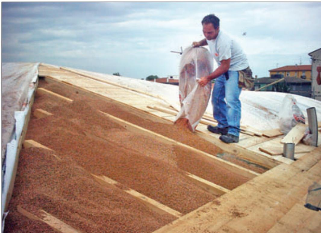
Copertura in legno con stesura sull'assito di carta oleata KoSep.C. Creazione di un secondo assito in legno distanziato da listoni con riempimento di granuli in sughero biondo naturale bollito e ventilato SugheroLite Costante 4mm. Sopra l'assito stesura di una carta oleata KoSep.C e un pannello in sughero biondo naturale superkompatto SoKoVerd.LV a grana fine 2/3mm. Listellatura verticale per la ventilazione con inserimento dello strato separatore termoriflettente KoSep.A
