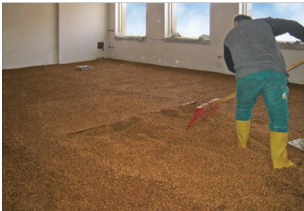
*Sottofondo costituito da impasto di sughero biondo naturale bollito e ventilato SugheroLite con legante vetrificante a presa aerea KoGlass a copertura degli impianti.*
