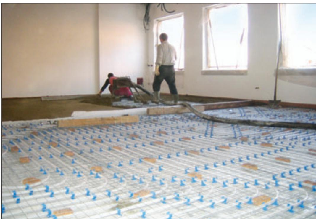
Particolare della posa del massetto in sabbia e cemento, sopra l'impasto di SugheroLite+KoGlass, strato separatore anticalpestio KoSep.L, rete elettrosaldata KoSteel con agganciate mediante clips le tubazioni del riscaldamento a pavimento.
