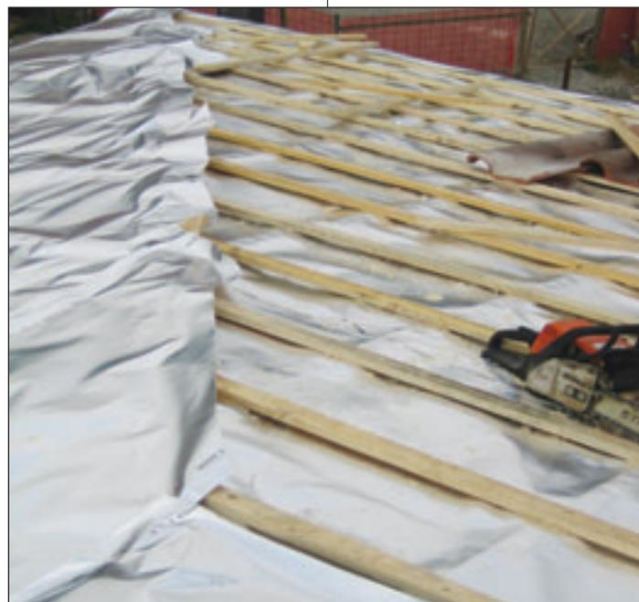
*Particolare dello strato termiriflettente e impermeabile di carta alluminata KoSep.A posato tra i listelli di ventilazione e sopra l'isolante.*
