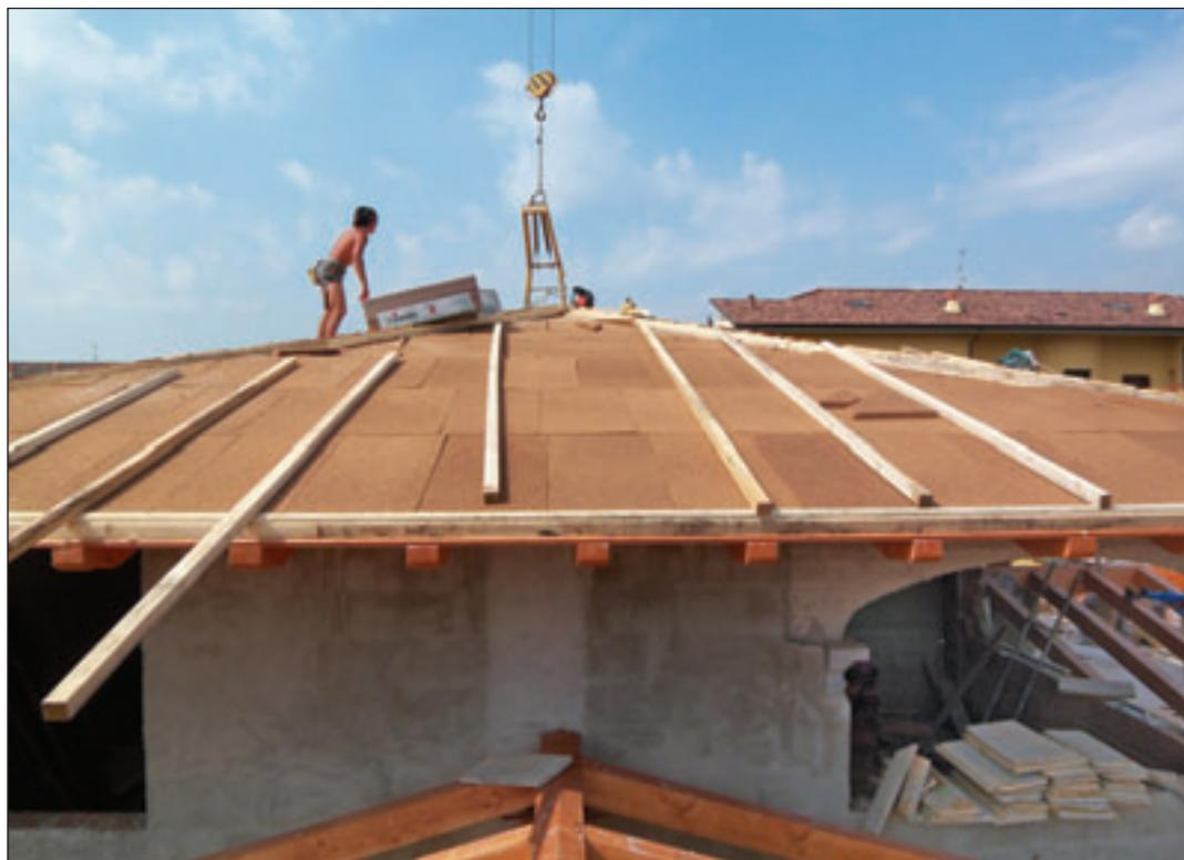
*Copertura in legno con stesura di carta oleata KoSep.C, doppio strato di pannelli in sughero biondo naturale superkompatto SoKoVerd.LV a grana fine 2/3mm, listellatura per la ventilazione con inserimento dello strato separatore termiriflettente KoSep.A*
