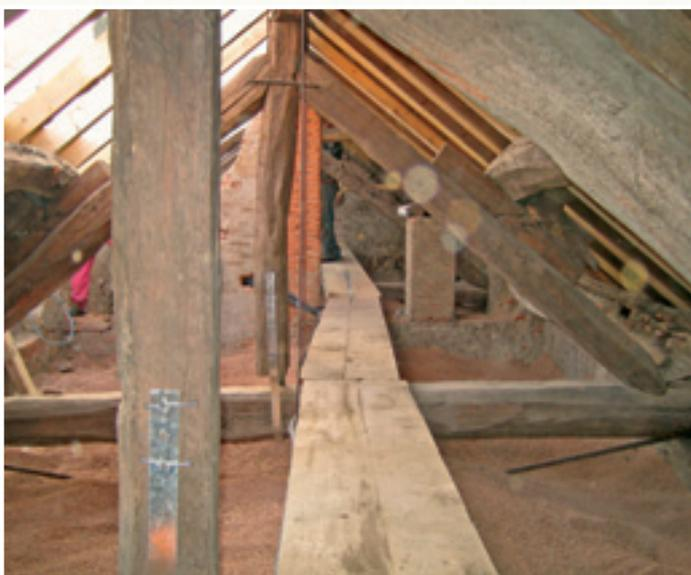
Solaio piano di sottotetto con stesura sulla soletta di sughero biondo naturale bollito e ventilato SugheroLite Costante.
