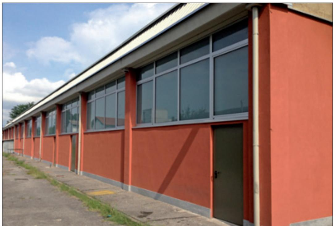
Finitura con intonaco ai silicati di potassio e silosannici KoSil.S sopra il cappotto in sughero e intonaco di spessoramento KoMalt.G.
