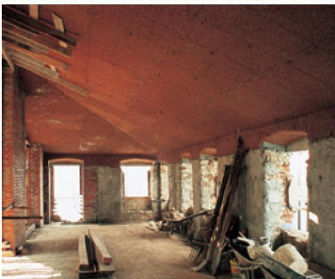
Cappotto interno BioVerd realizzato con pannelli in sughero biondo naturale bollito e ventilato su solaio inclinato di copertura.
