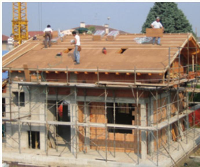
Copertura bioedile con doppio strato di pannelli in sughero biondo naturale superkompatto SoKoVerd.LV a grana fine 2/3mm.
