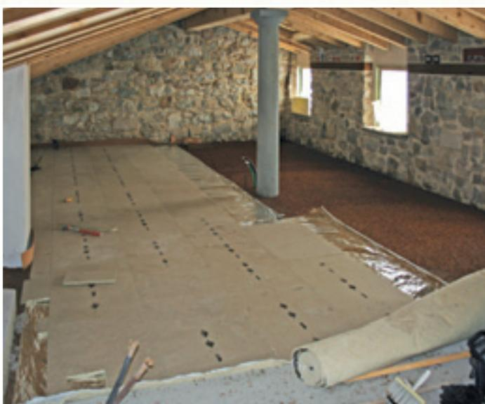
Solaio di sottotetto eseguito con impasto di sughero biondo naturale bollito e ventilato SugheroLite Costante con KoGlass e strato separatore anticalpestio termo riflettente KoSep.Lir, strisce KoFlex lungo il perimetro delle pareti, pannello in legno KoSial pronto per ricevere il riscaldamento a pavimento .
