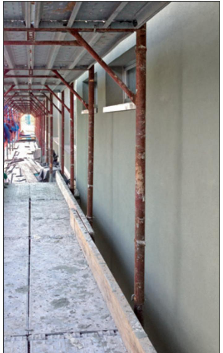
Rivestimento a cappotto esterno con applicazione di pannelli in sughero biondo naturale superkompatto SoKoVerd.LV a grana fine 2/3mm dallo spessore di 4cm mediante adesivo a presa rapida PraKov. Rasatura sopra i pannelli in sughero con intonaco minerale di spessoramento KoMalt.G.
