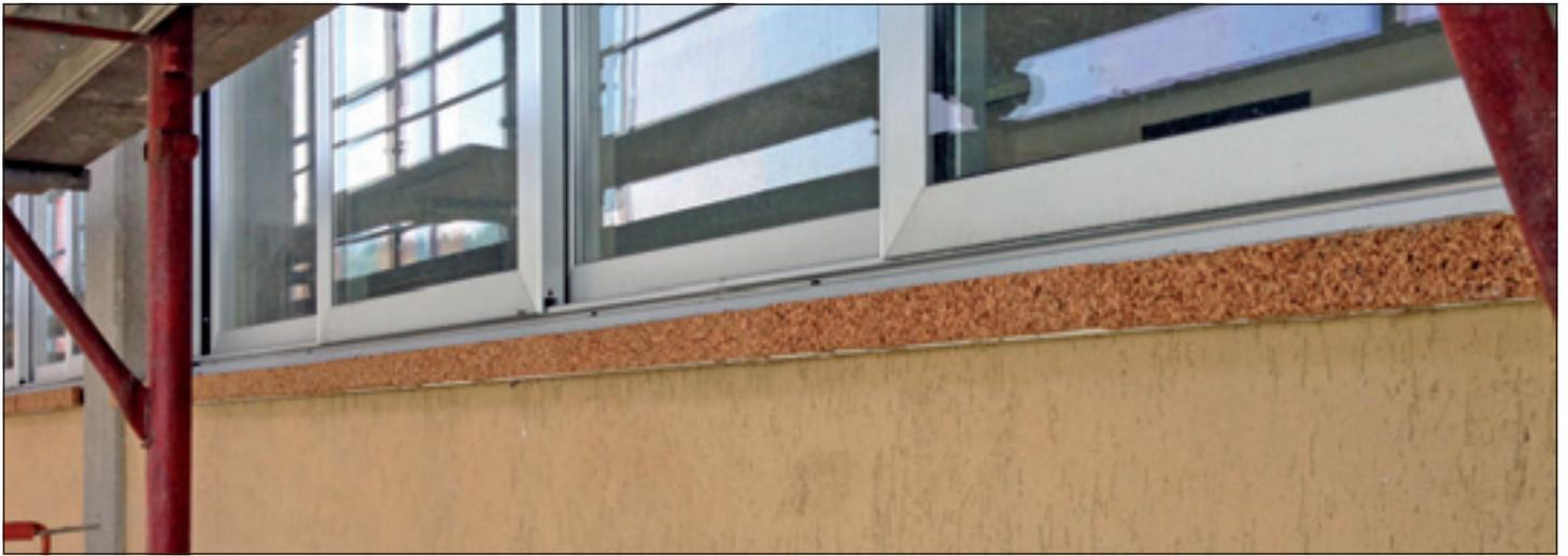
Rivestimento a cappotto esterno con applicazione di pannelli in sughero biondo naturale superkompatto SoKoVerd.XL a grana media 4/8mm dallo spessore di 8cm mediante adesivo a presa rapida PraKov. Particolare dell'applicazione dei pannelli in sughero biondo naturale superkompatto SoKoVerd.LV a grana fine 2/3mm sotto il davanzale per eliminare i ponti termici.
