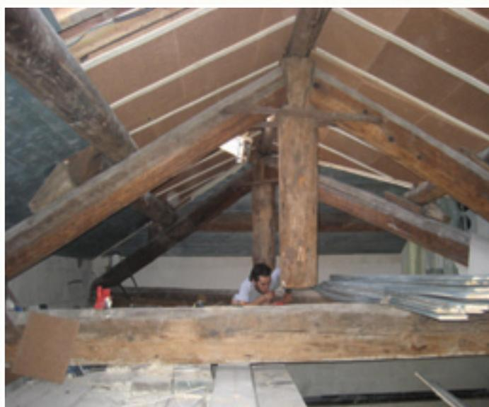
Isolamento intradosso solaio di copertura con doppio strato di pannelli in sughero biondo naturale superkompatto SoKoVerd.LV a grana fine 2/3mm sul soffitto con finitura a perline.
