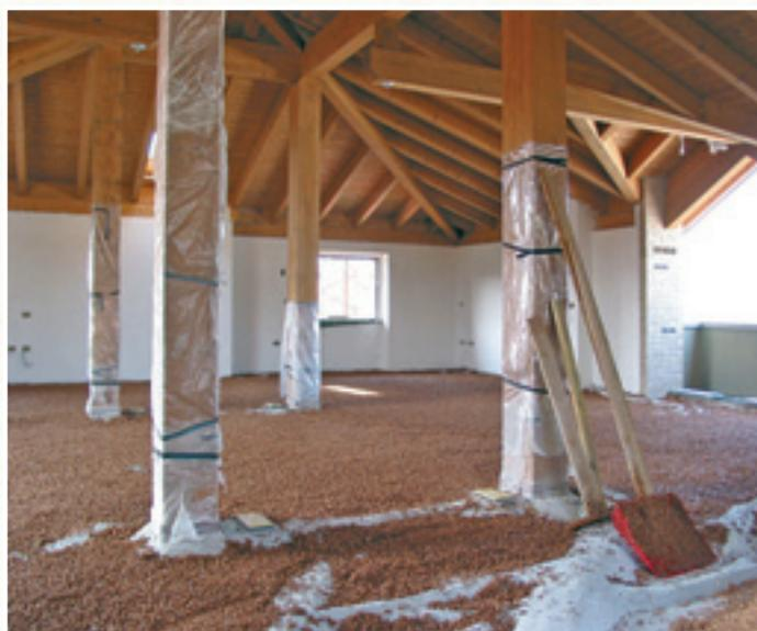
Sottofondo con impasto di sughero biondo naturale bollito e ventilato SugheroLite Costante con legante vetrificante a presa aerea KoGlass a copertura degli impianti.
