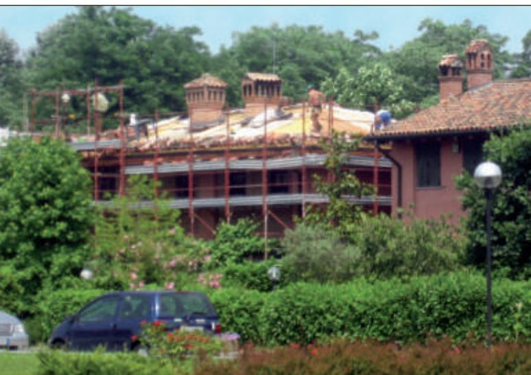
*Ristrutturazione della copertura in legno con stesura sull'assito di strato separatore traspirante KoSep.G. Creazione di un secondo assito distanziato da listoni con riempimento di granuli in sughero biondo naturale bollito e ventilato SugheroLite Costante 4mm.*
