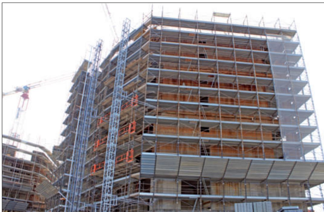
*Torri del Faro Genova. Protezione termoigrometrica della facciata con pannelli in sughero biondo naturale compresso SoKoVerd.AF a grana media 4/8mm mediante getto in contro cassero su cui verrà applicato il rivestimento a facciata ventilata.*
