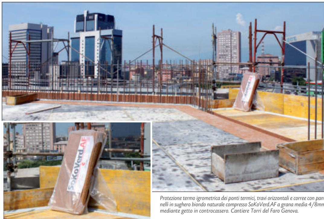
Protezione termo igrometrica dei ponti termici, travi orizzontali e corree con pannelli in sughero biondo naturale compresso SoKoVerd.AF a grana media 4/8mm mediante getto in controcesso. Cantiere Torri del Faro Genova.
