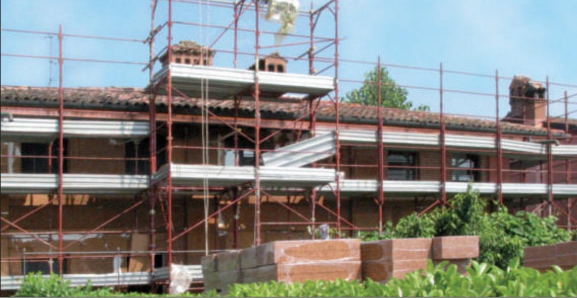
Rivestimento con sistema di isolamento termico a cappotto esterno BioVerd eseguito con pannelli in sughero biondo superkompacto SoKoVerd.XL applicato con adesivo a presa rapida PraKov. Sopra il rivestimento in sughero è stato eseguito un intonaco di spessoramento KoMalt.G e la finitura ai silicati di potassio KoSil e nella parte centrale i listelli di paramano ancorati sul cappotto BioVerd (vedi foto a lato).
