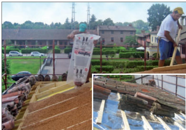
*Al di sopra strato di strato separatore traspirante KoSep.G, pannelli di sughero biondo naturale supercompattato SoKoVerd.LV a grana fine 2/3mm, listellatura in legno, strato separatore termoriflettente KoSep.IR e manto di copertura.*
