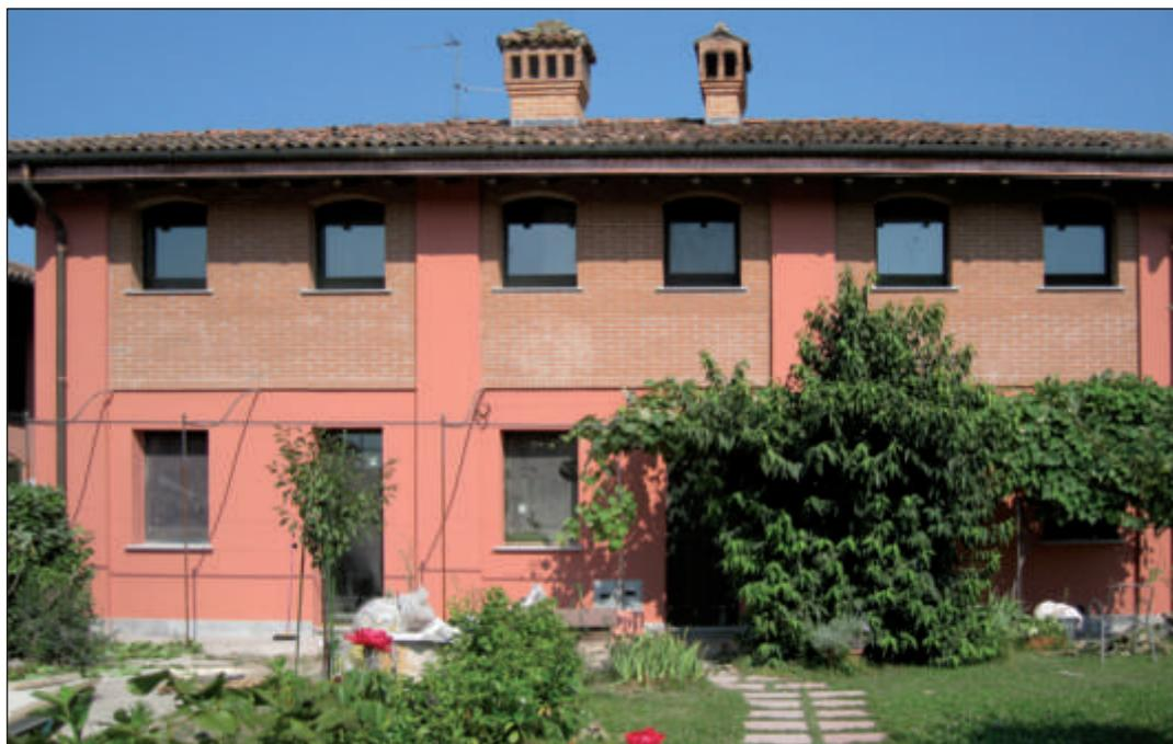
*Intervento di riqualificazione energetica con isolamento della copertura, rivestimento a cappotto in sughero biondo BioVerd e serramenti.*
