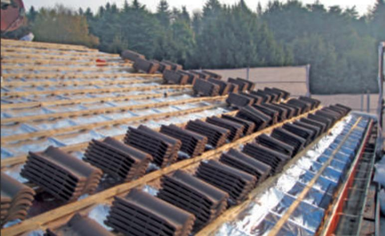
Sopra l'isolamento in sughero, creazione di ventilazione mediante la doppia listellatura in legno con legno e strato separatore impermeabile traspirante e termoriflettente KoSep.IR atto a ricevere il manto di copertura. Residenza Arch. Pietro Cinquesanti - Montorfano (CO).
