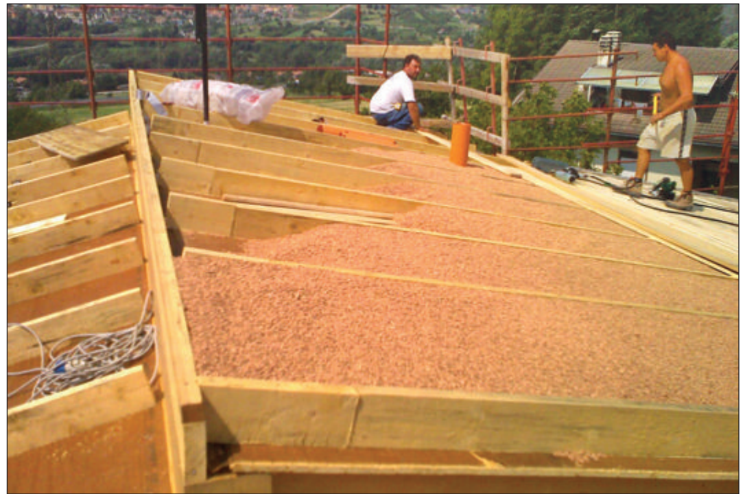
Copertura in legno con stesura sull'assito di carta oleata KoSep.C. Creazione di un secondo assito in legno distanziato da listoni con riempimento di granuli in sughero biondo naturale bollito e ventilato SugheroLite Costante 4mm.
