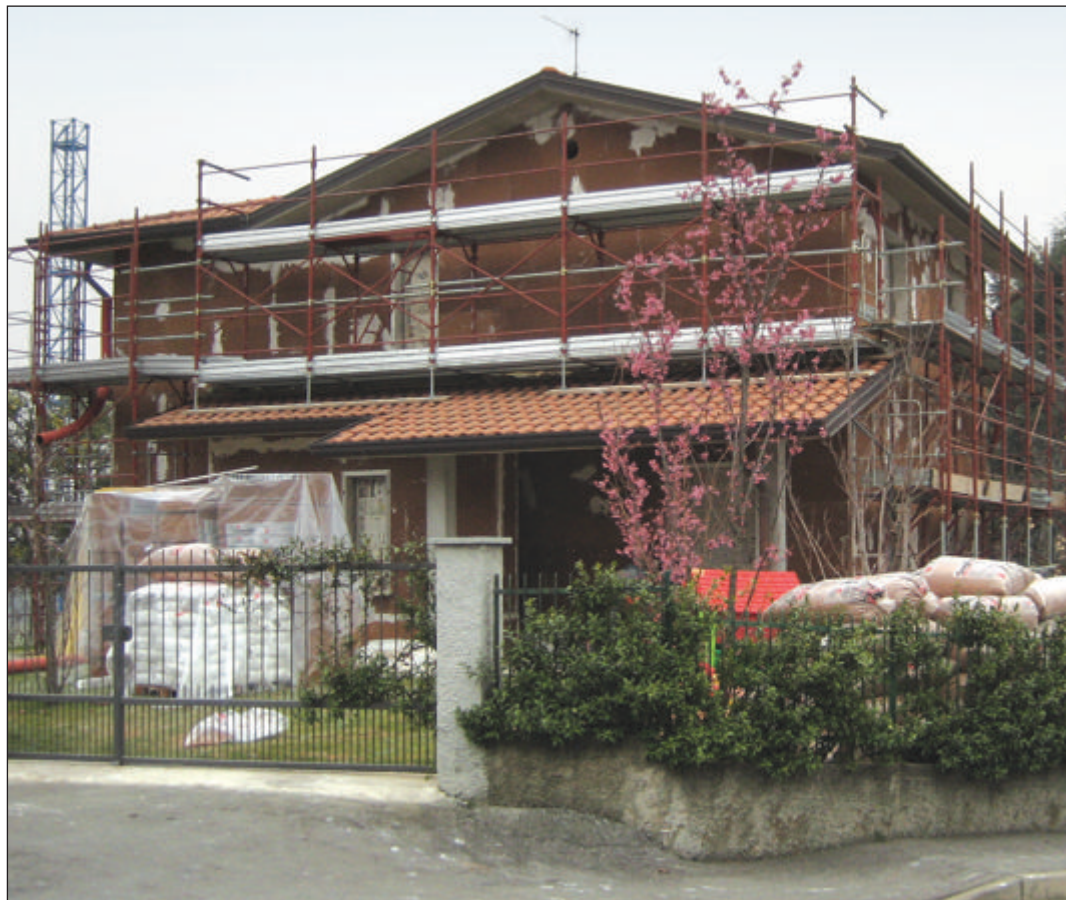
Ristrutturazione delle facciate mediante rivestimento a cappotto in sughero biondo BioVerd.
