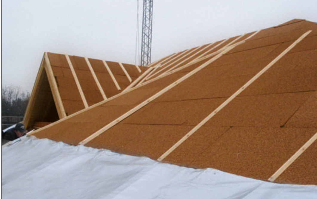
Copertura in legno mediante la posa di, doppio strato in pannelli di sughero biondo naturale superkompatto SoKoVerd.LV a grana fine 2/3mm, listellatura in legno e strato separatore termoriflettente KoSep.IR.
