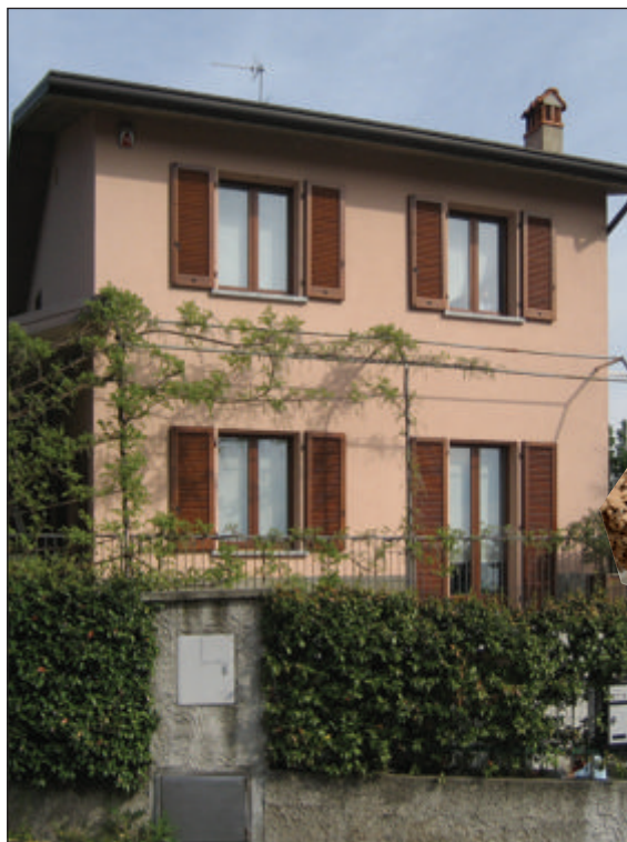
Sopra il rivestimento in sughero BioVerd è stato eseguito un intonaco di spessoramento KoMalt.G e la finitura ai silicati di potassio KoSil.
