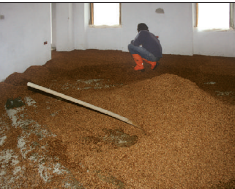
Fase impasto di sughero biondo naturale bollito e ventilato SugheroLite Costante 4mm con legante vetrificante a presa aerea KoGlass.
