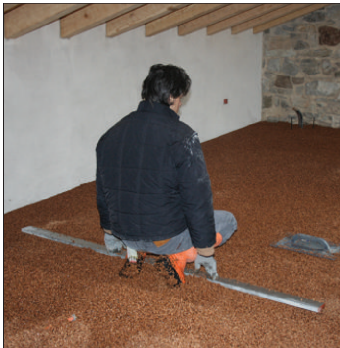
Fase stagnatura impasto di sughero biondo naturale bollito e ventilato SugheroLite Costante 4mm con legante vetrificante a presa aerea KoGlass.
