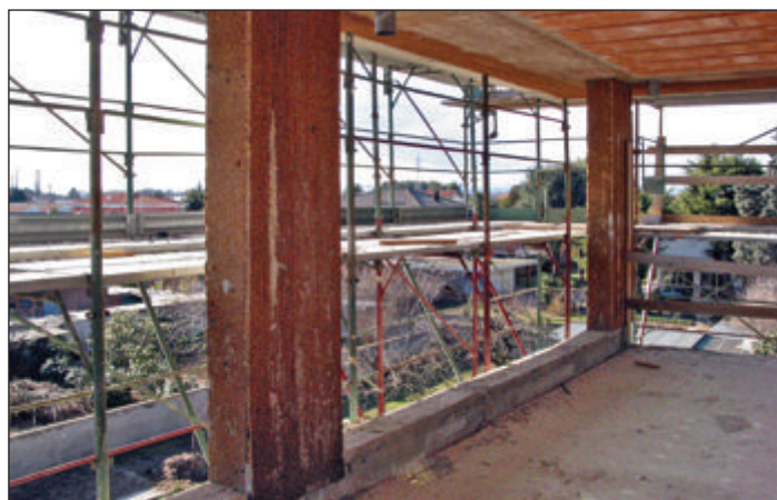
Protezione termo igrometrica dei ponti termici, travi orizzontali e pilastri con pannelli in sughero biondo naturale compresso SoKoVerd.AF a grana media 4/8mm mediante getto in controscasso.
