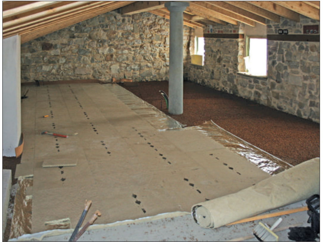
Solaio isolato con impasto di sughero biondo naturale bollito e ventilato SugheroLite Costante con legante vetrificante a presa aerea KoGlass e strato separatore anticalpestio termoriflettente KoSep.LIR, strisce KoFlex lungo il perimetro delle pareti, pannello in legno KoSial pronto per ricevere il riscaldamento a pavimento.
