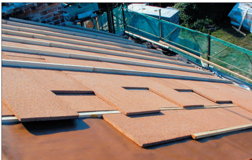
Particolare posa di doppio strato di pannelli in sughero biondo naturale superkompatto SoKoVerd.LV a grana fine 2/3mm.
