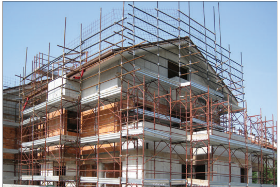
Protezione termoigrometrica dei ponti termici con pannelli in sughero biondo naturale compresso SoKoVerd.AF a grana media 4/8mm mediante getto in controcassero. Cantiere Via Ludovica Oreno di Vimercate (MI) - Impresa Restaura srl Vimercate (MI).
