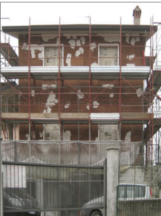
Rivestimento eseguito con pannelli in sughero biondo superkompattato SoKoVerd.LV applicato con adesivo a presa rapida PraKov.
