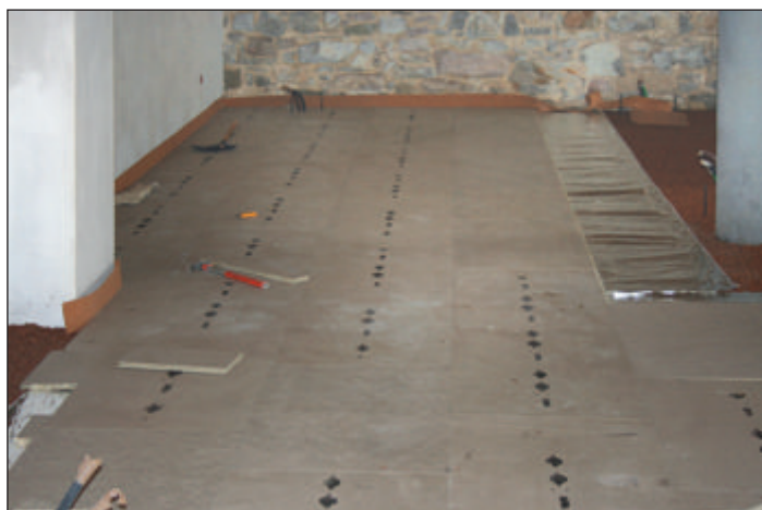
Particolare del sottofondo di stratigrafia del pacchetto Coverd atto a ricevere il riscaldamento a pavimento.
