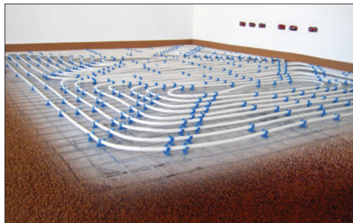
Soffondo isolato con impasto di sughero biondo naturale bollito e ventilato SugheroLite Costante con legante vetrificante a presa aerea KoGlass di elevato spessore a copertura degli impianti. Al di sopra posa di strato separatore anticalpestio KoSep.L, rete elettrosaldata KoSteel con agganciate le tubazioni del riscaldamento con clips a pavimento e strisce KoFlex lungo il perimetro delle pareti.
