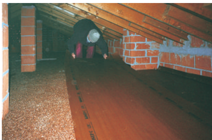
Isolamento del sottotetto mediante la posa a secco di sughero biondo naturale bollito e ventilato SugheroLite Costante.
