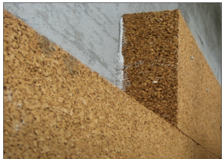
Rivestimento: sistema di isolamento termico a cappotto esterno in sughero biondo naturale BioVerd.
