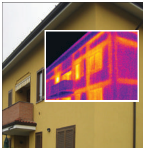
Analisi edificio dall'esterno, dove sono evidenti dall'immagine IR le dispersioni termiche
