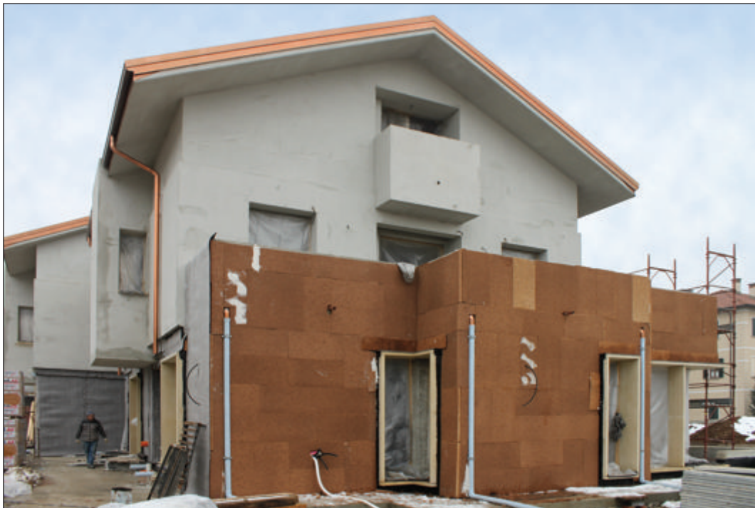
Rivestimento a cappotto in sughero biondo naturale BioVerd, a protezione del cemento armato.
