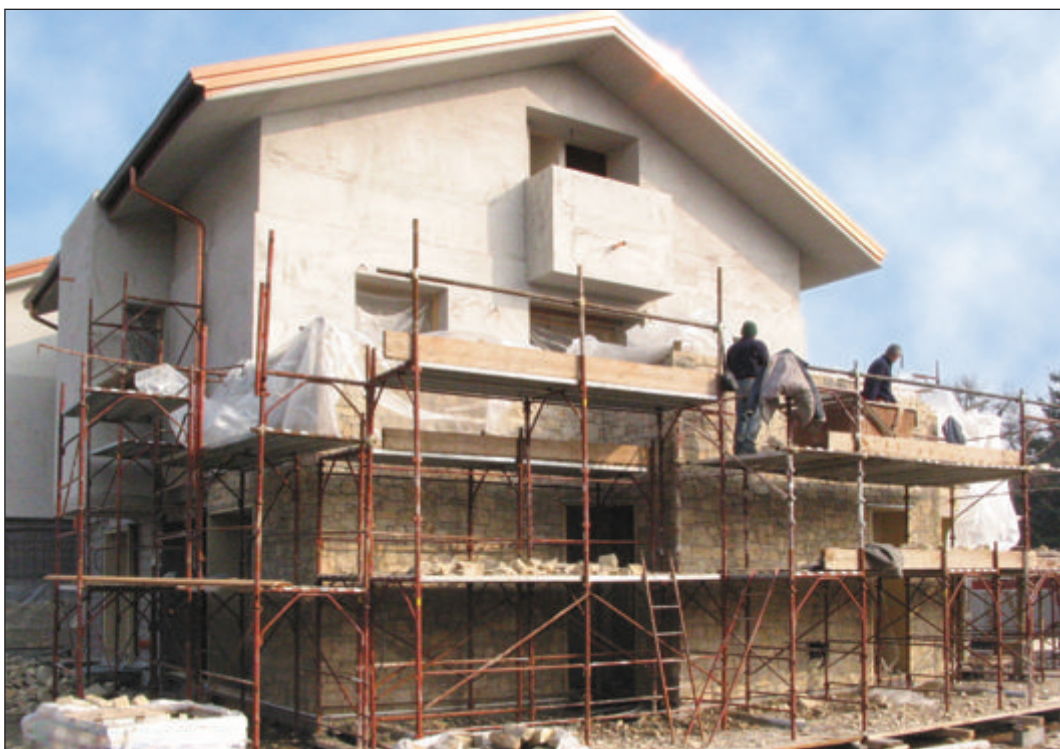
Finitura con pietra sopra il rivestimento a cappotto in sughero biondo naturale BioVerd.
