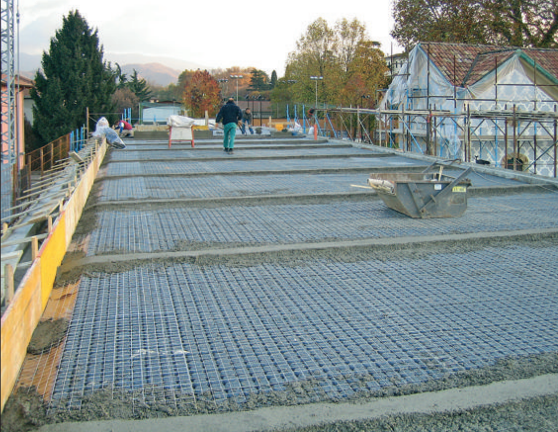
Realizzazione getto copertura piana dove si poserà il manto impermeabile e il pacchetto della copertura verde.
