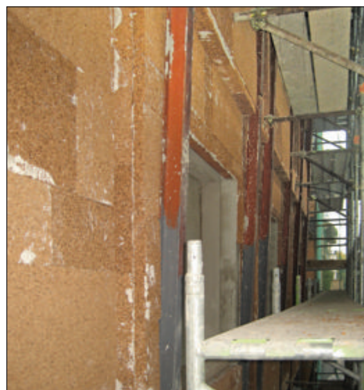
Particolari del rivestimento eseguito con pannelli in sughero biondo superkompacto SoKoVerd.LV applicato alla parete interna con adesivo a presa rapida PraKov. In una seconda fase si è realizzato l'accoppiamento di una struttura metallica per la formazione della facciata ventilata inclinata.
