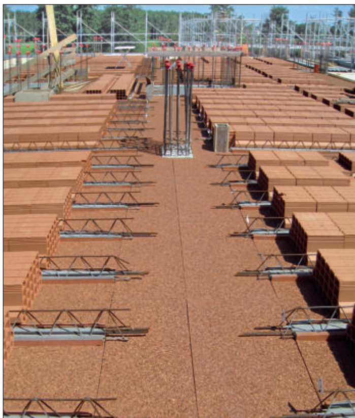
Protezione termoisolante delle travi orizzontali in CA con pannelli in sughero biondo naturale compresso SoKoVerd.AF a grana media 4/8mm mediante getto in controscasso.
