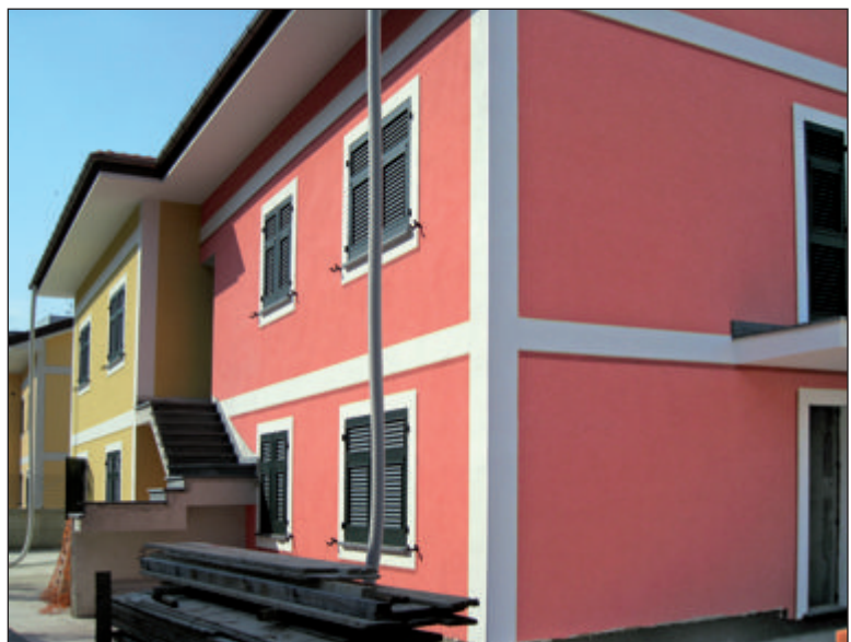
Rivestimento a cappotto esterno BioVerd: applicazione di pannelli in sughero biondo naturale SoKoVerd.XL con adesivo a presa rapida PraKov, intonaco di spessoramento KoMalt.G con affogata rete KoRet e finitura con intonaco ai silicati silanizzati KoSil.S. Il cappotto BioVerd permette di realizzare finiture con colori scuri.
