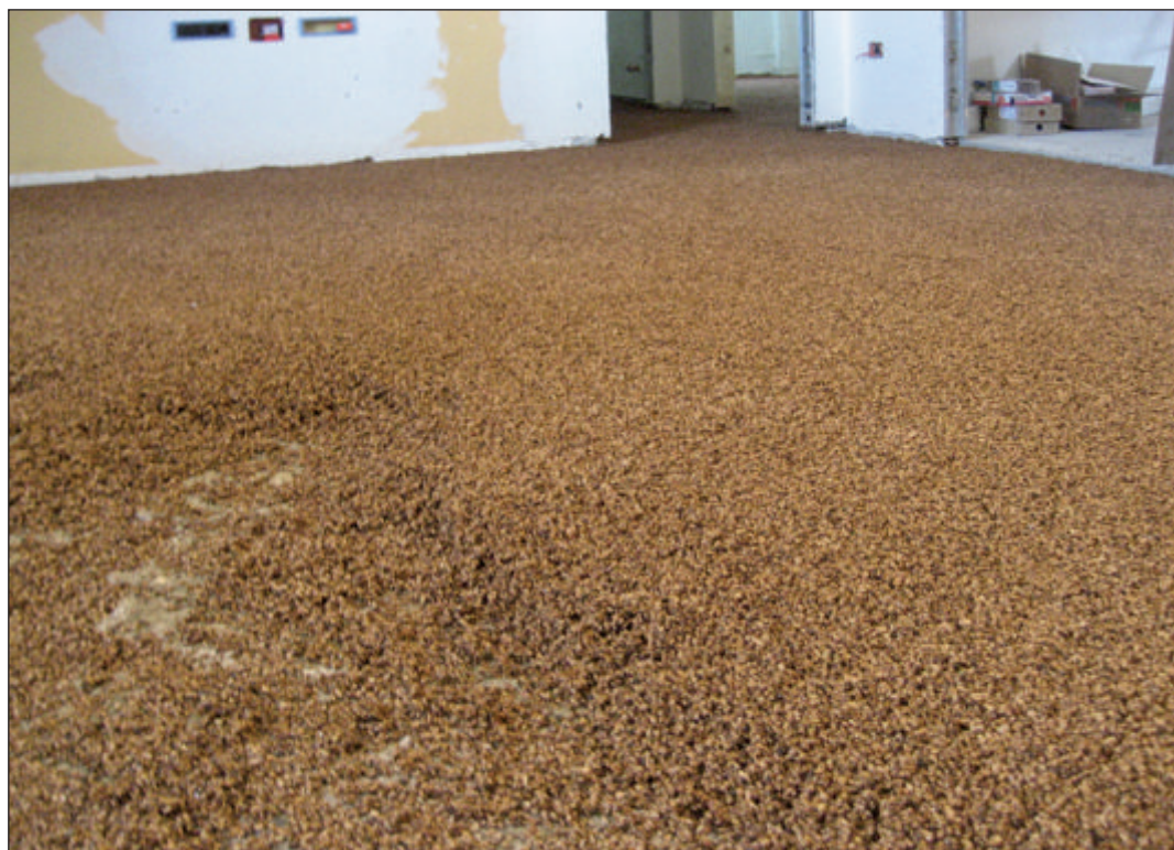
Sottofondo isolato mediante impasto di sughero biondo naturale bollito e ventilato SugheroLite Costante con legante vetrificante a presa aerea KoGlass di elevato spessore a copertura degli impianti.
