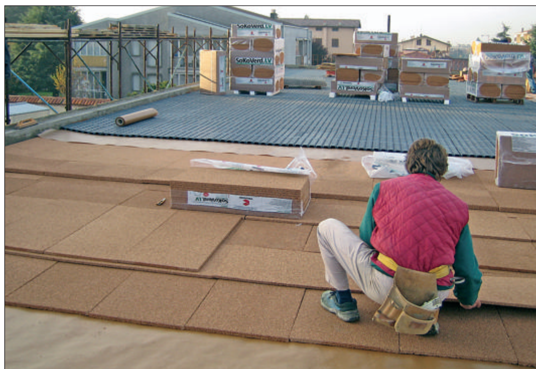
Copertura piana ventilata con posa di carta oleata KoSep.C, triplo strato di pannelli in sughero biondo naturale prebollito superkompacto SoKoVerd.LV a grana fine 2/3mm spessore complessivo di 10cm e strato di carta oleata KoSep.C. Posa di pannelli preformati dallo spessore di 3cm per creare la ventilazione.
