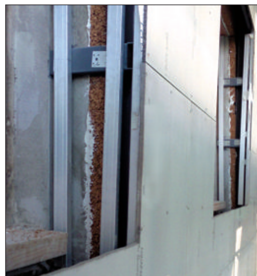
Particolari del rivestimento eseguito con pannelli in sughero biondo superkompacto SoKoVerd.LV applicato alla parete interna con adesivo a presa rapida PraKov. In una seconda fase si è realizzato l'accoppiamento di una struttura metallica per la formazione della facciata ventilata inclinata.
