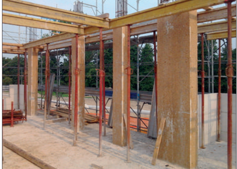
Protezione termoisolante di pilastri e lame in CA mediante getto in controscasso con pannelli in sughero biondo naturale compresso SoKoVerd.AF a grana media 4/8mm.
