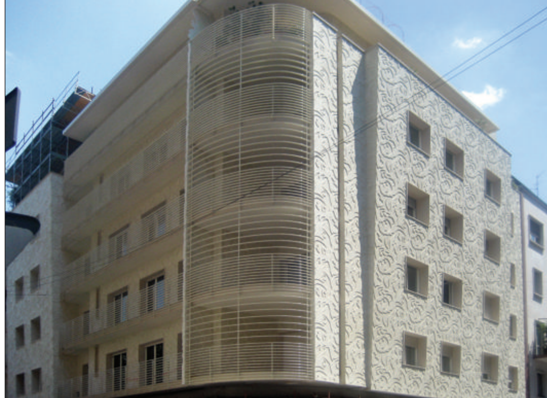
Spettacolare facciata d'autore, significativo intervento di "ArtEdilizia" realizzato in Via Cappuccini 2 a Milano. Per soddisfare l'esigenza creativa del progetto è stato necessario sviluppare tecniche strutturali innovative. L'esperienza Coverd ha contribuito con le sue avanzate tecnologie applicative.
