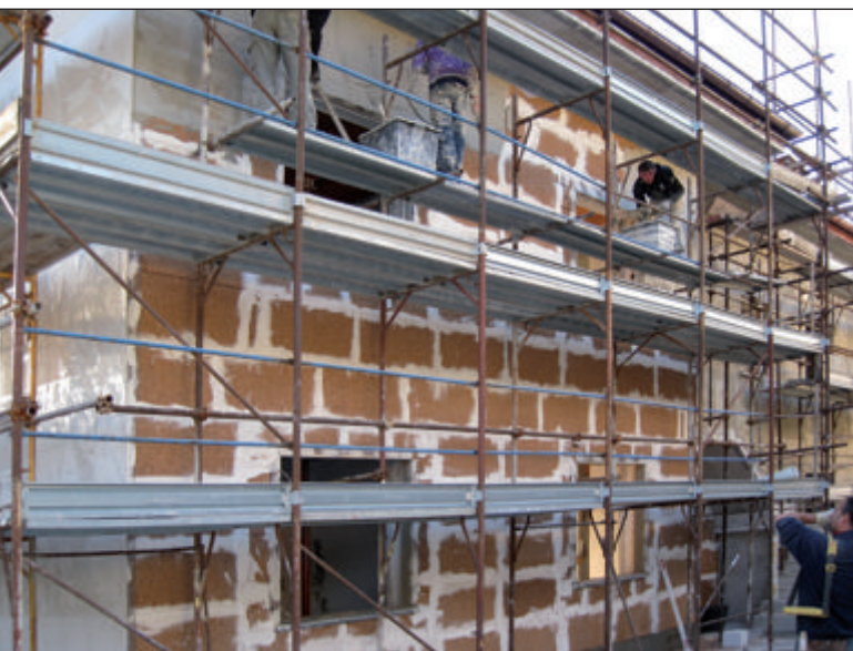
Rivestimento a cappotto esterno BioVerd: applicazione di pannelli in sughero biondo naturale SoKoVerd.XL con adesivo a presa rapida PraKov, intonaco di spessoramento KoMalt.G con affogata rete KoRet e finitura con intonaco ai silicati silanizzati KoSil.S. Il cappotto BioVerd permette di realizzare finiture con colori scuri.
