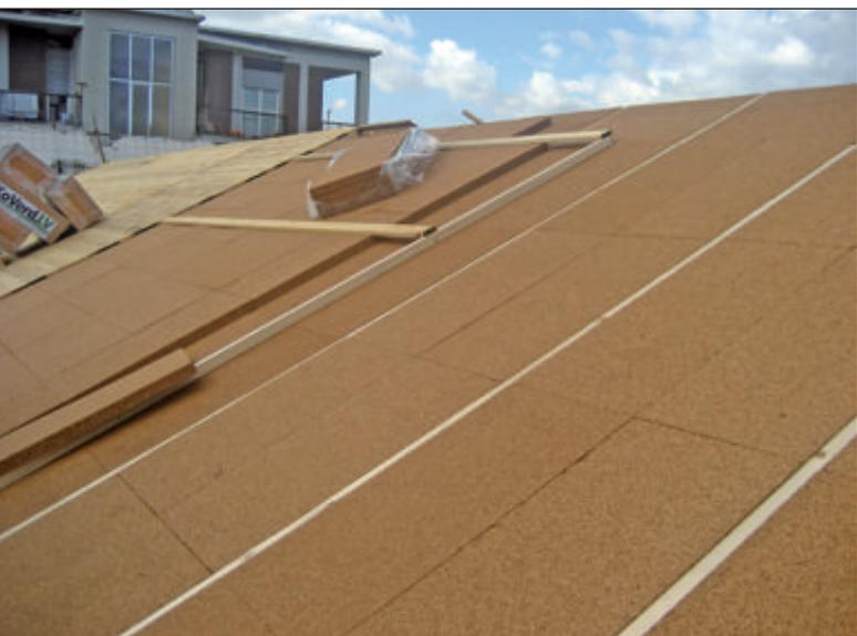
Realizzazione copertura in legno mediante la posa triplo strato di sughero biondo naturale prebollito superkompatto SoKoVerd.LV a grana fine 2/3mm, assito di legno e successiva posa di strato separatore termo riflettente KoSep.IR.
