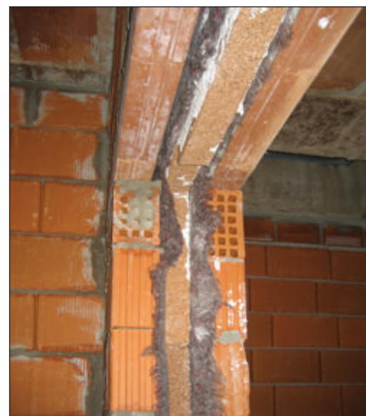
Parete divisoria costituita da blocchetti fonici in laterizio NK12L e NK8L con inserito nell'intercapedine doppio strato di ovatta vegetale KoFIVeg, pannello in sughero biondo naturale superkompatto SoKoVerd.LV a grana fine 2/3mm. Strisce in sughero biondo supercompresso Koflex sotto e sopra i tavolati.
