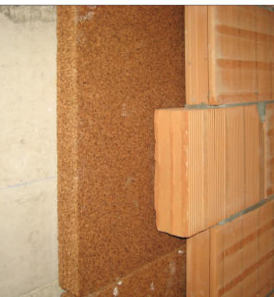
Protezione termoigrometrica del cemento armato mediante cappotto con pannelli in sughero biondo superkompatto SoKoVerd.LV a grana fine 2/3mm e controtavolato. Impresa costruzioni Tonale.
