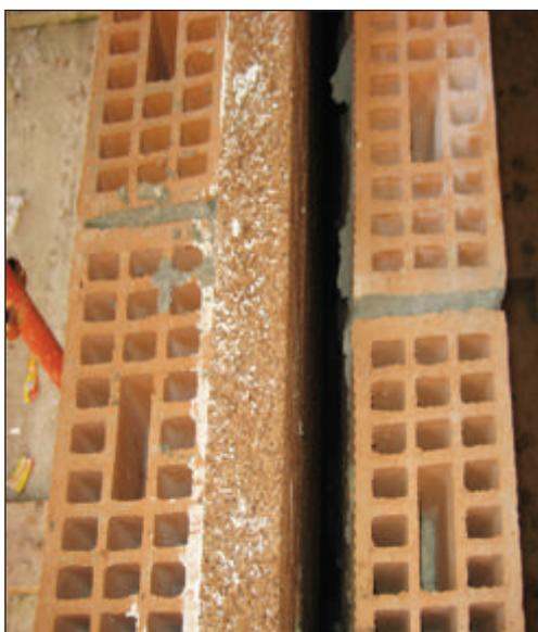
Isolamento posto nell'intercapedine realizzato con pannelli in sughero biondo naturale superkompatto SoKoVerd.LV a grana fine 2/3mm. Impresa costruzioni Tonale - Concorezzo (MI).
