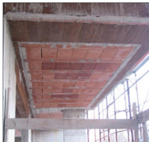
Protezione termo igrometrica dei ponti termici, travi orizzontali, balconi e corree, con pannelli in sughero biondo naturale compresso SoKoVerd.AF a grana media 4/8mm mediante getto in controciassetto. Nell'intercapedine delle pareti inserimento di pannelli in sughero biondo naturale compresso SoKoVerd.AF a grana media 4/8mm.
