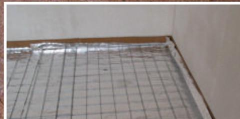
*Solaio isolato con pannello in sughero biondo naturale superkompacto SoKoVerd.LV a grana fine 2/3mm. Al di sopra posa di strato separatore anticalpestio termoriflettente KoSep.Lir, rete elettrosaldata KoSteel con agganciate le tubazioni del riscaldamento a pavimento mediante clips e strisce KoFlex lungo il perimetro delle pareti. Nei solai senza il riscaldamento a pavimento, posa di strato separatore anticalpestio KoSep.L.*
