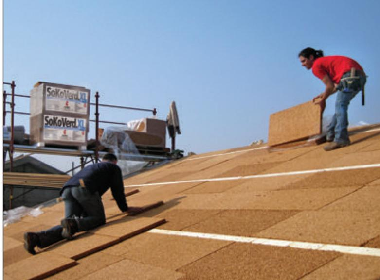
Copertura in cemento ventilata mediante la posa di doppio strato in pannelli di sughero biondo naturale SoKoVerd.XL ad elevato spessore.
