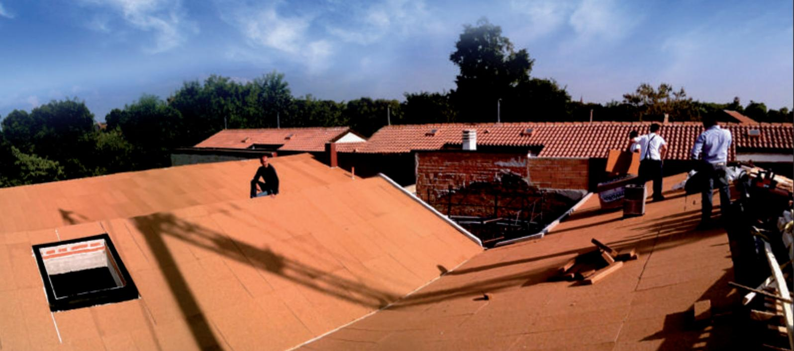
Copertura in latero cemento mediante la posa di doppio strato in pannelli di sughero biondo naturale superkompacto SoKoVerd.LV a grana fine 2/3mm. Sopra l'isolamento in sughero, creazione di ventilazione mediante la doppia listellatura in legno con strato separatore impermeabile traspirante e termoriflettente KoSep.IR atto a ricevere il manto di copertura.
