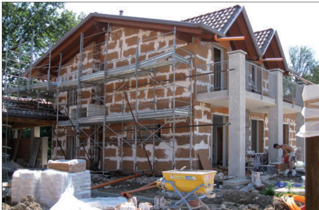
Rivestimento con sistema di isolamento termico a cappotto esterno BioVerd eseguito con pannelli in sughero biondo superkompacto SoKoVerd.XL di elevato spessore applicato con adesivo a presa rapida PraKov.
