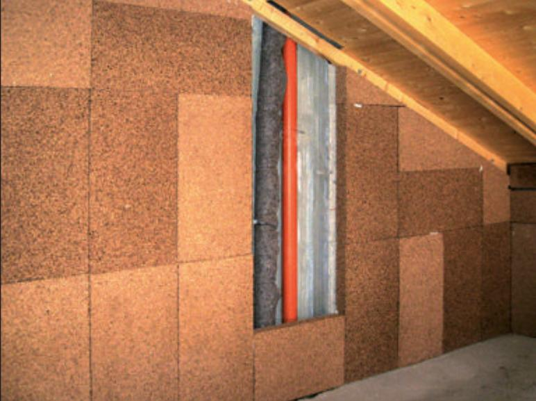
Cappotto interno mediante l'applicazione di pannelli in sughero biondo naturale SoKoVerd.XL ad elevato spessore con adesivo a presa rapida PraKov.
