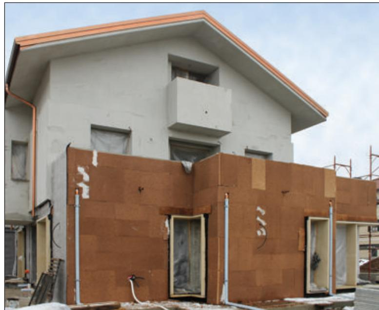
Rivestimento a cappotto esterno in sughero biondo naturale BioVerd, a protezione del cemento armato su cui verrà realizzato un rivestimento in pietra.
