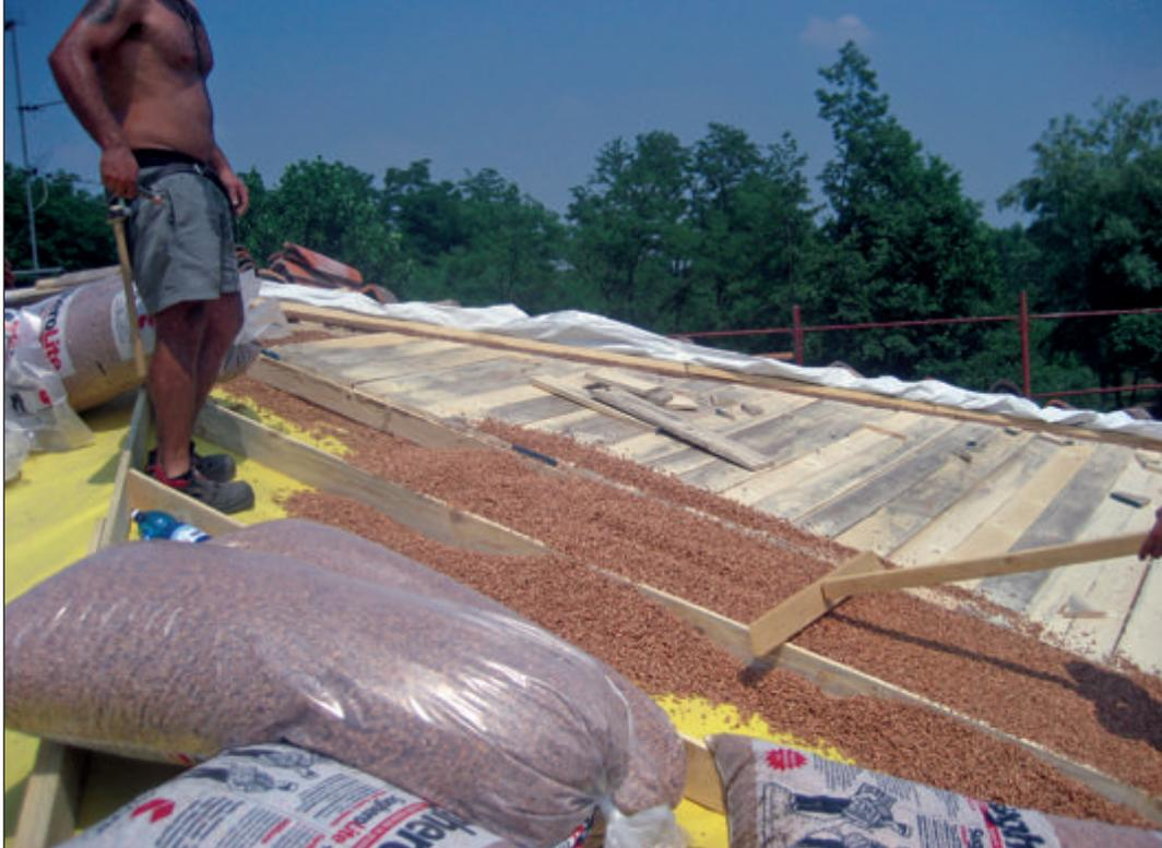
Ristrutturazione della copertura in legno con stesura sull'assito di strato separatore traspirante KoSep.G. Creazione di un secondo assito distanziato da listoni con riempimento di granuli in sughero biondo naturale bollito e ventilato SugheroLite Costante 4mm. Al di sopra, strato separatore traspirante KoSep.G, pannelli di sughero biondo naturale superkompatto SoKoVerd.LV a grana fine 2/3mm, listellatura in legno, strato separatore termoriflettente KoSep.IR e manto di copertura.
