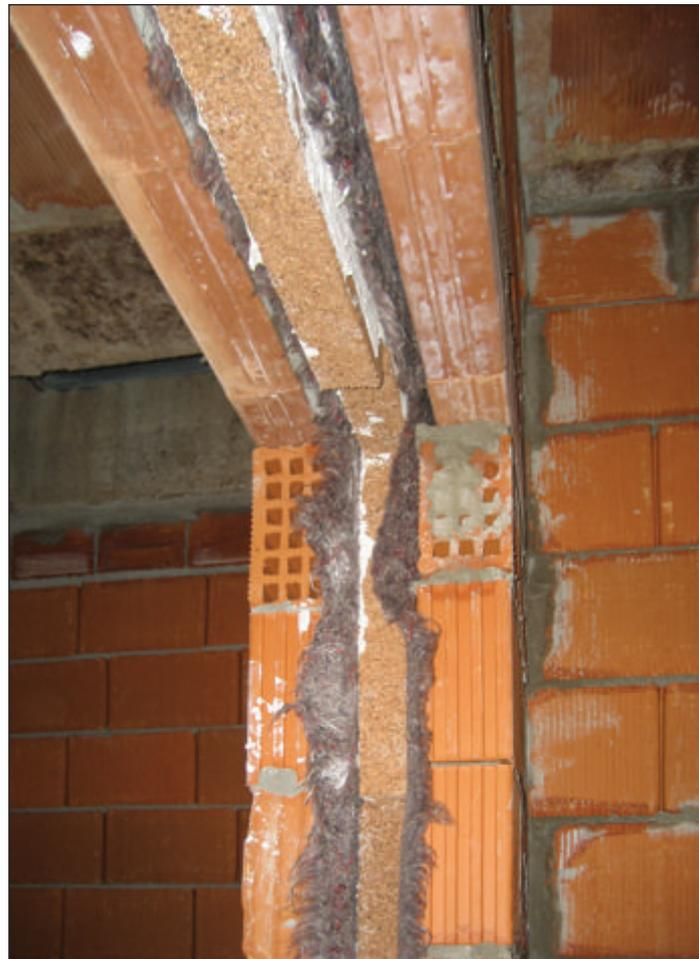
Parete divisoria costituita da blocchetti fonici in laterizio NK12L e NK8L con inserito nell'intercapedine doppio strato di ovatta vegetale KoFiVeg, pannello in sughero biondo naturale superkompatto SoKoVerd.LV a grana fine 2/3mm. Strisce in sughero biondo supercompresso KoFlex sotto e sopra i tavolati.
