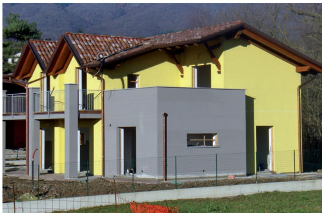
Sopra il rivestimento in sughero (vedi foto pagina 6) è stato eseguito un intonaco di spessoramento KoMalt.G e la finitura ai silicati di potassio KoSil.
