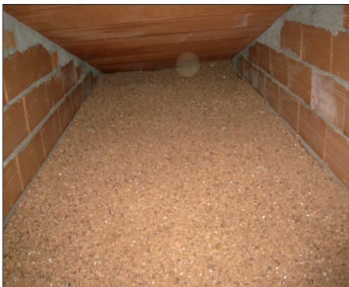
Sottotetto mediante la stesura di sughero biondo naturale in granuli bollito e ventilato SugheroLite Costante 4mm sciolto.
