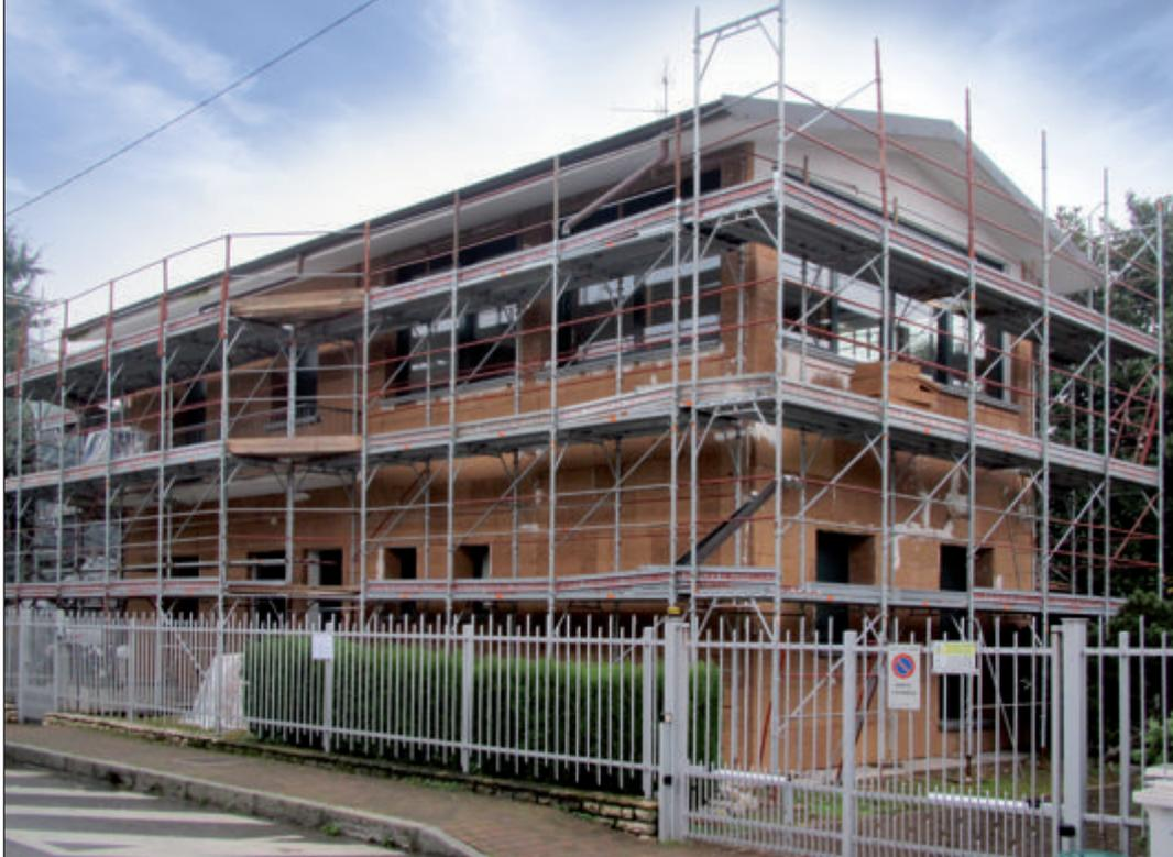
Riqualificazione energetica mediante isolamento termico a cappotto esterno in sughero biondo BioVerd.
