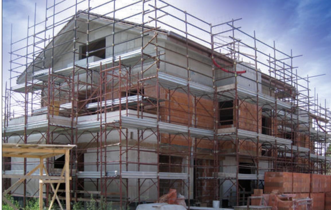
*Protezione termoigrometrica delle travi orizzontali e delle corree con pannelli in sughero biondo naturale compresso SoKoVerd.AF a grana media 4/8mm mediante getto in controcassero.*
