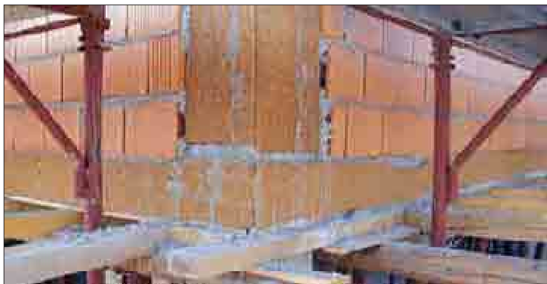
Particolare getto in controciassero dei pannelli in sughero biondo naturale compresso in AF SoKoVerd.AF su travi e corree
