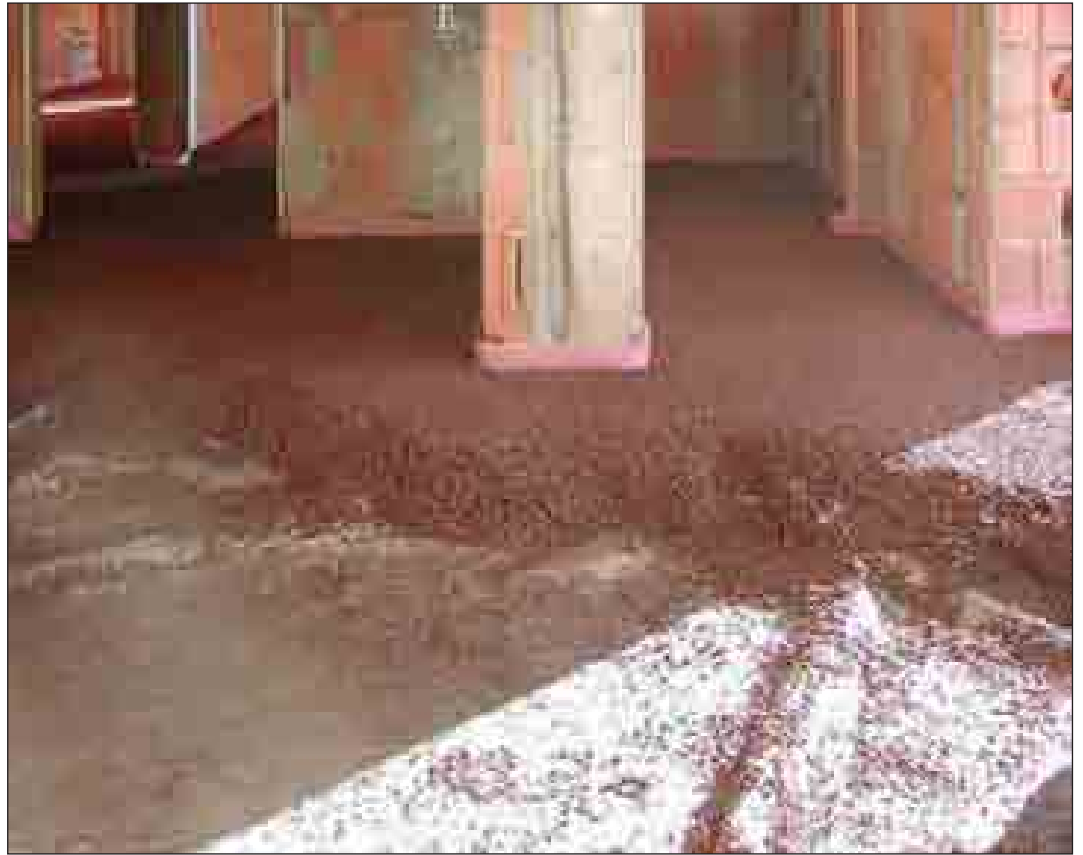
Sottofondo con impasto di granuli in sughero biondo naturale bollito e ventilato SugheroLite con legante vetrificante a presa aerea KoGlass. Inserimento nell'intercapedine di doppio pannello in sughero biondo naturale superkompatt SoKoVerd.LV
