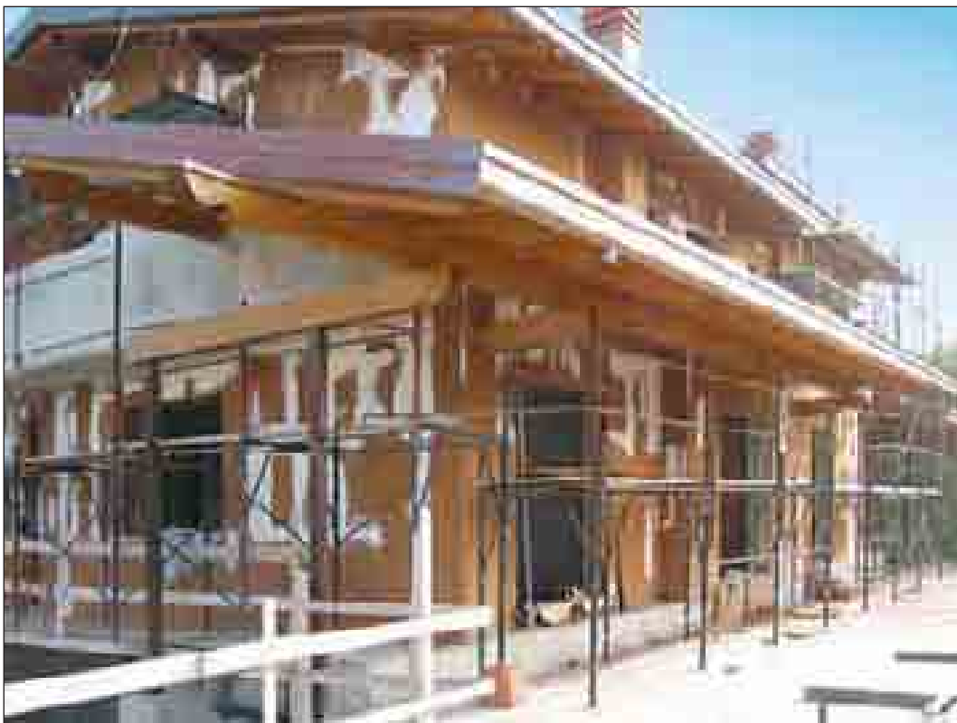
Rivestimento a cappotto esterno con pannelli in sughero superkompatto SoKoVerd.LV
