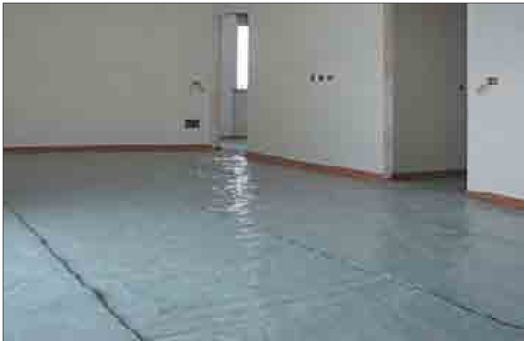
Particolare dello strato separatore anticalpestio KoSep.F completo di strisce in sughero supercompresso KoFlex lungo il perimetro del locale sopra l'impasto di SugheroLite+ KoGlass
