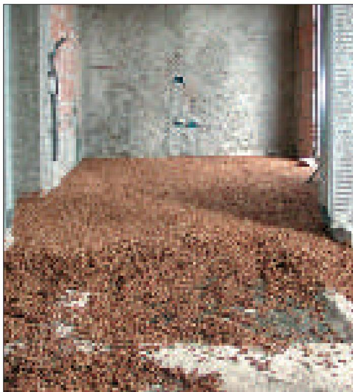
Sottofondo eseguito con impasto di sughero biondo naturale in granuli bollito e ventilato SugheroLite con vetrificante a presa aerea KoGlass
