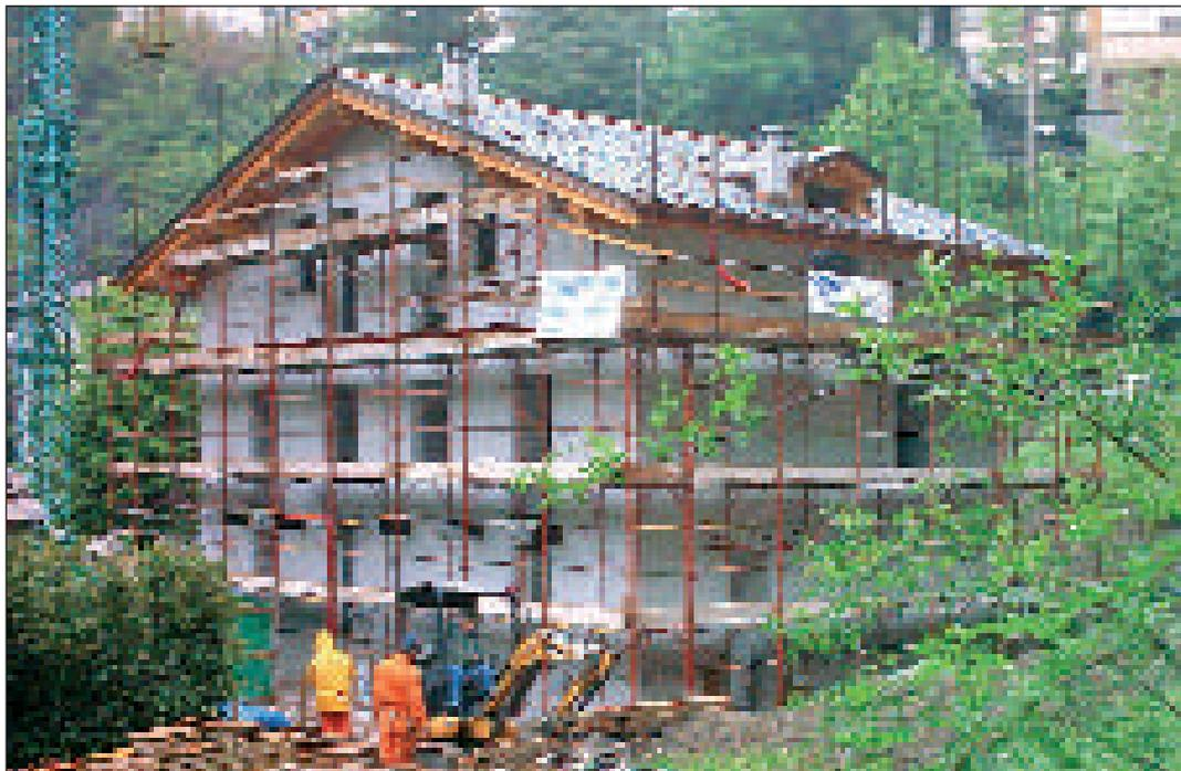
Intonaco di spessoramento con intonaco minerale KoMalt.G sui pannelli in sughero biondo naturale superkompatto SoKoVerd.LV
