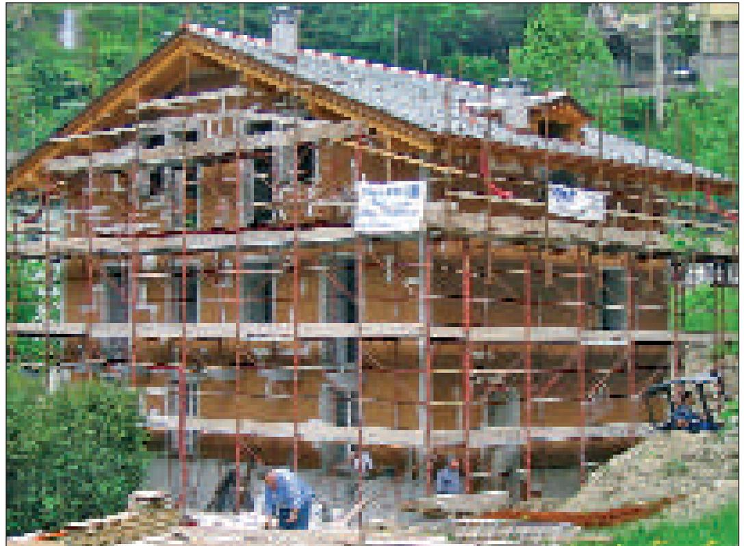
Rivestimento a cappotto esterno con ancoraggio pannelli in sughero biondo naturale superkompatto SoKoVerd.LV
