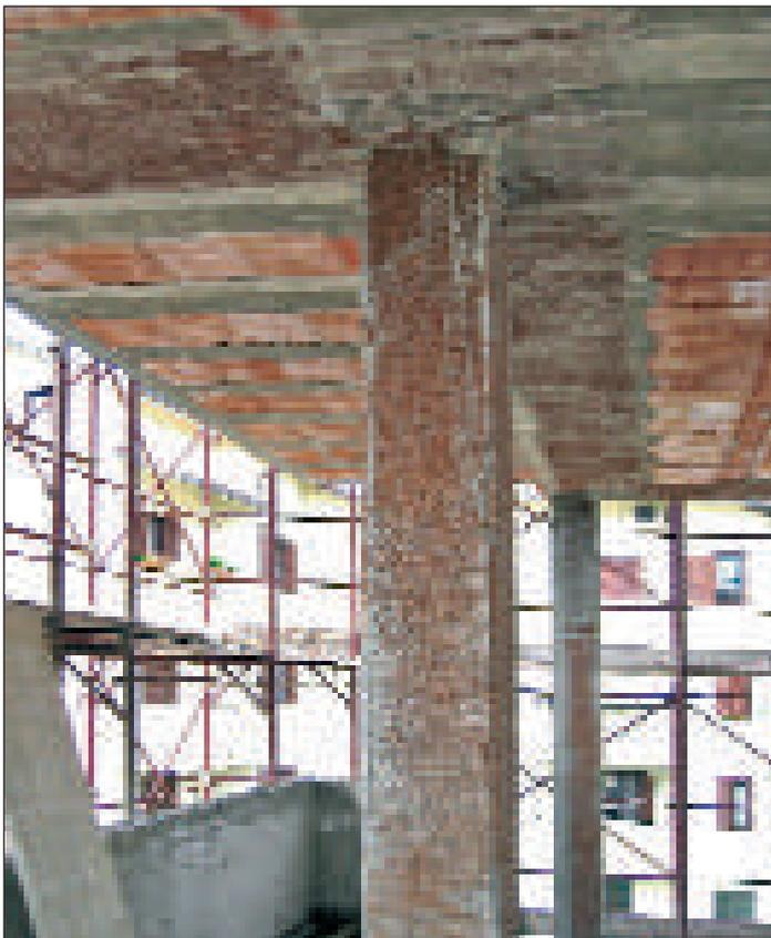
*Particolare di getto in controcassero di pilastri e travi con pannelli in sughero biondo naturale compresso SoKoVerd.AF*
