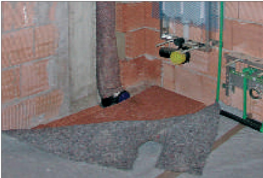
Particolare fasciatura impianti con sandwich di ovatta vegetale con anima di laminato smorzante FoniVeg. Inoltre particolare del sottofondo con pannello in sughero biondo naturale superkompatto SoKoVerd.LV e strato separatore anticalpestio KoSep.F Sandwich d'isolamento eseguito prima degli impianti
