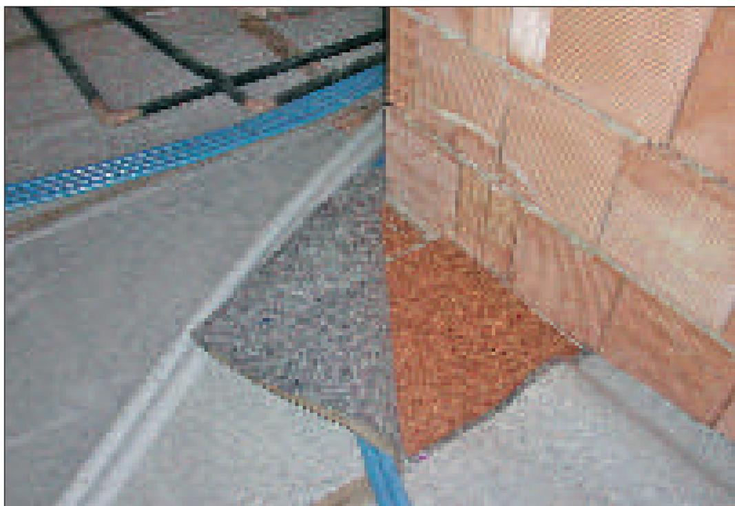
Particolare sottofondo con pannello in sughero biondo naturale supercompatto SoKoVerd.LV e strato separatore anticalpestio KoSep.F
