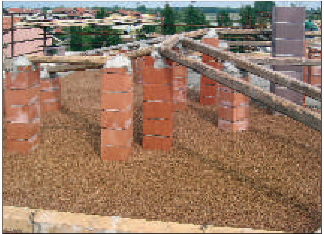
*Sottotetto con impasto di sughero biondo naturale in granuli bollito e ventilato SugheroLite con vetrificante a presa KoGlass*
