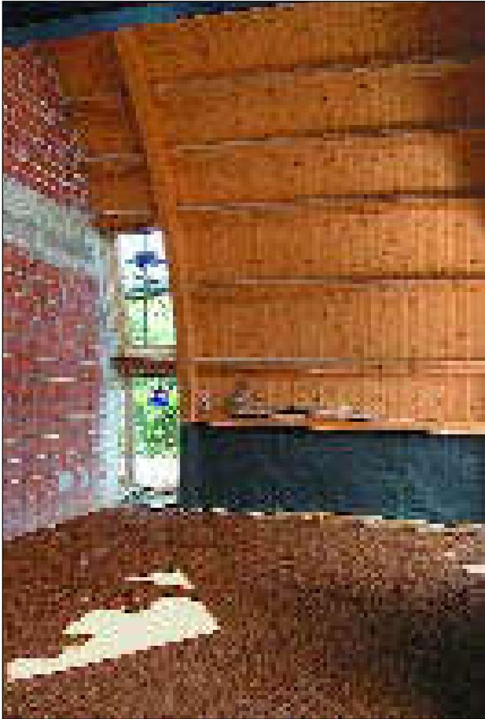
Sottofondo con impasto di granuli in sughero biondo naturale bollito e ventilato SugheroLite con vetrificante a presa aerea KoGlass.
