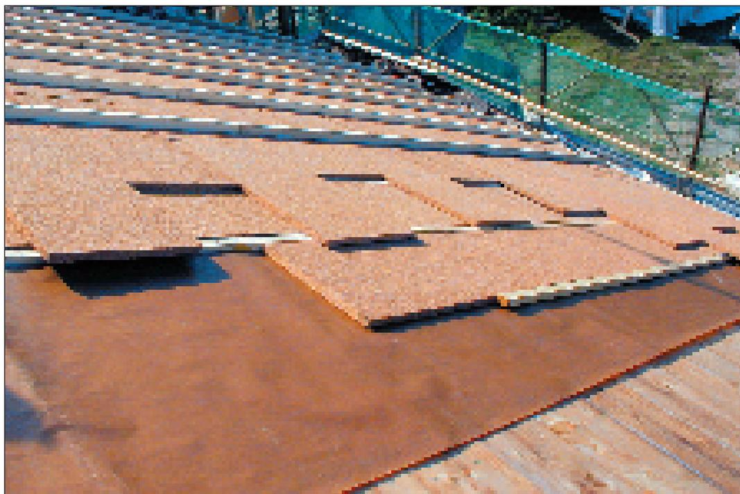
Tetto bioedile in legno con strato separatore traspirante di carta oleata KoSep.C e doppio strato di pannelli in sughero biondo naturale superkompatto SoKoVerd.LV a grana fine 2/3mm
