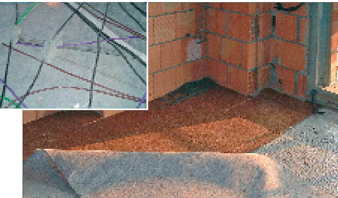
Sottofondo costituito da pannello in sughero biondo naturale superkompatto SoKoVerd.LV a grana fine 2/3mm, strato separatore anticalpestio KoSep.F, posa impianti, rete antifessurazione KoMax e strisce in sughero KoFlex lungo il perimetro.
