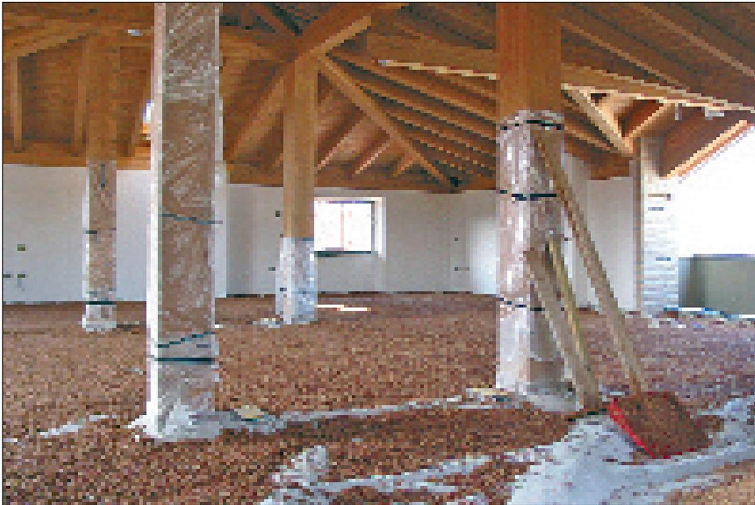
Sottofondo costituito da un impasto di sughero biondo naturale bollito e ventilato SugheroLite con legante a presa aerea KoGlass a copertura degli impianti.
