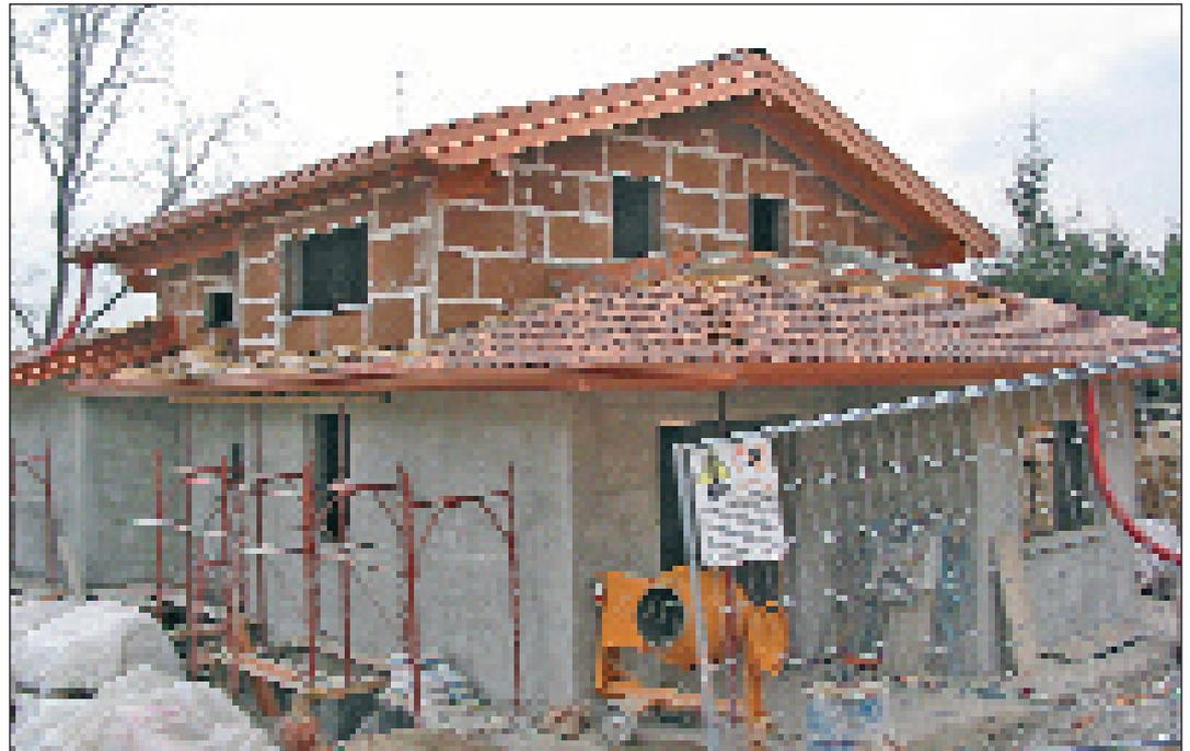
Rivestimento a cappotto esterno con ancoraggio pannelli in sughero biondo naturale superkompatto SoKoVerd.LV a grana fine 2/3mm
