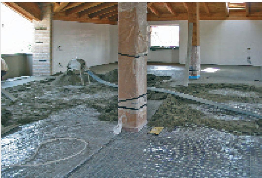
Al di sopra dell'impasto di SugheroLite+KoGlass, posa dello strato separatore anticalpestio KoSep.F, rete elettrosaldata KoSteel e strisce di sughero KoFlex lungo il perimetro.
