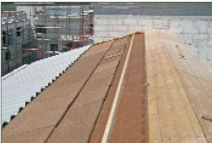
*Tetto bioedile in legno con stesura di strato separatore impermeabile e traspirante KoSep.C, doppio strato di pannelli in sughero biondo naturale superkompatto SoKoVerd.LV a grana fine 2/3mm e completamento con lastre ondulate in fibrocemento.*
