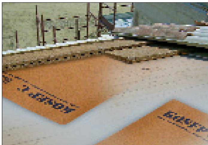
Tetto bioedile in legno con stesura di strato separatore impermeabile e traspirante KoSep.C, doppio strato di pannelli in sughero biondo naturale superkompatto SoKoVerd.LV a grana fine 2/3mm e completamento con lastre ondulate in fibrocemento e manto di copertura in coppi.
