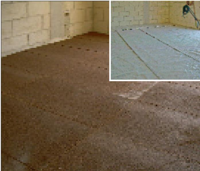
Sottofondo con pannelli in sughero biondo naturale compresso SoKoVerd.AF a grana media 4/8mm e stesura di strato separatore anticalpestio KoSep.F
