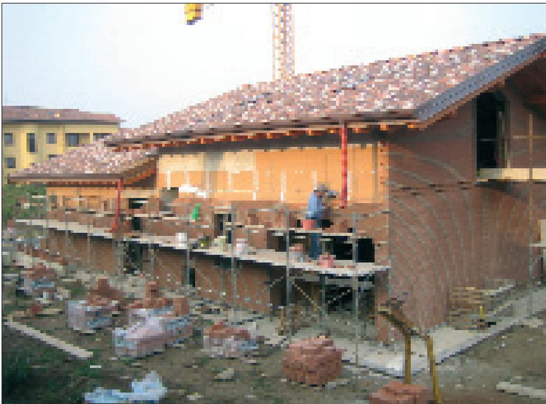
Rivestimento in paramano sui pannelli in sughero biondo naturale superkompatto SoKoVerd.LV a grana fine 2/3mm
