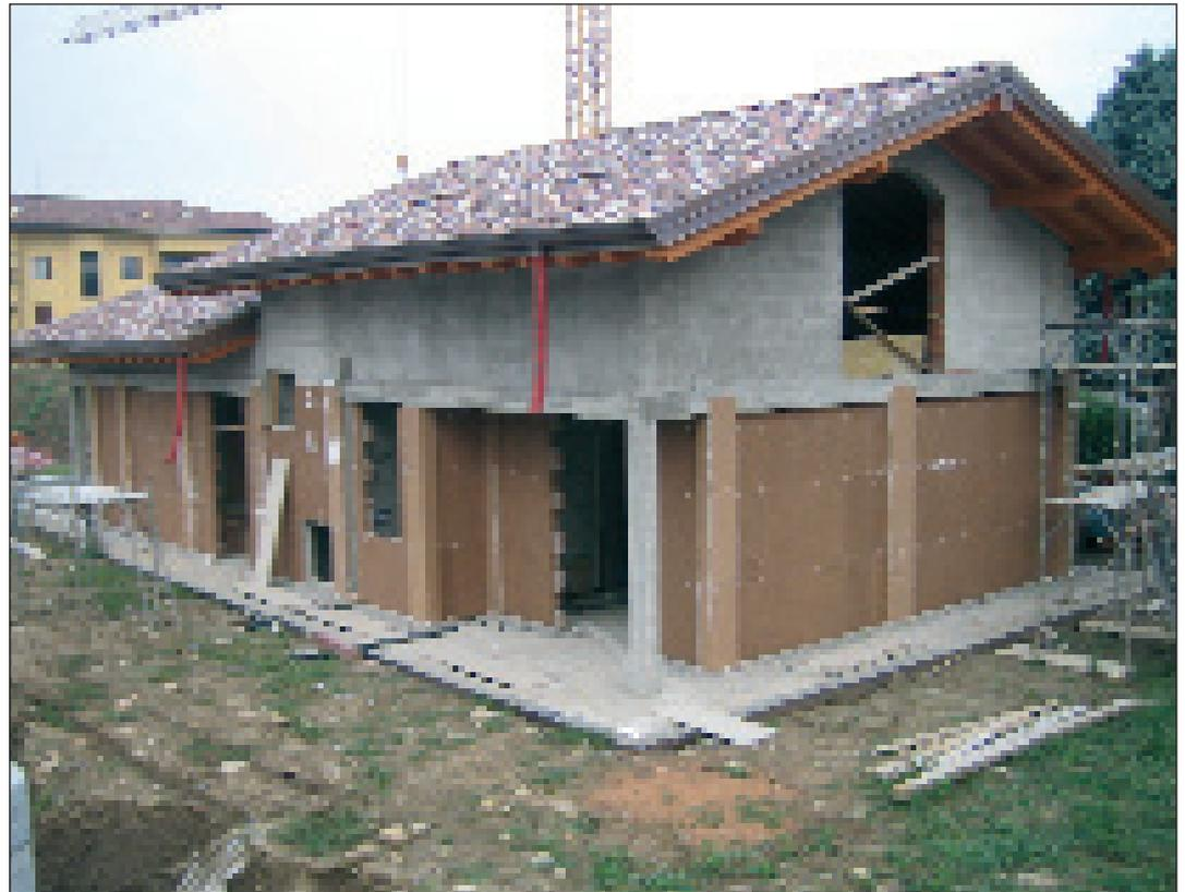
Rivestimento a cappotto esterno con ancoraggio pannelli in sughero biondo naturale superkompacto SoKoVerd.LV a grana fine 2/3mm
