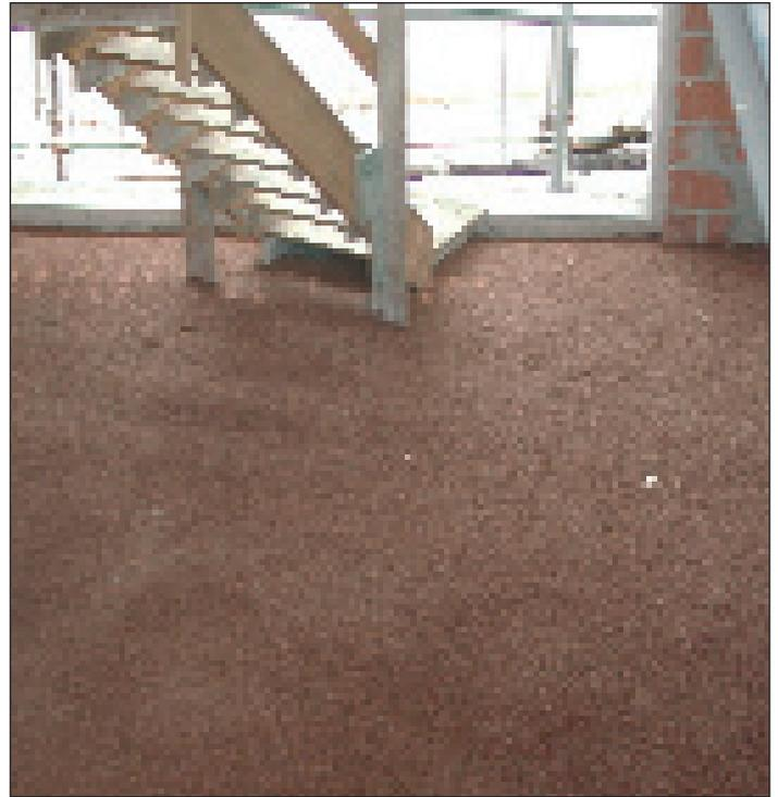
Sottofondo costituito da un impasto di sughero biondo naturale bollito e ventilato SugheroLite con legante vetrificante a presa aerea KoGlass a copertura degli impianti.
