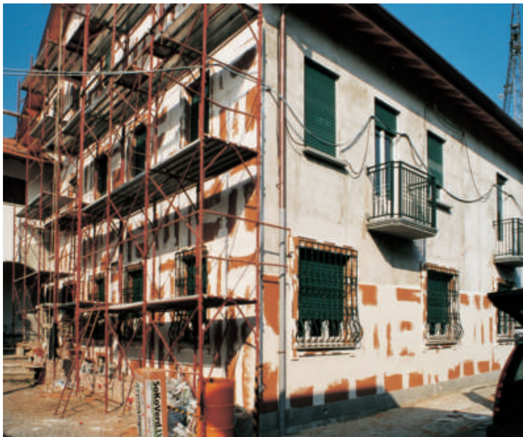
Esecuzione cappotto esterno con pannelli di sughero biondo naturale superkompatto
