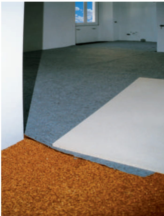
Sottofondo in granuli di sughero biondo naturale bollito e ventilato con vetrificante a presa aerea, posa dello strato separatore anticalpestio e dei pannelli di legno
