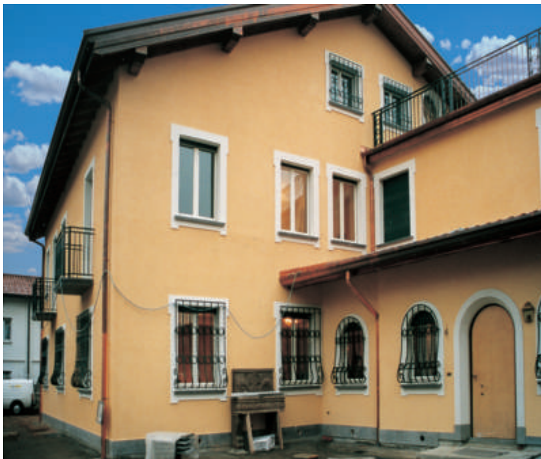
Esecuzione intonaco di finitura ai silicati di potassio su pannelli di sughero biondo naturale superkompatto
