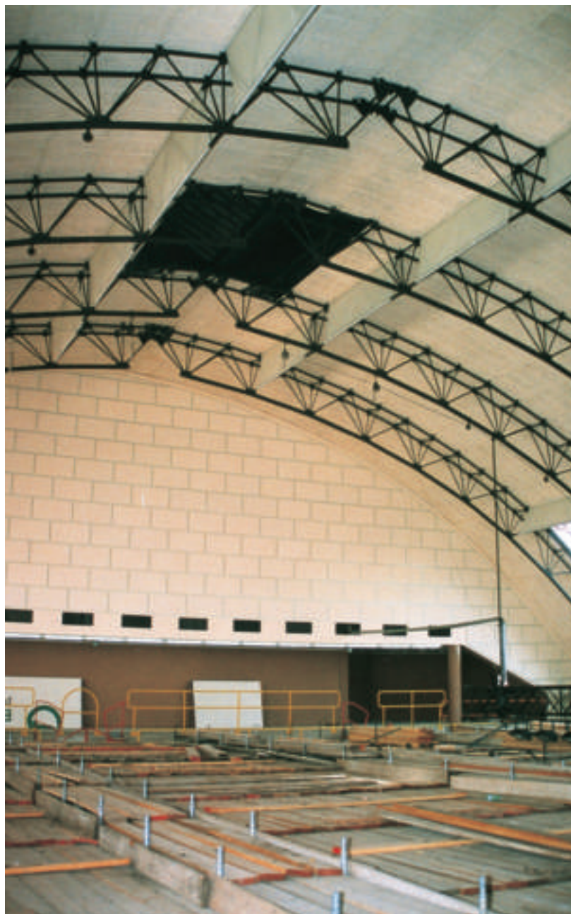
Palalido di Milano. Dettaglio delle 3 tipologie di intervento: soffitto, travi e testate.
