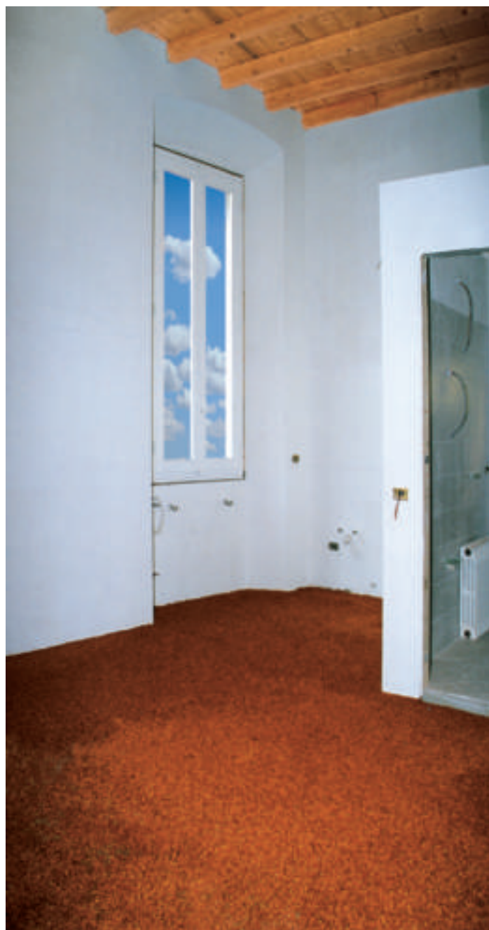
Sottofondo di sughero biondo naturale bollito e ventilato con vetrificante a presa aerea
