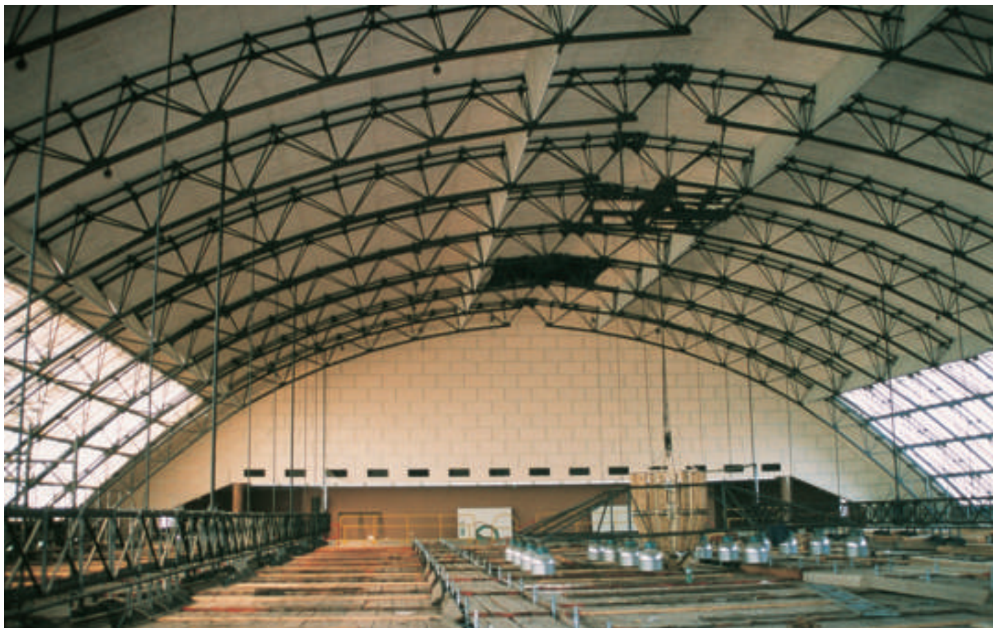
Palalido di Milano. Una fase del nostro intervento di bonifica acustica.
