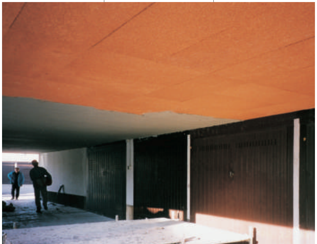
Esecuzione cappotto esterno di un portico con pannelli in sughero biondo naturale superkompacto e intonaco armato di spessoramento
