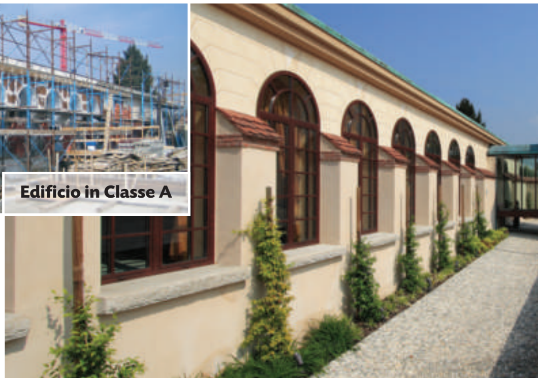
La nuova sede di Coverd: edificio in Classe A. Prima e dopo il rivestimento isolante a cappotto con pannelli di sughero biondo naturale.
