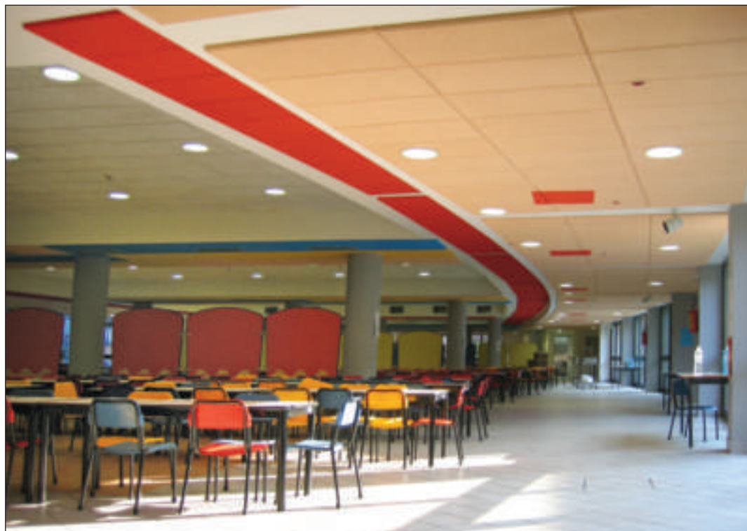
Rivestimento del soffitto con pannelli in sughero biondo preformati e pretinteggiati SoKoVerd.C1. Mensa Centro polifunzionale Bovisio Masciago (MI)
