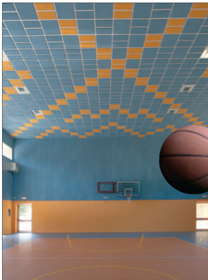
Controsoffitto con pannelli in sughero biondo preformato e pretinteggiato Kontro e rivestimento parziale delle pareti con SoKoVerd.C1. Palestra Via San Faustino Nembro (BG)
