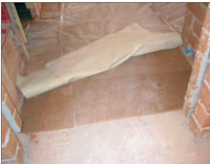
Sottofondo costituito da pannelli in sughero biondo naturale superkompato SoKoVerd.LV a grana fine 2/3mm, particolare di posa dello strato separatore anticalpestio KoSep.L in lana di pecora accoppiato con un foglio di carta politenata e posa degli impianti.
