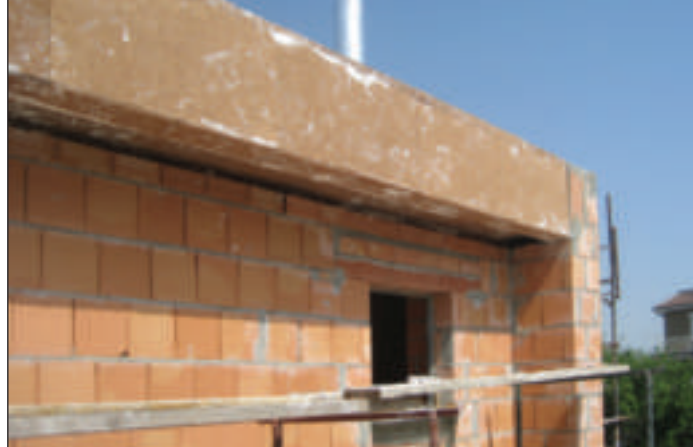
Particolare di rivestimento delle travi in cemento armato con sistema a cappotto costituito da pannelli in sughero biondo naturale superkompatto SoKoVerd.LV a grana fine 2/3mm.
