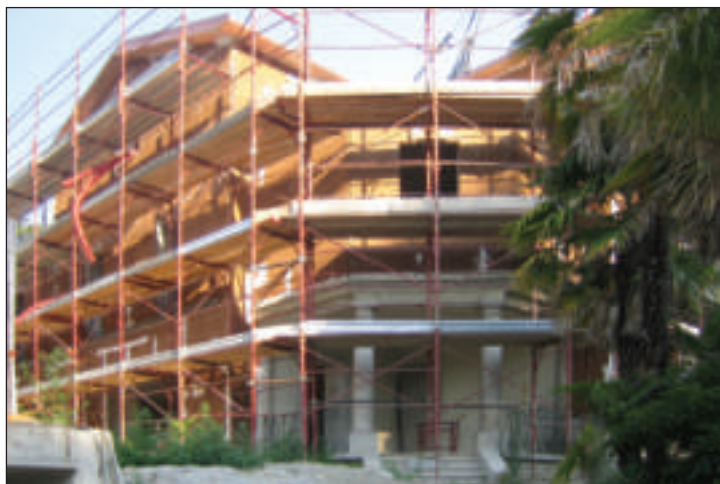
Rivestimento a cappotto esterno con ancoraggio di pannelli in sughero biondo naturale superkompattato SoKoVerd mediante ancorante cementizio PraKov.
