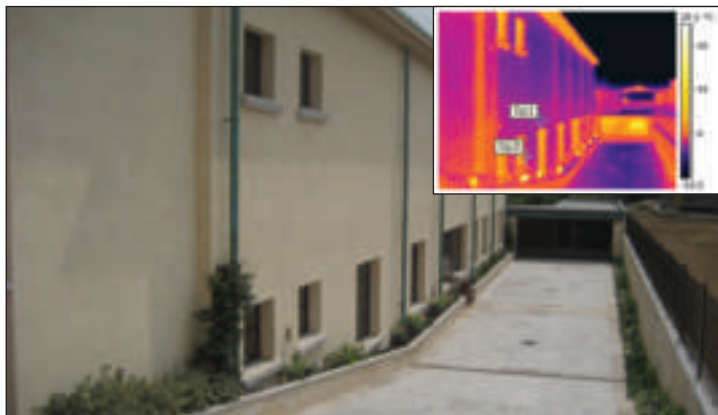
Rilevo termografico con facciata rivestita da cappotto in sughero biondo SoKoVerd.KE. Si nota l'uniformità dell'isolamento con assenza di ponti termici.
