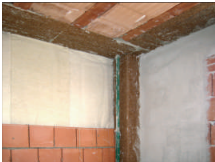
Particolare del getto in controcassero delle travi e pilastri con pannelli in sughero biondo compresso SoKoVerd.AF a grana media 4/8mm e inserimento nell'intercapedine della parete perimetrale di pannelli in lana di pecora LanKot.
