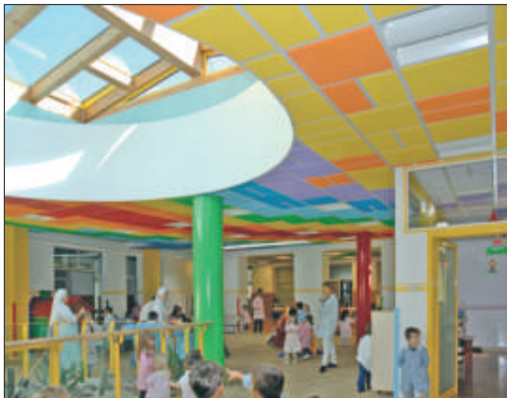
Correzione acustica con controsoffitto in sughero biondo naturale preformato e pretinteggiato Kontro
