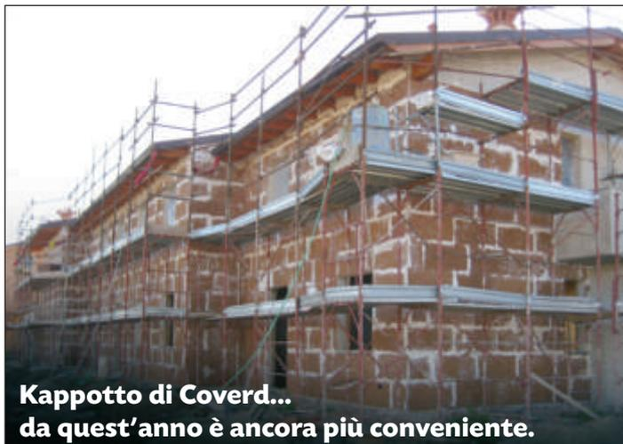
Rivestimento a cappotto esterno SoKoVerd.KE con ancoraggio pannelli in sughero biondo naturale superkompato SoKoVerd.LV a grana fine 2/3mm mediante ancorante cementizio PraKov
