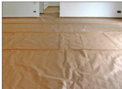
Sottofondo costituito da impasto di sughero biondo naturale bollito e ventilato SugheroLite con legante vetrificante a presa aerea KoGlass a copertura degli impianti. Sopra l'impasto di SugheroLite+KoGlass, posa dello strato separatore anticalpestio KoSep.L in lana di pecora accoppiato con foglio di carta politenata e strisce in sughero KoFlex lungo il perimetro delle pareti.
