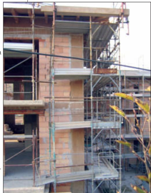
Rivestimento pilastri in c.a. con pannelli in sughero biondo compresso SoKoVerd.AF a grana media 4/8mm
