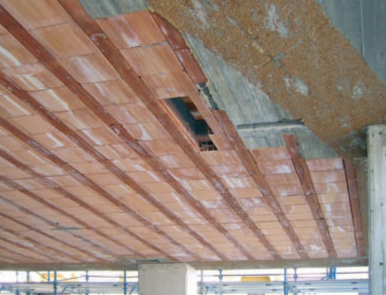
Particolare del getto in controscasso delle travi orizzontali con pannelli in sughero biondo supercompresso SoKoVerd.AF a grana media 4/8mm
