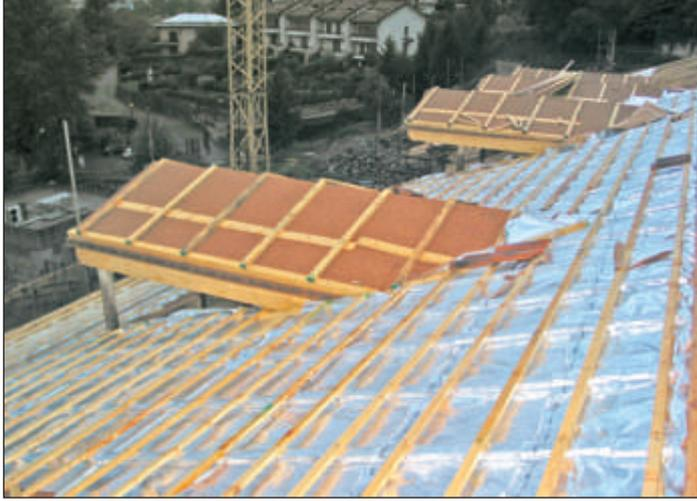
Copertura in legno con posa di carta oleata KoSep.C, doppio strato di pannelli in sughero biondo naturale superkompatto SoKoVerd.LV a grana fine 2/3mm, listellatura per la ventilazione con inserimento dello strato separatore termiriflettente KoSep.A.
