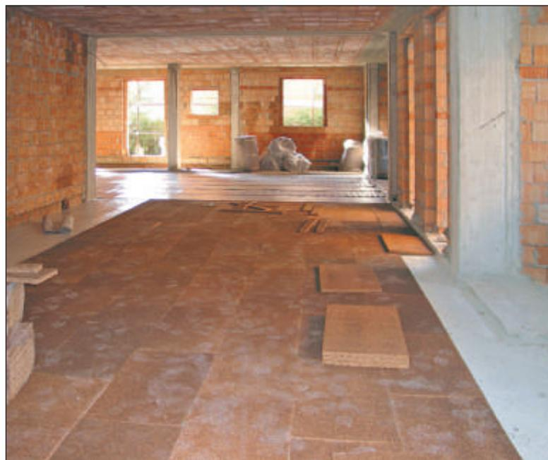
Sottofondo costituito da pannelli in sughero biondo naturale superkompato SoKoVerd.LV a grana fine 2/3mm. Stesura di strato separatore anticalpestio KoSep.F ed esecuzione degli impianti.
