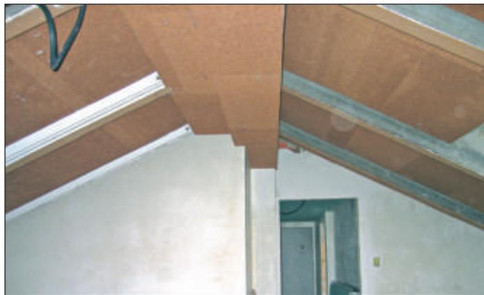
Sottotetto con struttura in tavelloni e travetti prefabbricati. Cappotto interno SoKoVerd.KI con ancoraggio pannelli in sughero biondo naturale superkompatto SoKoVerd.LV a grana fine 2/3mm sui tavelloni e pannelli in sughero biondo naturale supercompresso KoFlex sui travetti mediante ancorante cementizio PraKov.
