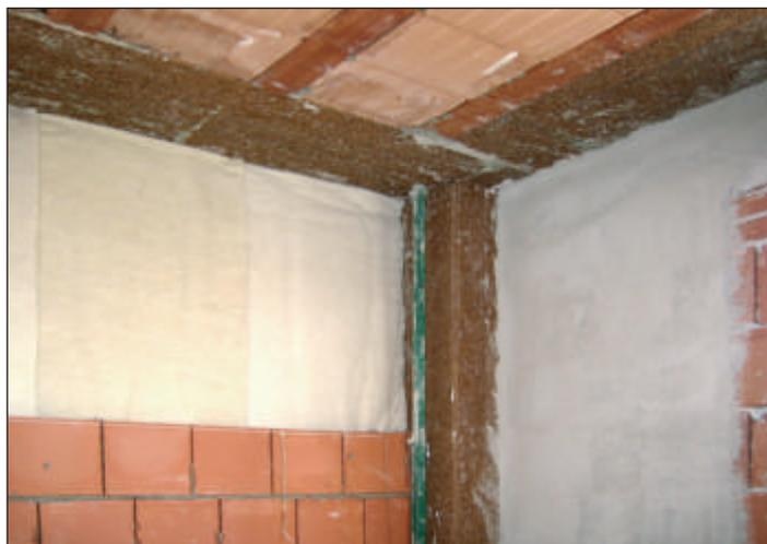
Particolare del getto in controscasso delle travi e pilastri con pannelli in sughero biondo compresso SoKoVerd.AF a grana media 4/8mm e inserimento nell'intercapedine delle pareti perimetrali di pannelli di lana di pecora LanKot.
