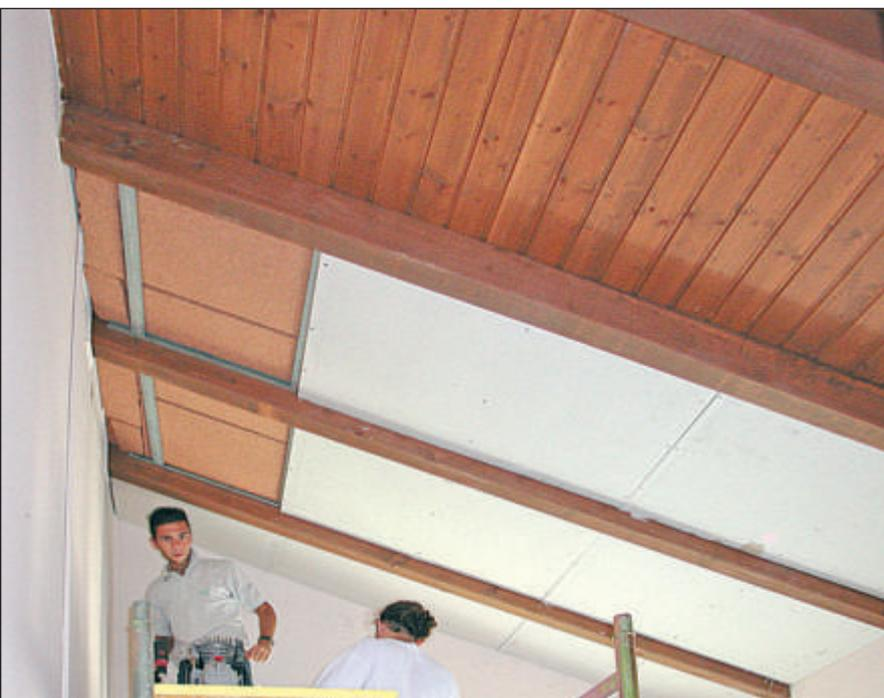
Sottotetto con struttura in legno. Posa di doppio pannello in sughero biondo naturale superkompatto SoKoVerd.LV a grana fine 2/3mm e finitura in cartongesso e perline.
