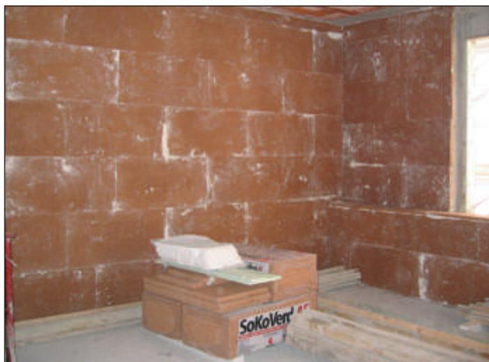
Rivestimento a cappotto interno SoKoVerd.KI con ancoraggio pannelli in sughero biondo naturale superkompato SoKoVerd.LV a grana fine 2/3mm mediante ancorante cementizio PraKov
