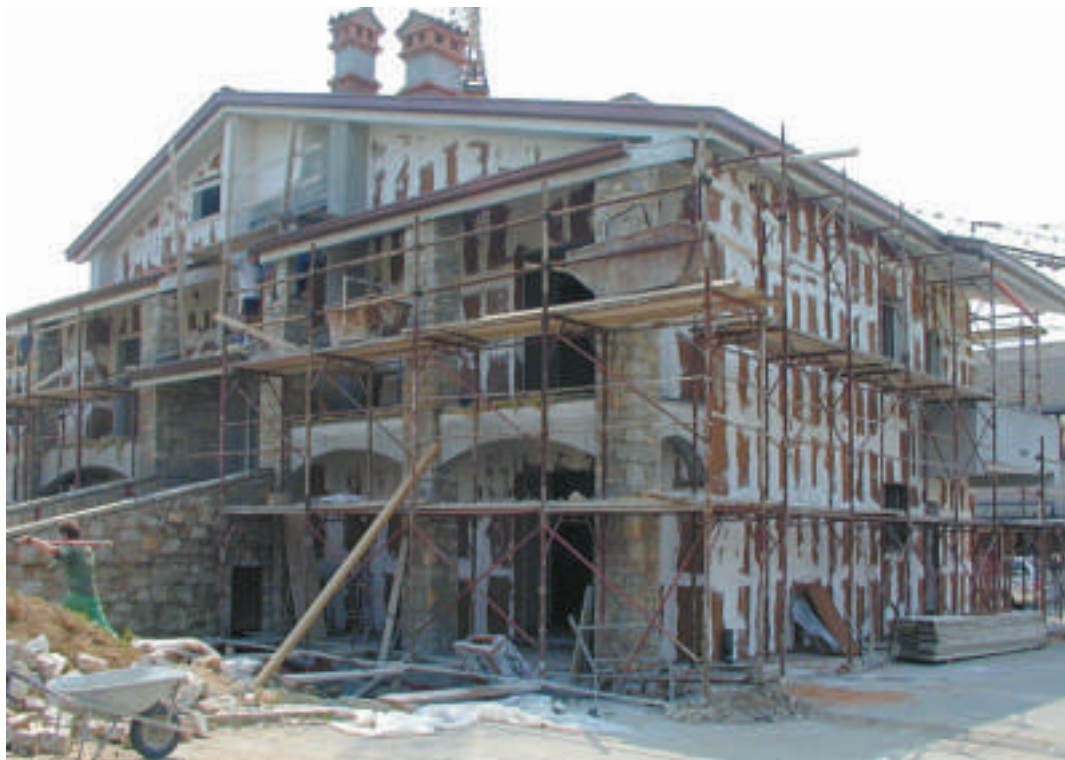
Esecuzione cappotto esterno con pannelli di sughero biondo naturale superkompatto
