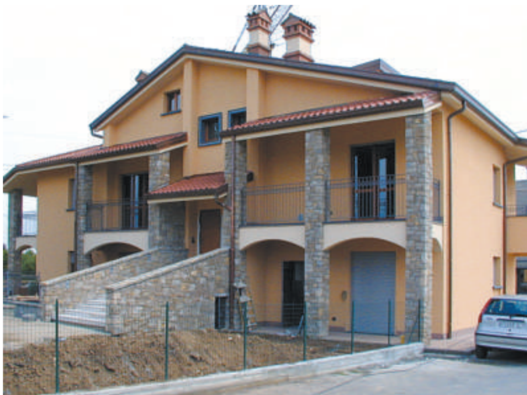
Esecuzione di intonaco di finitura colorata
