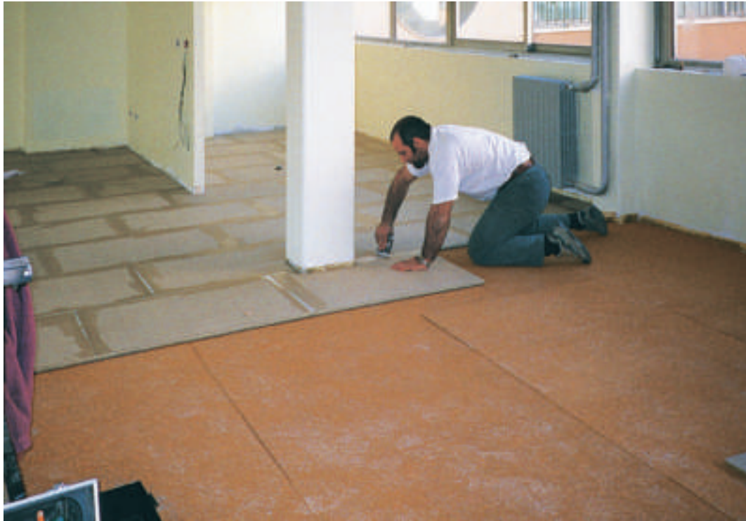
Fase di esecuzione del piano in legno sopra i pannelli di sughero biondo superkompato.
