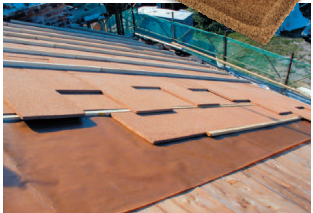
Tetto bioedile del Mulino dell'Abbazia di Chiaravalle (Mi). Progetto: architetto Silvio Fiorillo. Posa di carta oleata sopra l'assito in legno e doppio strato di pannelli in sughero biondo naturale superkompato.
