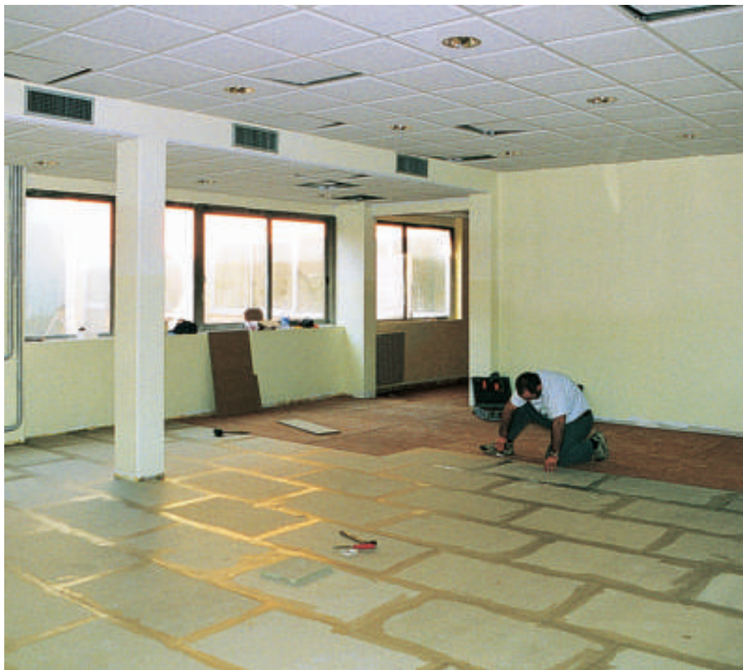
Realizzazione di sottofondo con pannelli di sughero al di sopra dei quali sono stati posati dei pannelli in legno idrofugo. Da notare inoltre il controsoffitto in sughero
