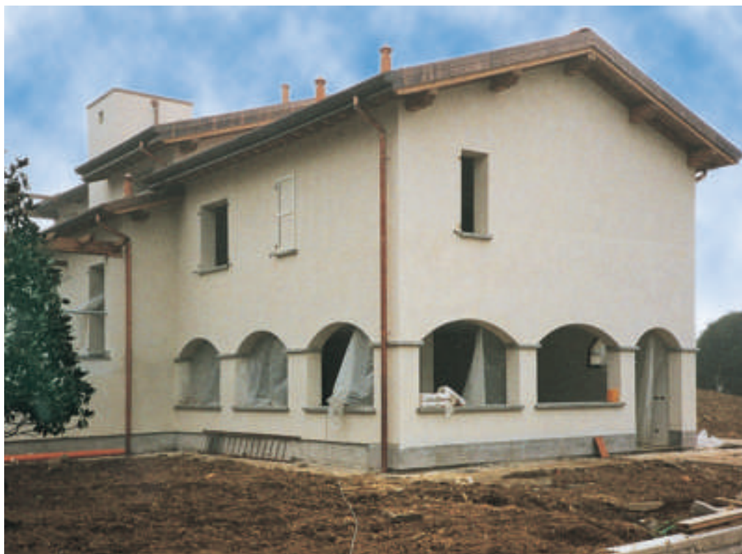
Esecuzione di intonaco di finitura colorata
