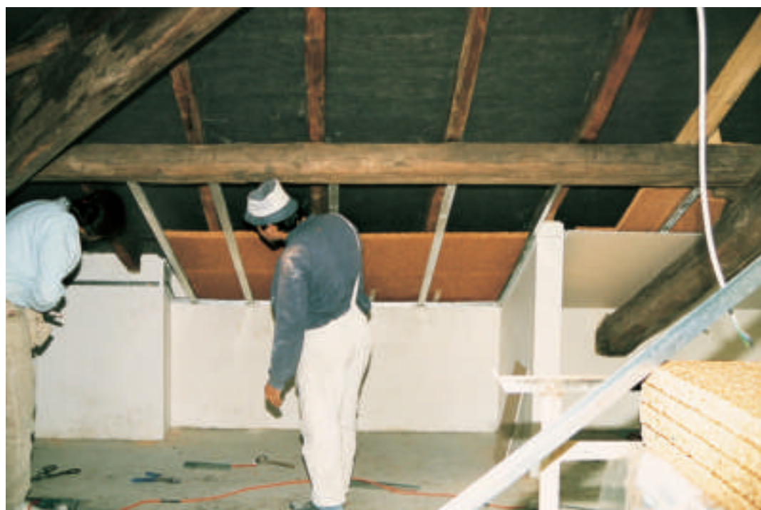
Posa struttura portante in legno di pannelli in sughero biondo naturale superkompattato SoKoverd LV con finitura di lastre in cartongesso
