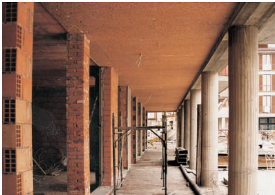
Esecuzione cappotto esterno di un portico con pannelli in sughero biondo naturale superkompato
