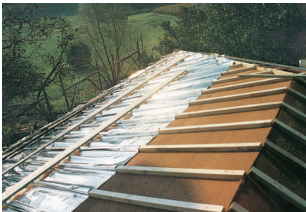
Posa di pannelli in sughero biondo naturale superkompato SoKoverd LV e carta alluminata termoriflettente
