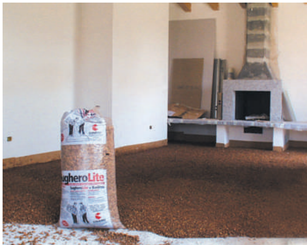
Sottofondo di sughero biondo naturale bollito e ventilato con vetrificante a presa aerea completo di strisce in sughero supercompresso lungo il perimetro del locale.
