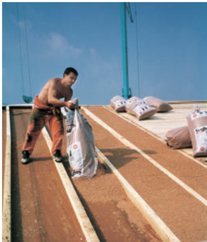
Stesura di sughero naturale biondo in granuli Sugherolite costante sopra lo strato separatore di carta oleata KoSep C. Tetto Baiken della Serteco di Cozzi G. & C. Nerviano (MI)
